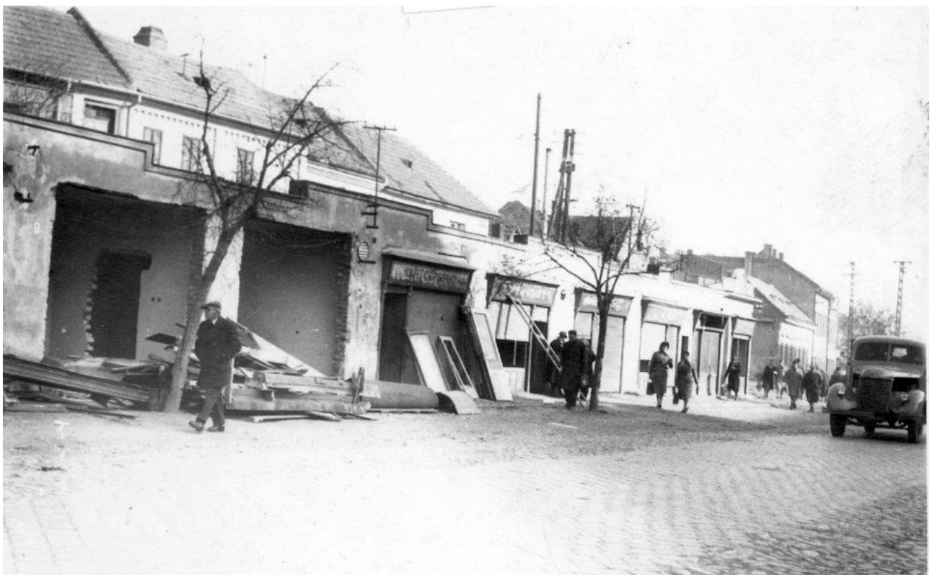
54. Pohľad od ulice Štúrova na asanovanú časť Tabáň, posledné zábery na zástavbu (sektor A)
