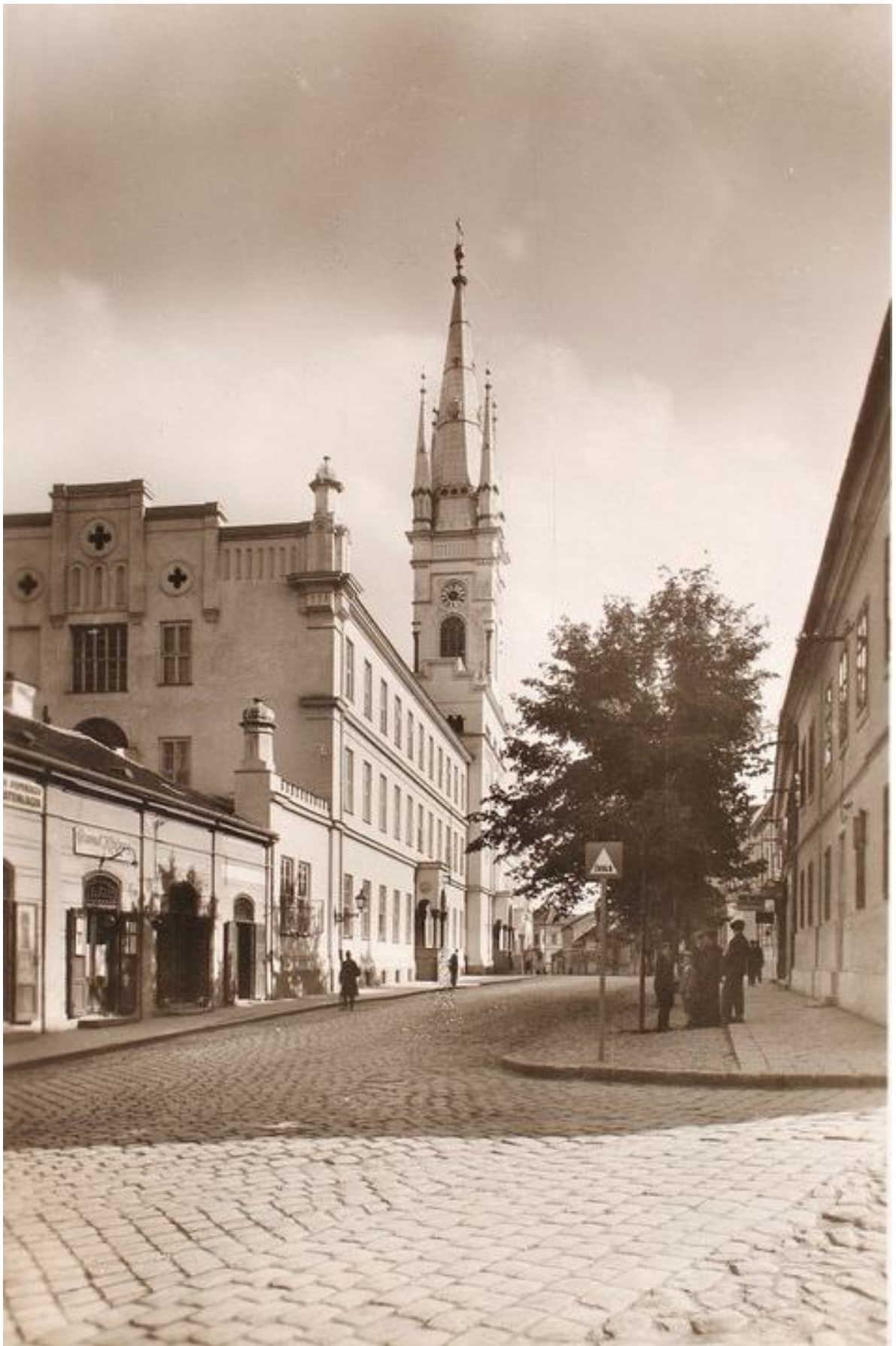
21. Pohľad do dnešnej ulice Farská od severu, po nadstavbe bočných krídiel kláštora milosrdných sestier a pred asanáciou susedného domu (sektor A)
