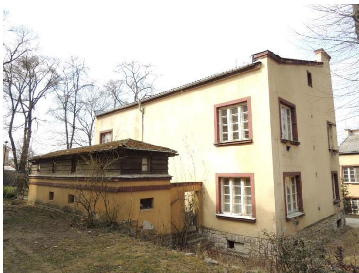
pohľad na južnú a východnú fasádu
