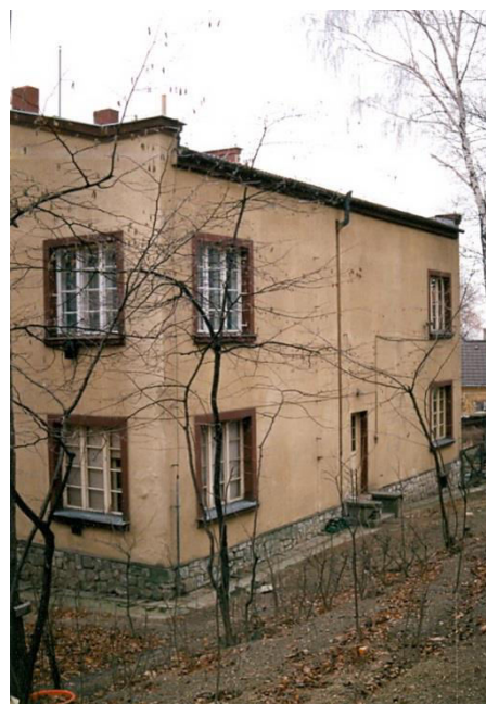
pohľad na dvorovú fasádu
