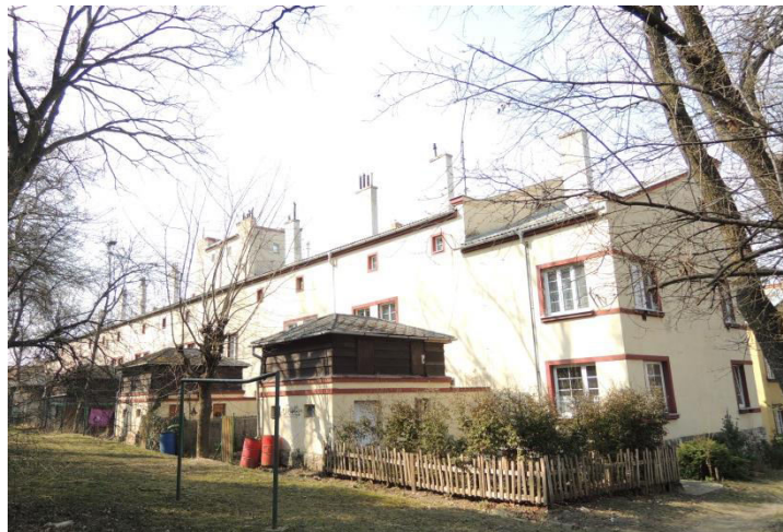
pohľad na južnú a východnú fasádu
