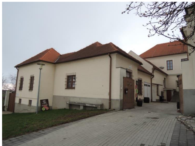
dvorová fasáda severného krídla
