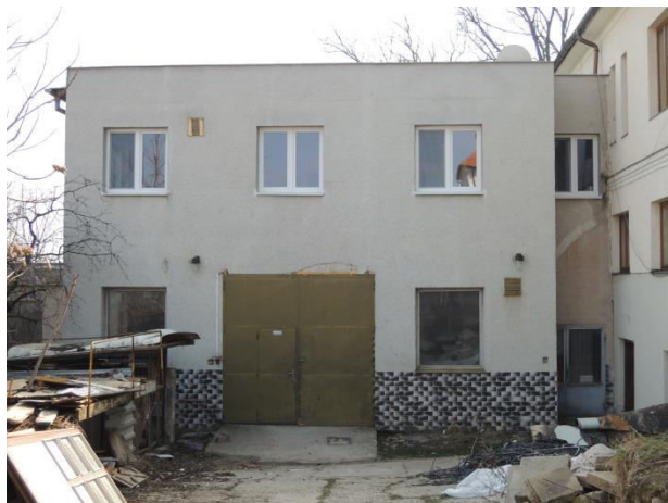
pohľad na dvorovú fasádu
