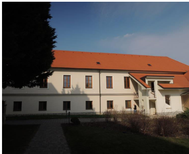
dvorová fasáda južného krídla kláštora
