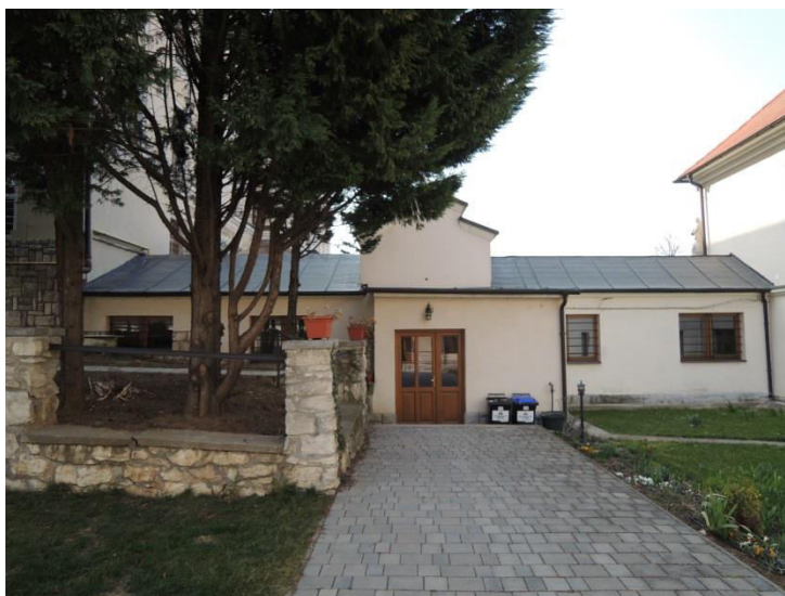
pohľad na dvorovú fasádu
