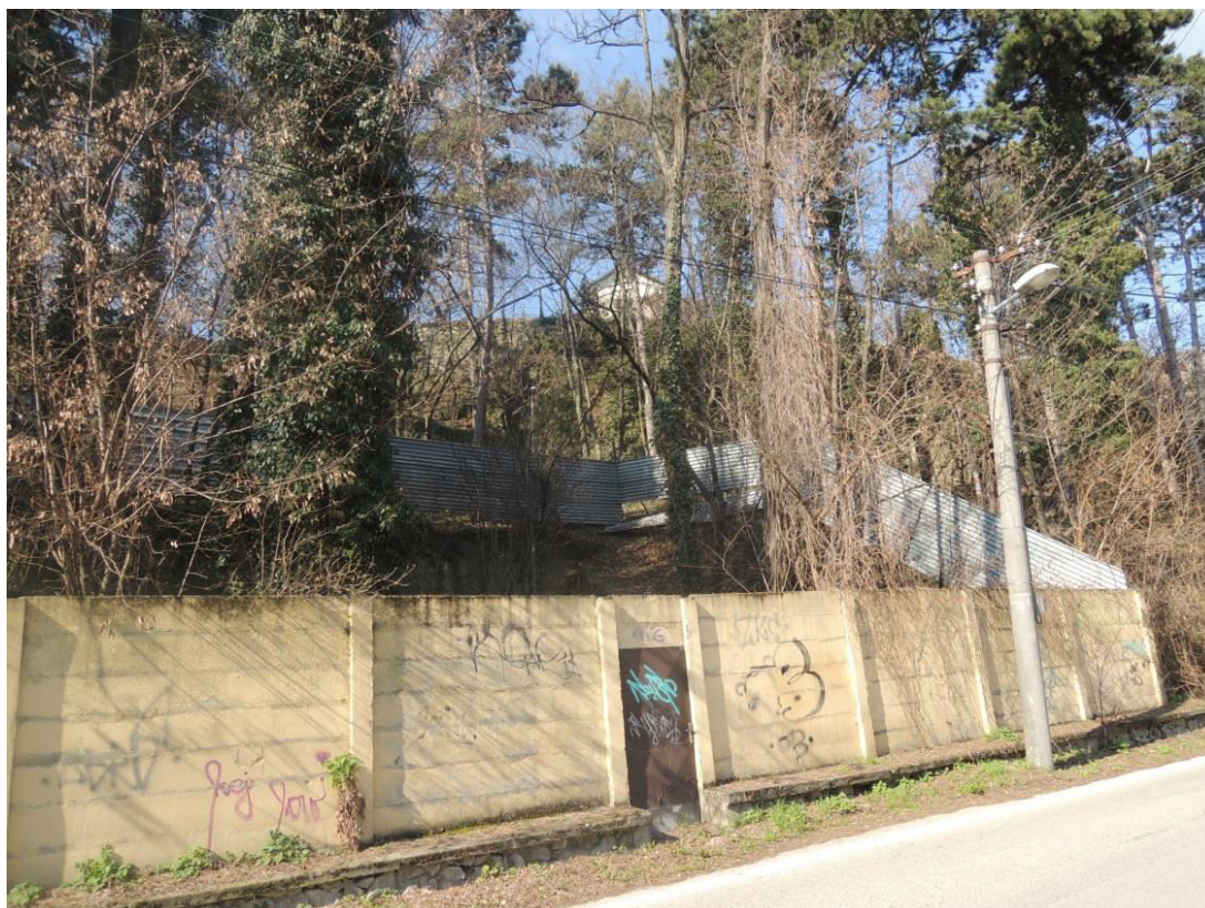
čelný pohľad na CO kryt
