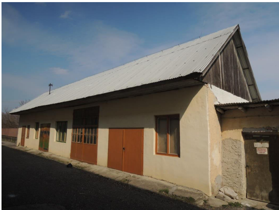
pohľad na dvorovú fasádu
