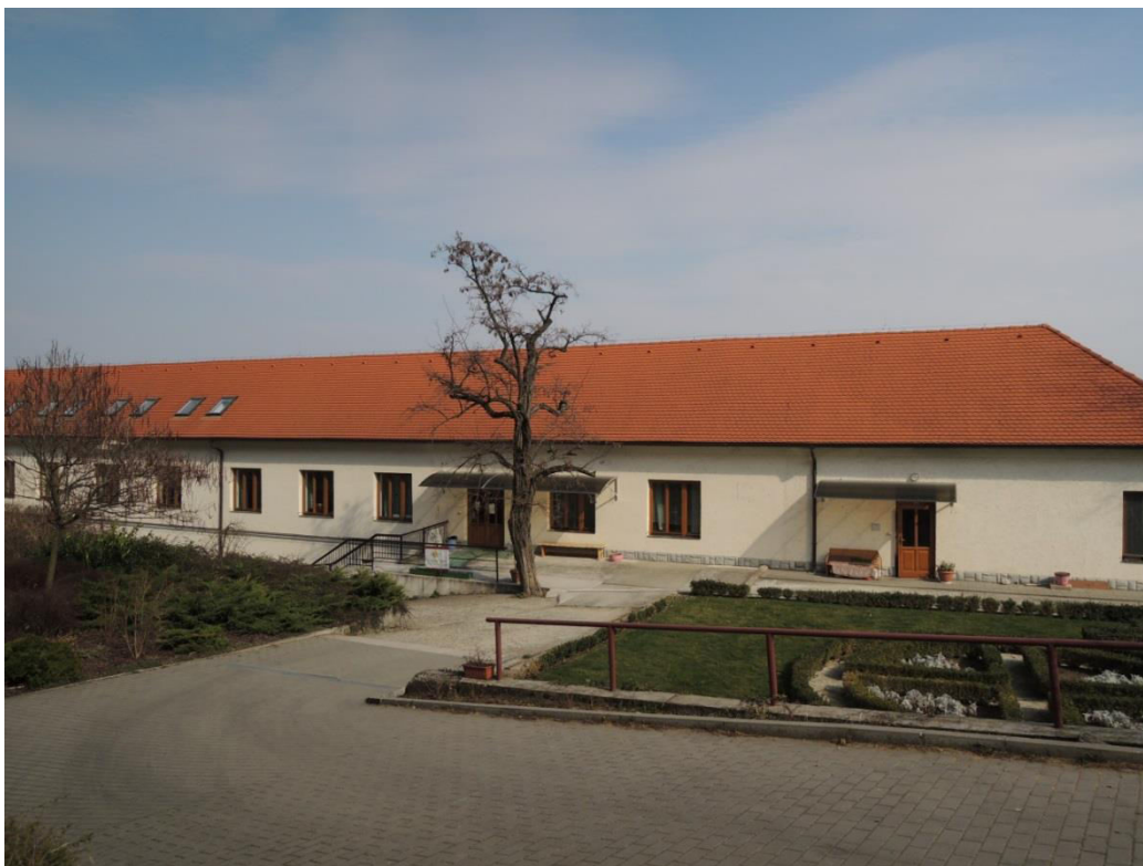
dvorová fasáda južného krídla kláštora
