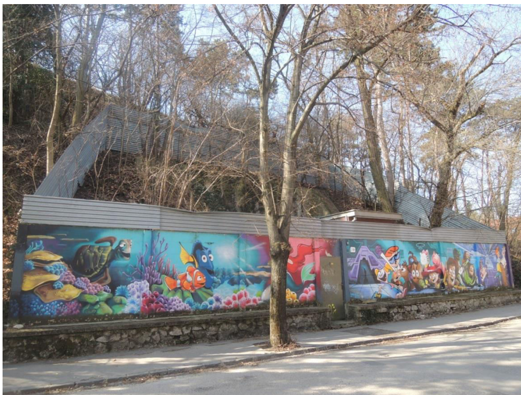
čelný pohľad na CO kryt
