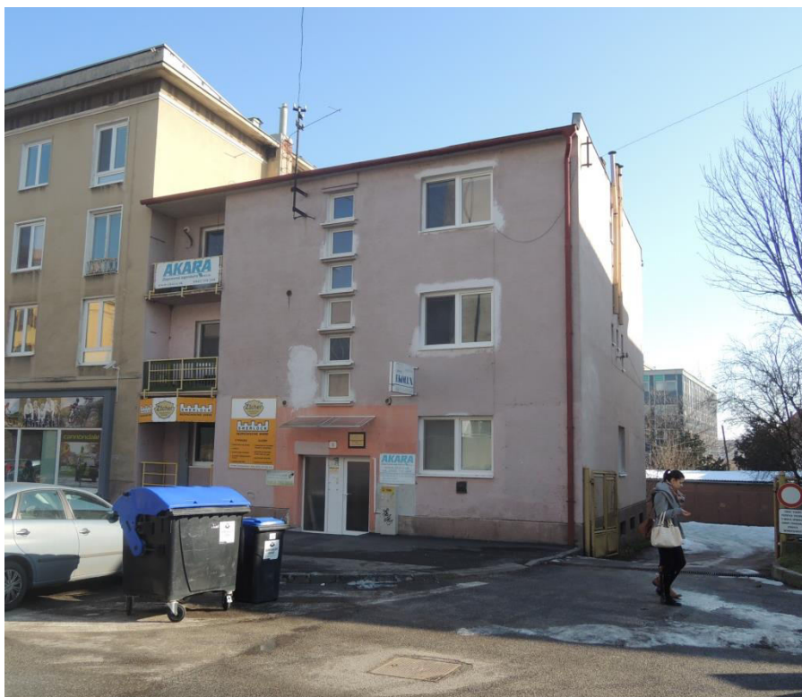
pohľad na uličnú fasádu
