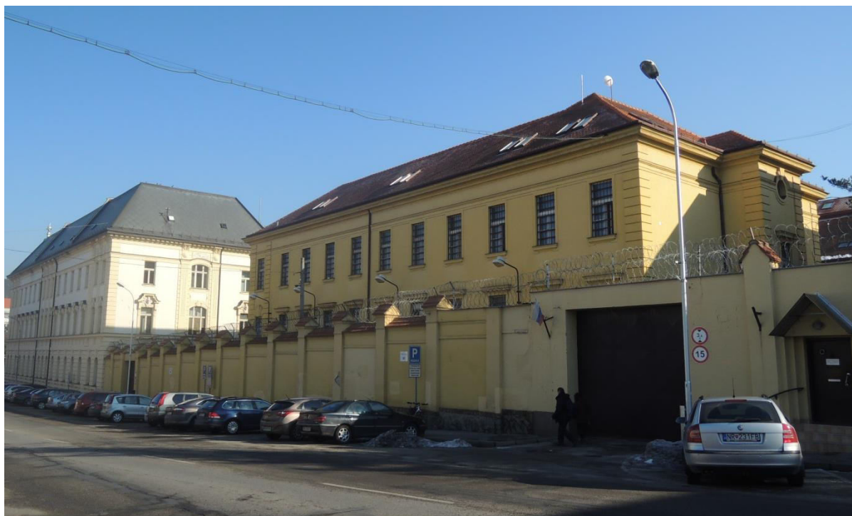
pohľad na uličnú fasádu
