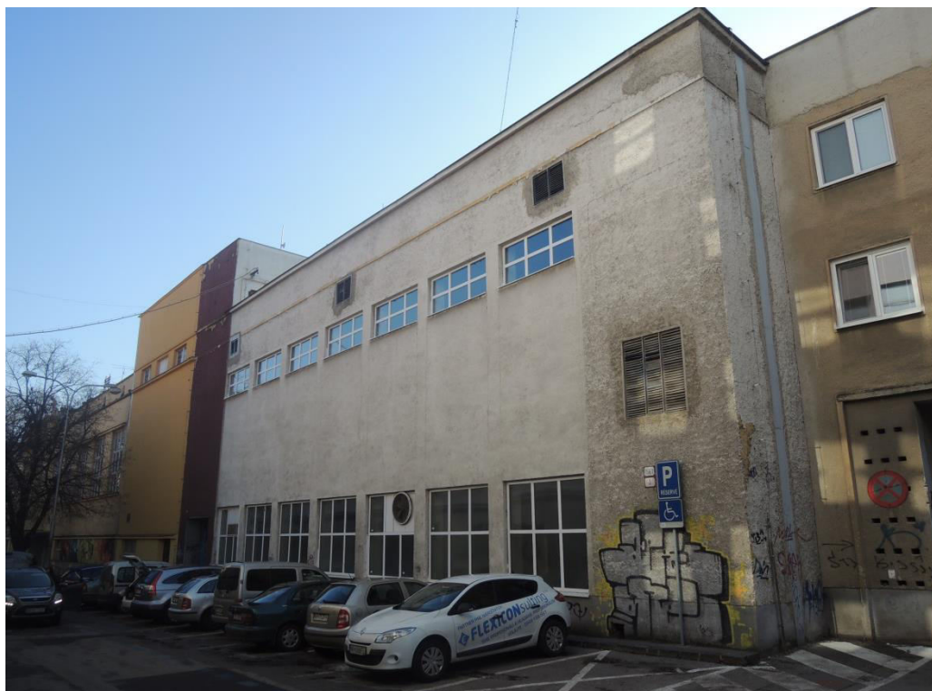
pohľad na uličnú fasádu
