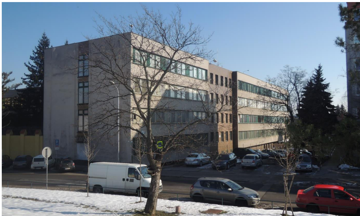
pohľad na uličnú fasádu
