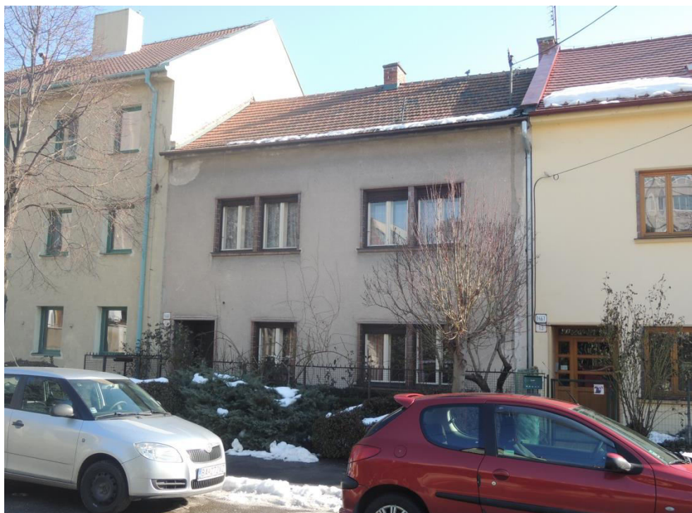
pohľad na uličnú fasádu
