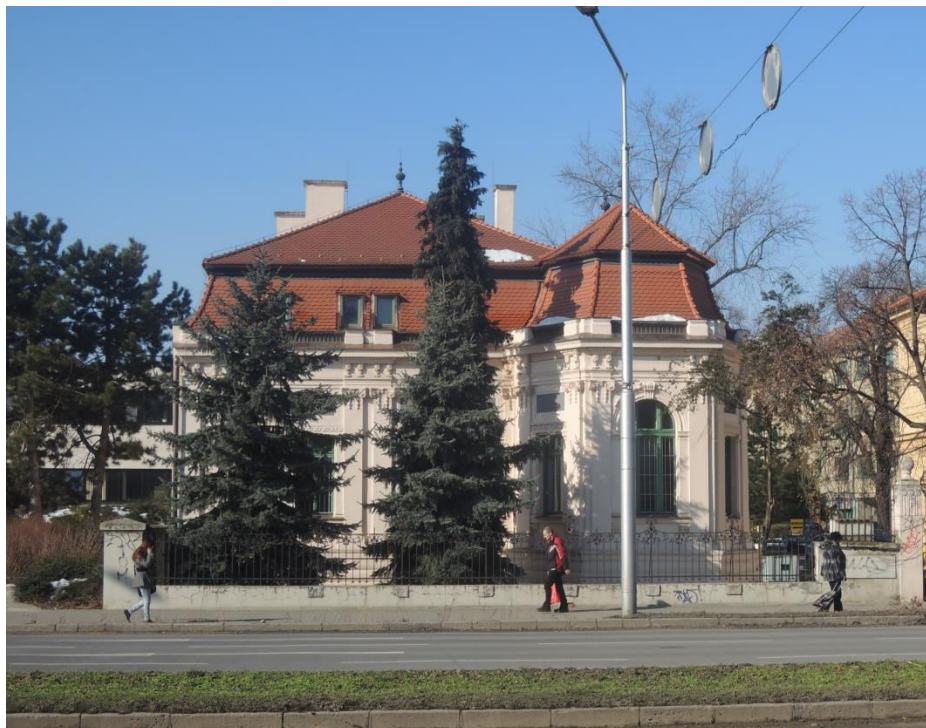
pohľad na uličnú fasádu
