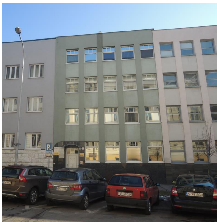
pohľad na uličnú fasádu
