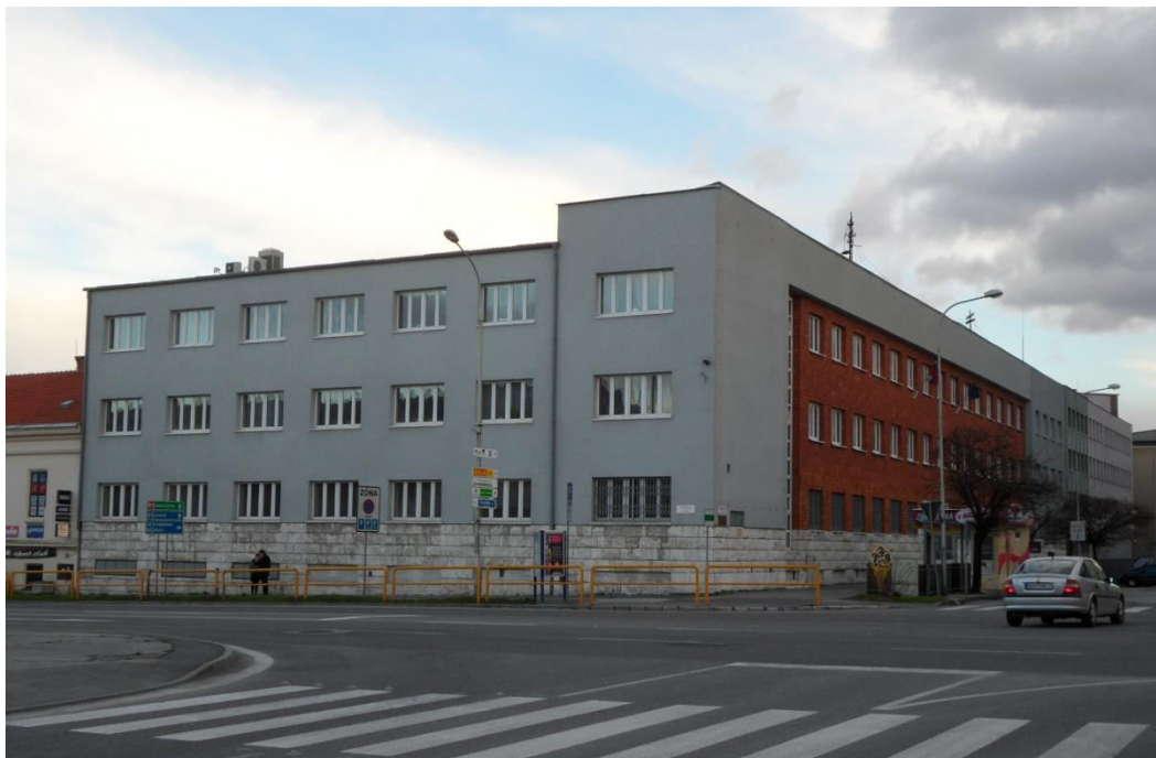
pohľad na uličnú fasádu
