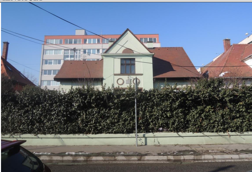
pohľad na uličnú fasádu
