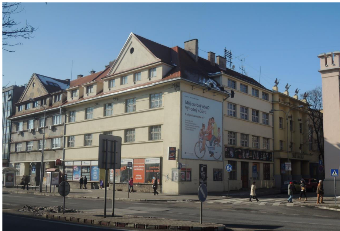
pohľad na uličnú fasádu
