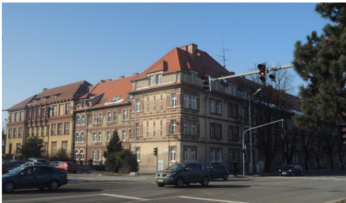
pohľad na uličnú fasádu
