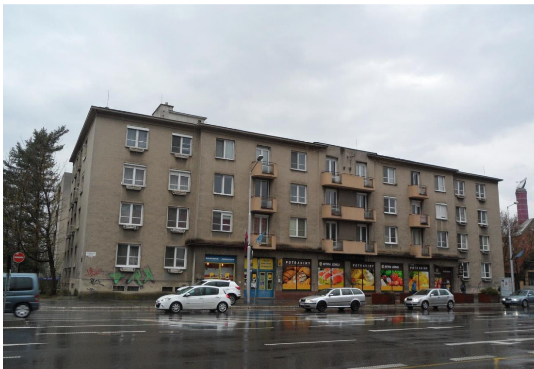
pohľad na uličnú fasádu
