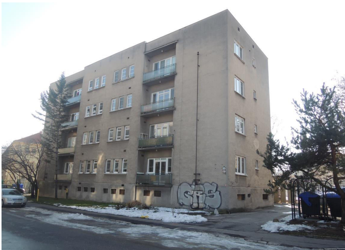
pohľad na uličnú fasádu
