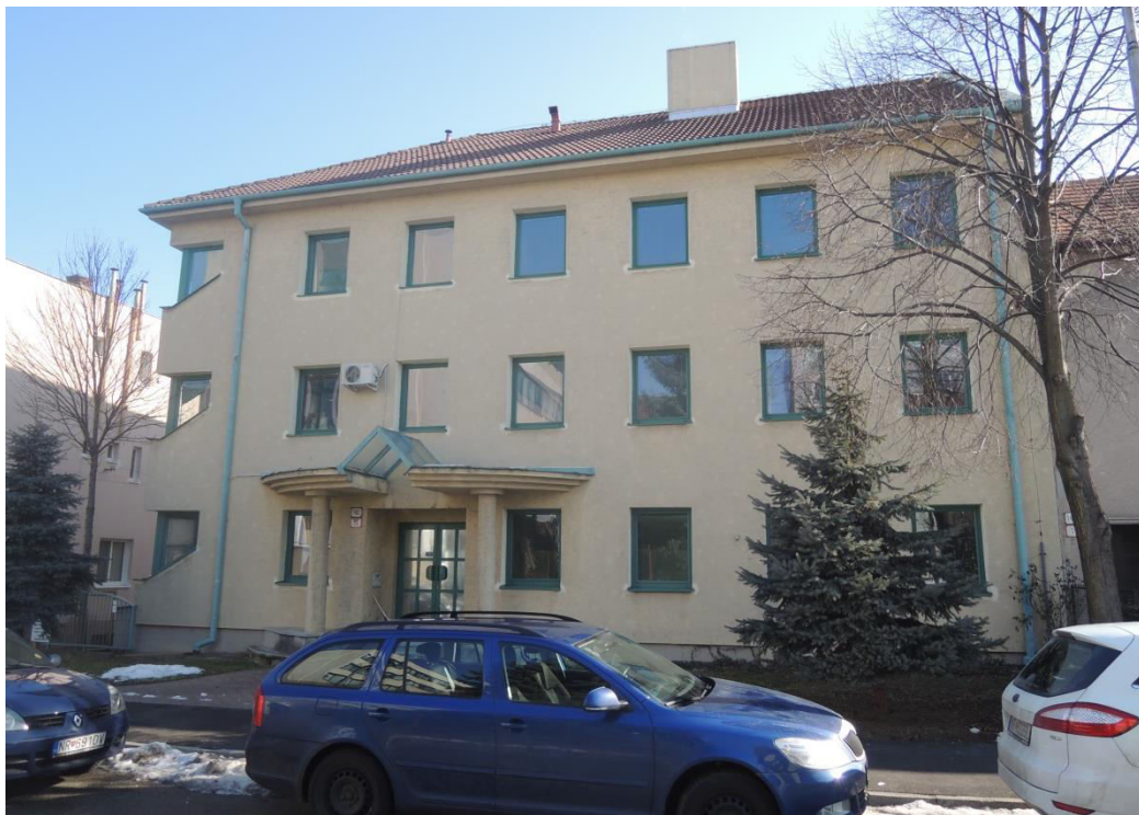
pohľad na uličnú fasádu
