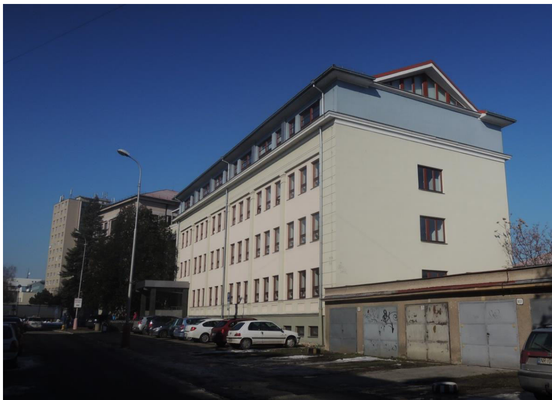
pohľad na uličnú fasádu
