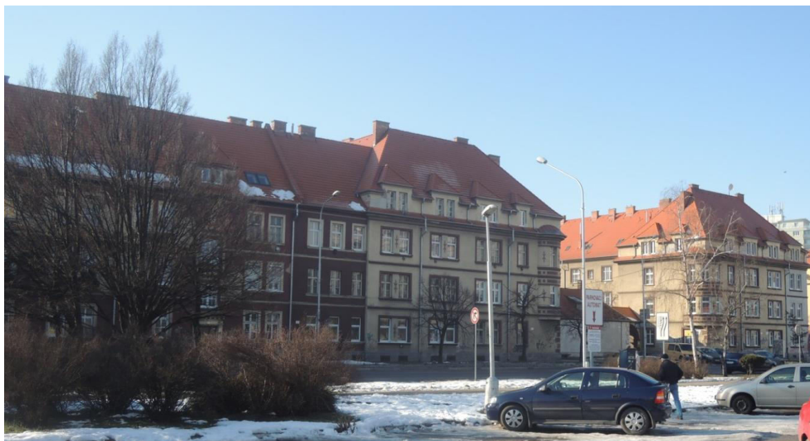
pohľad na uličnú fasádu
