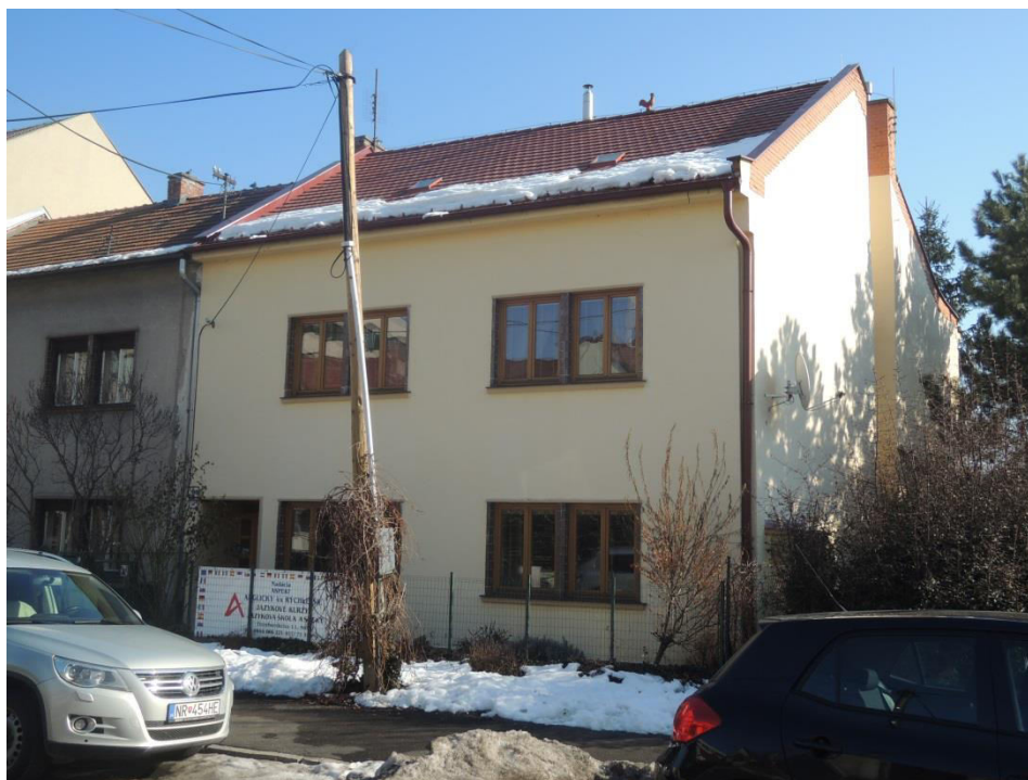
pohľad na uličnú fasádu
