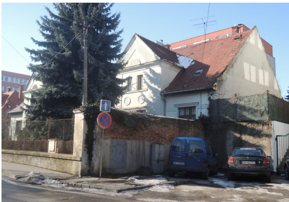
pohľad na uličnú fasádu
