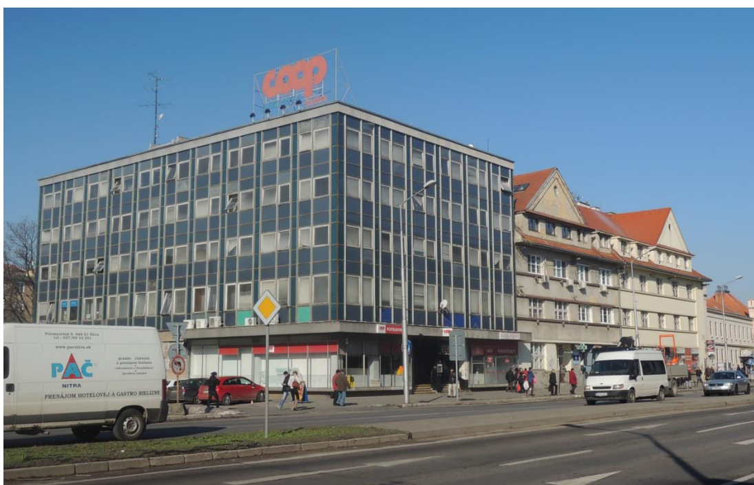
pohľad na uličnú fasádu
