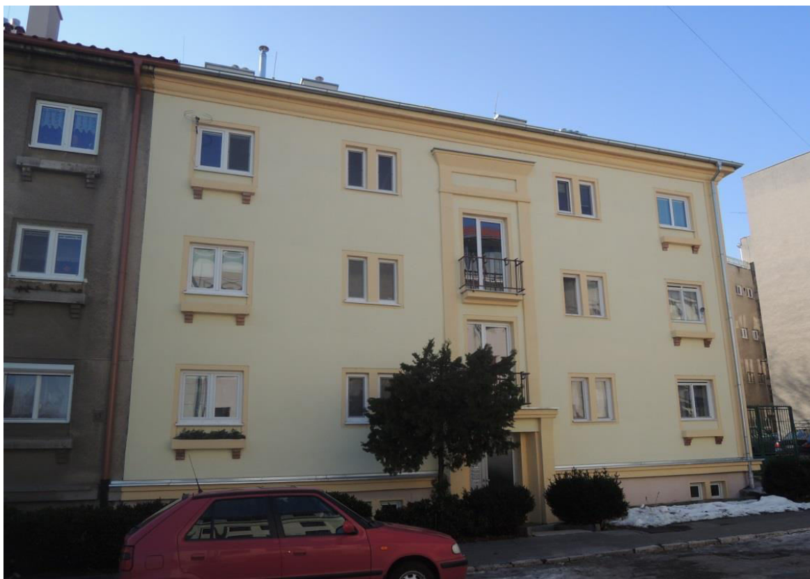
pohľad na uličnú fasádu
