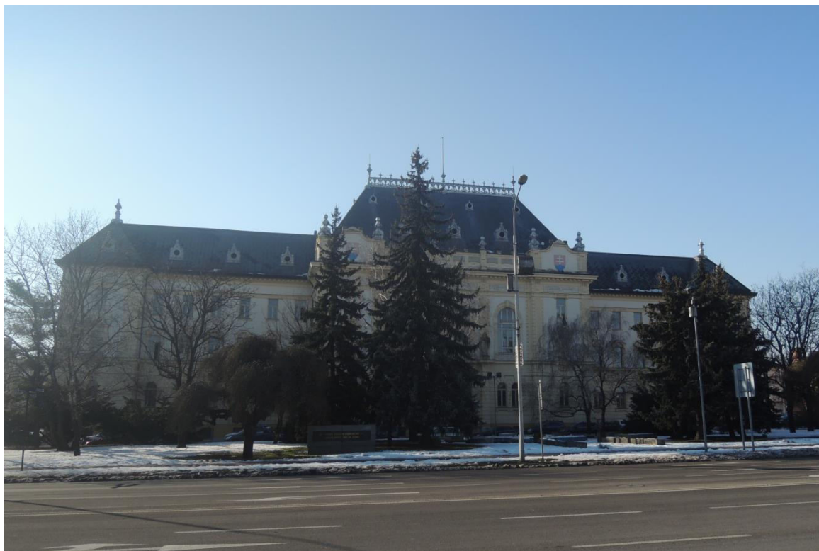
pohľad na uličnú fasádu
