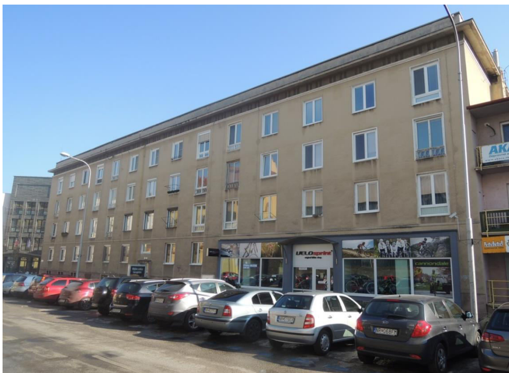
pohľad na uličnú fasádu
