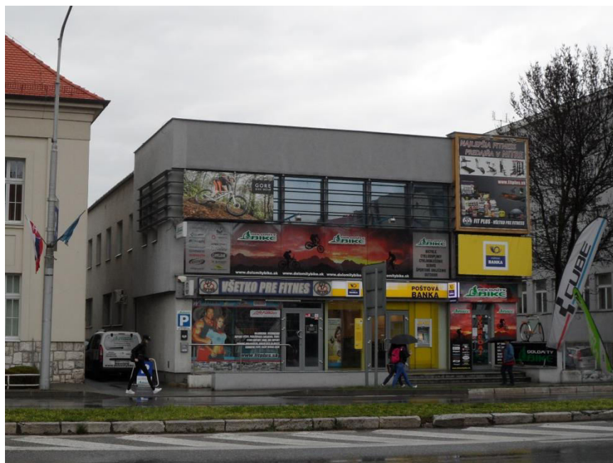
pohľad na uličnú fasádu
