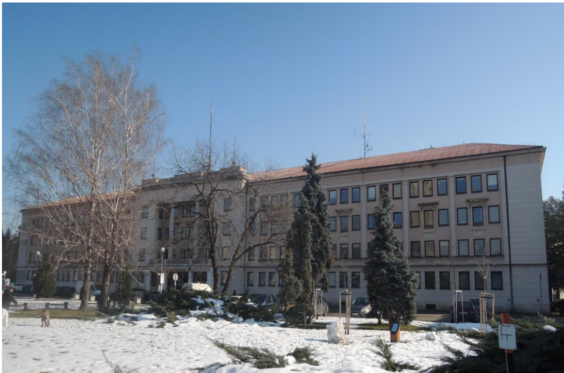
pohľad na uličnú fasádu
