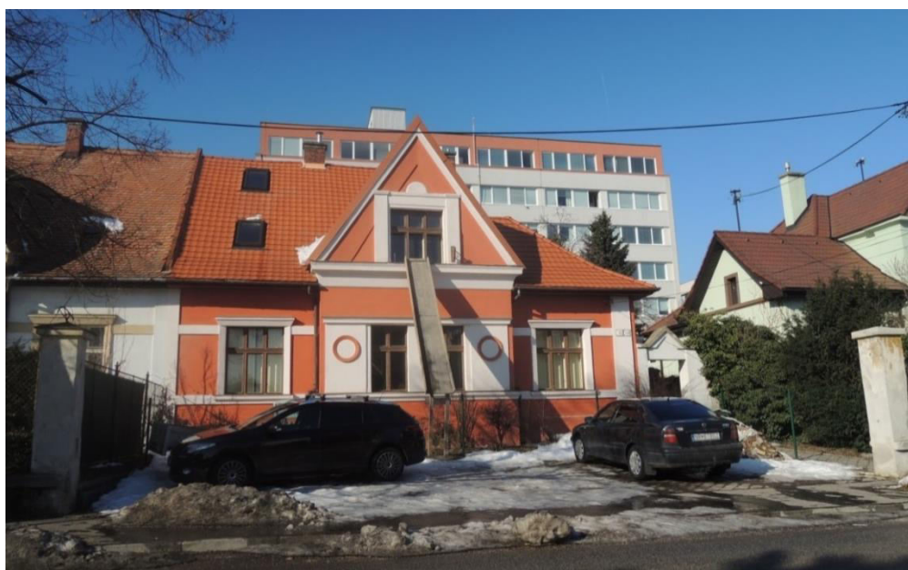
pohľad na uličnú fasádu
