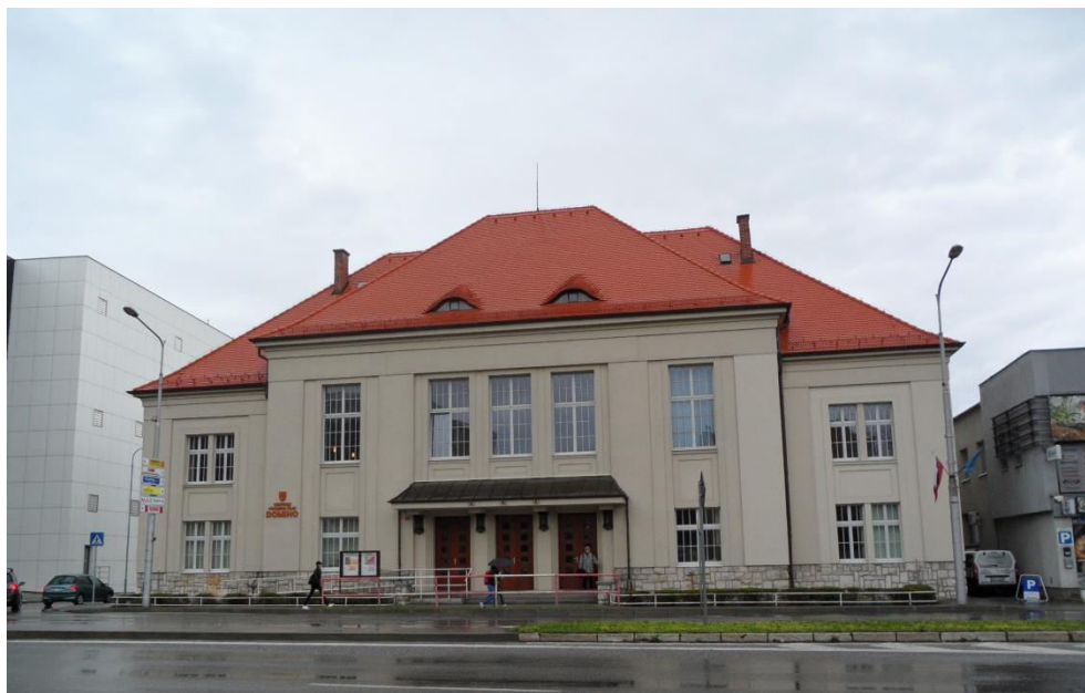
pohľad na uličnú fasádu
