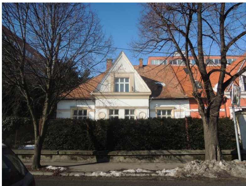
pohľad na uličnú fasádu
