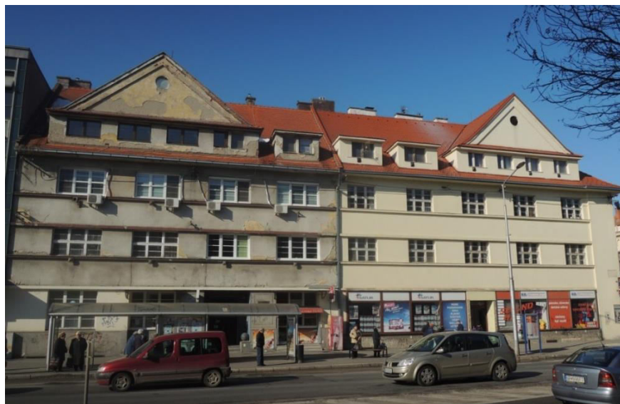
pohľad na uličnú fasádu
