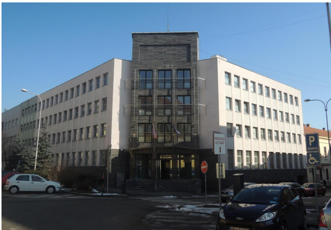
pohľad na uličnú fasádu
