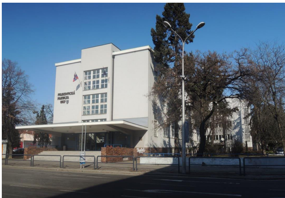
pohľad na uličnú fasádu
