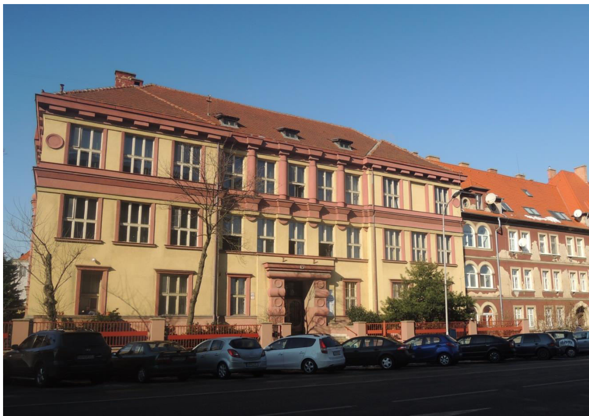
pohľad na uličnú fasádu
