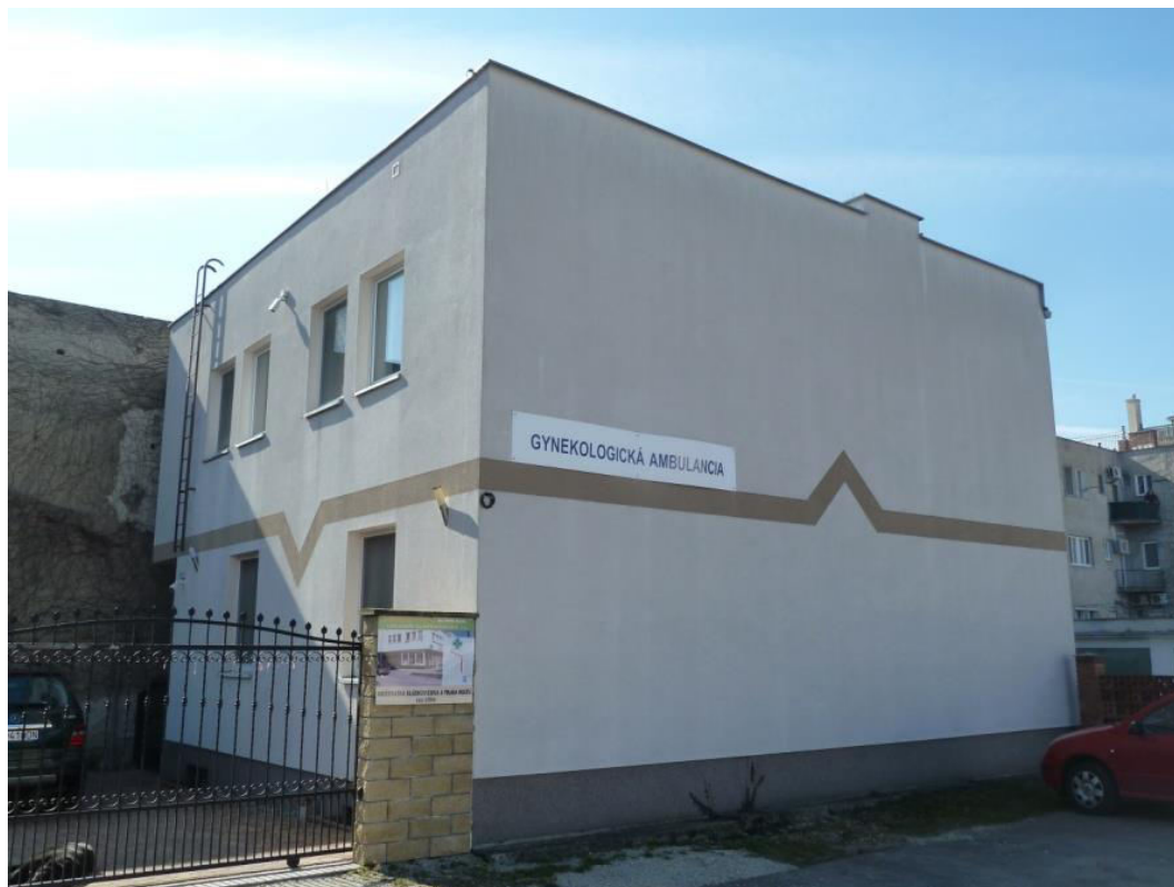
pohľad na dvorovú fasádu
