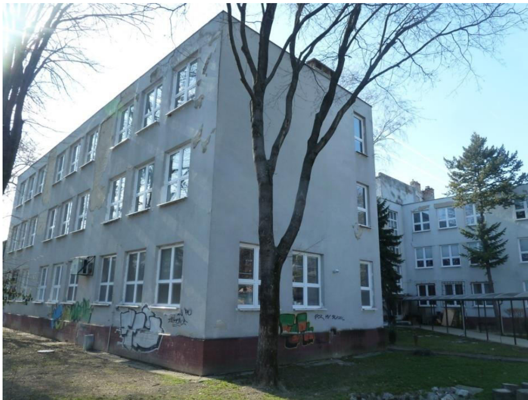
pohľad na bočnú fasádu
