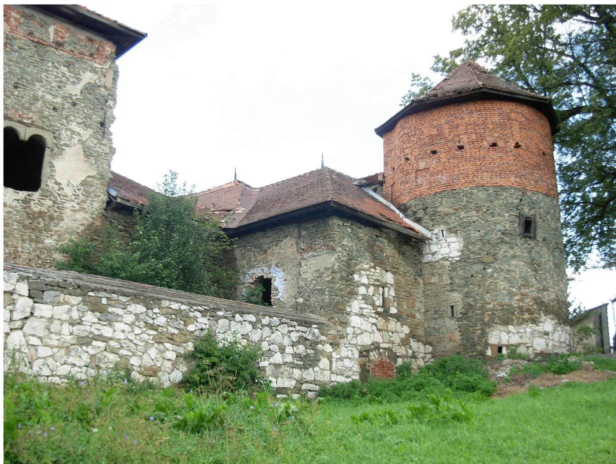
HRAD , Podhradová ulica č. 9, č. ÚZPF 670/0
