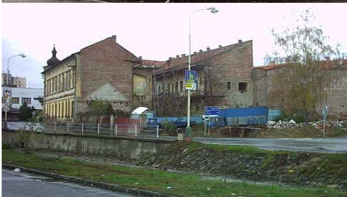
Lučenec - pohľad z pravého brehu Tuhárskeho potoka na časť ulice pri križovatke s Vajanského ulicou
