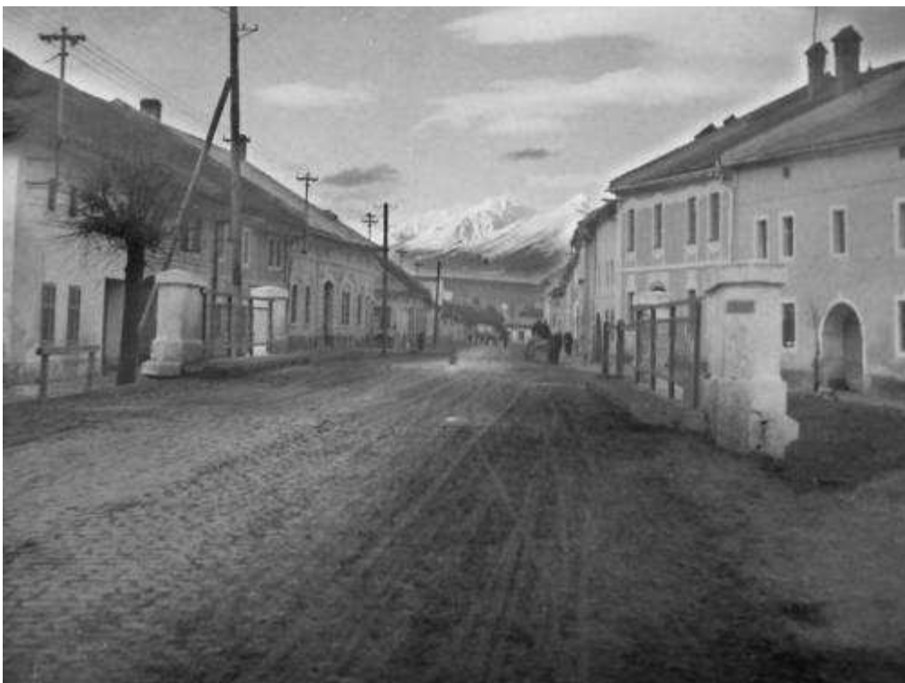
42. zástavba západnej časti Ul. gen. Svobodu a Bernolákovej ulice pri moste cez potok Ľubička v roku 1957 (zdroj: Archív Pamiatkového úradu SR, fotografia z Ľubica, Ľubické kúpele, arch. č. Z 2150)
