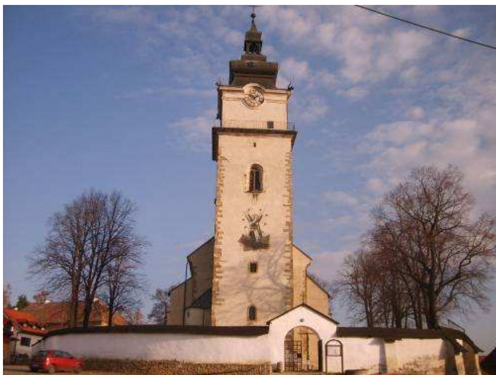
10. pohľad P4 v interiéri pamiatkového územia na areál rímskokatolíckeho farského Kostola Nanebovzatia Panny Márie, v pozadí objekty novej aj starej fary
