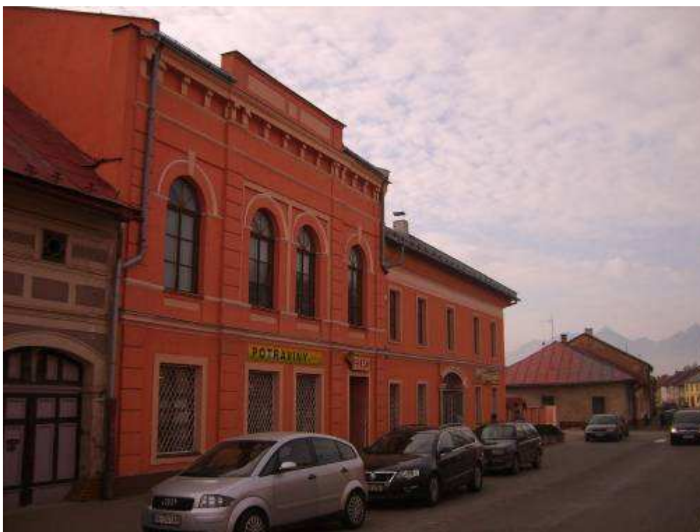
33. časť zástavby južnej strany Ul. gen. Svobodu s prielukou po asanovaných objektoch
