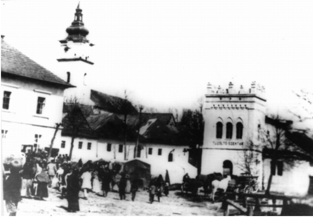
27. priestor pri požiarnej zbrojnici v roku 1935 (maďarský nápis na zbrojnici datovanie spochybňuje, môže ísť o fotografiu spred roku 1914) (zdroj: Archív Pamiatkového úradu SR, č. negatívu 21749)
