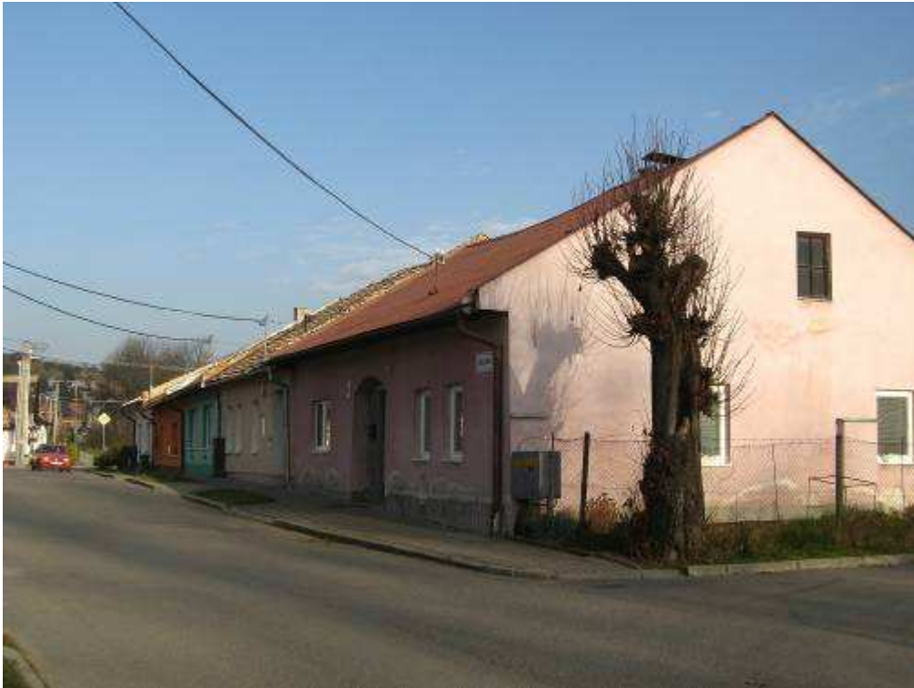
49. severná časť zástavby východnej strany Bernolákovej ulice
