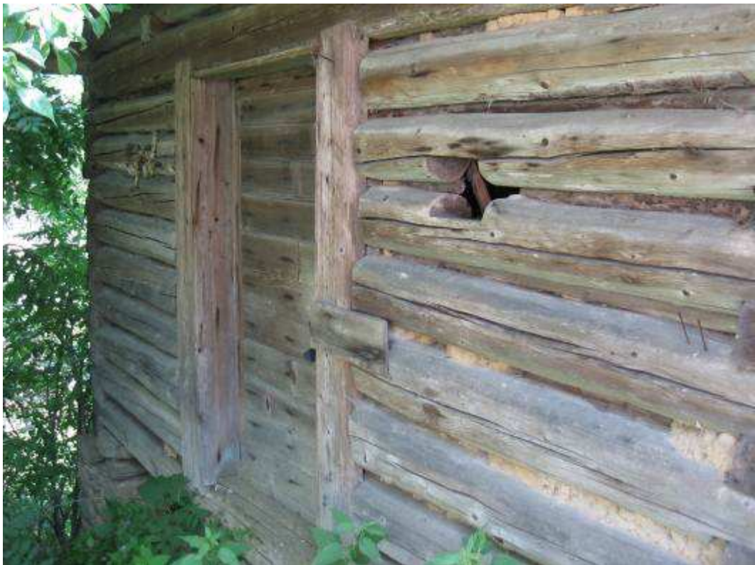
Obr. 46 – usadlosť č. 13 – detail konštrukcie zrubu sypanca (vytipovaný za NKP)
