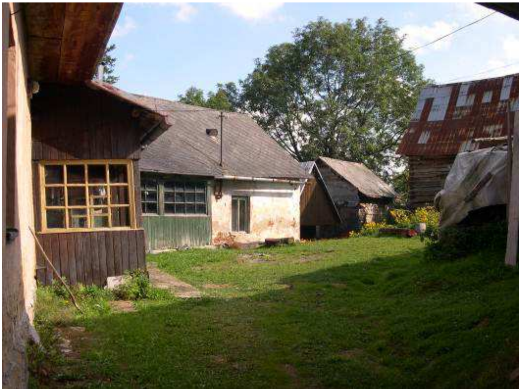
Obr. 62 – usadlosť č. 19 a 20 – pohľad na dvorovú časť obytného dvojdomu a dvor
