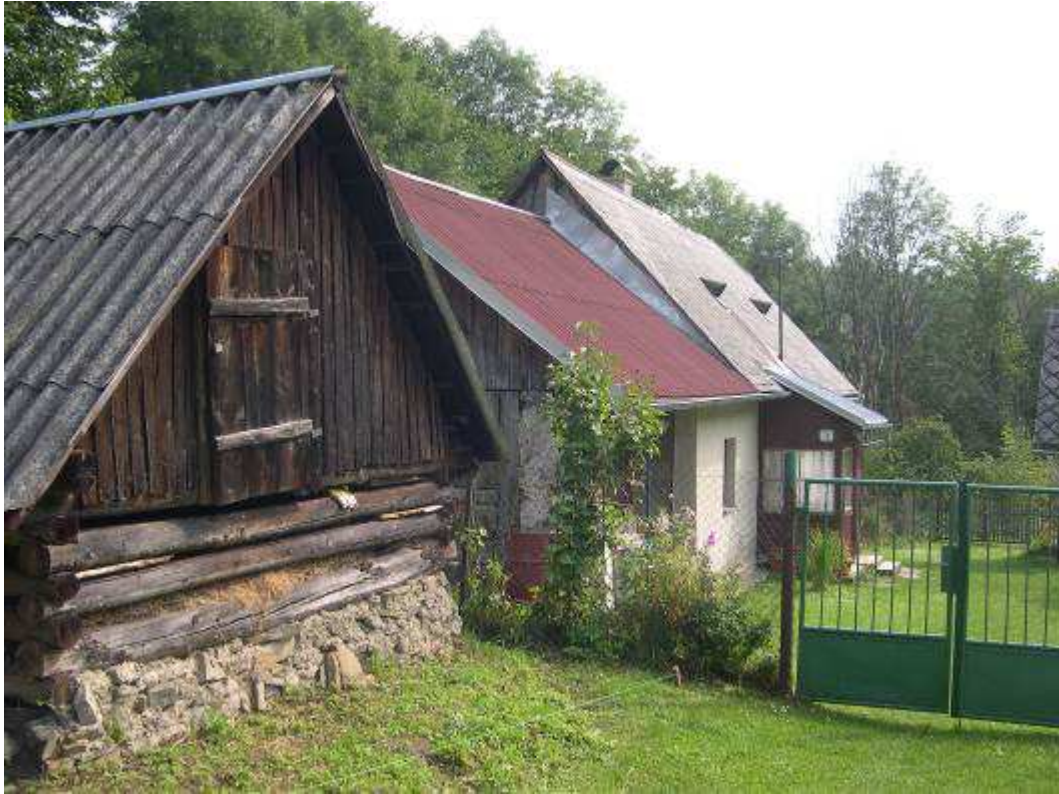
Obr. 91 – usadlosť č. 28 – vstup do dvora usadlosti so zrubovým senníkom (senník vytipovaný za NKP)
