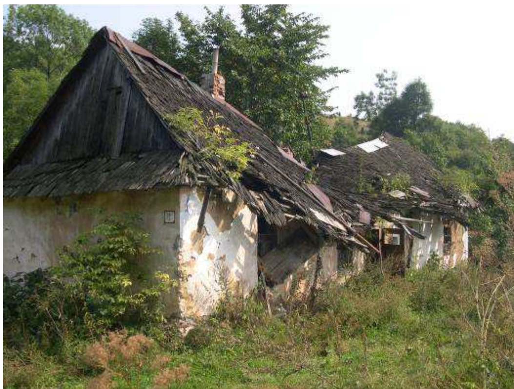
Obr. 42 – usadlosť č. 13 – obytný dom – stav v roku 2009
