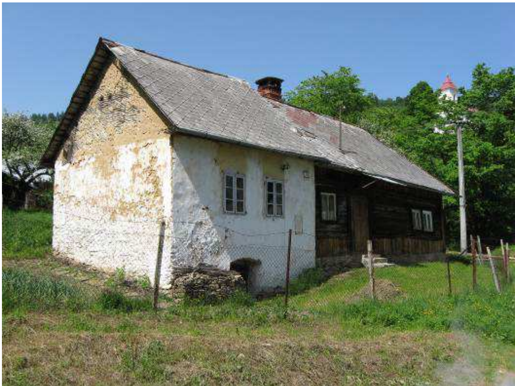
Obr. 84 – usadlosť č. 26 – zadný celkový pohľad na obytný dom NKP
