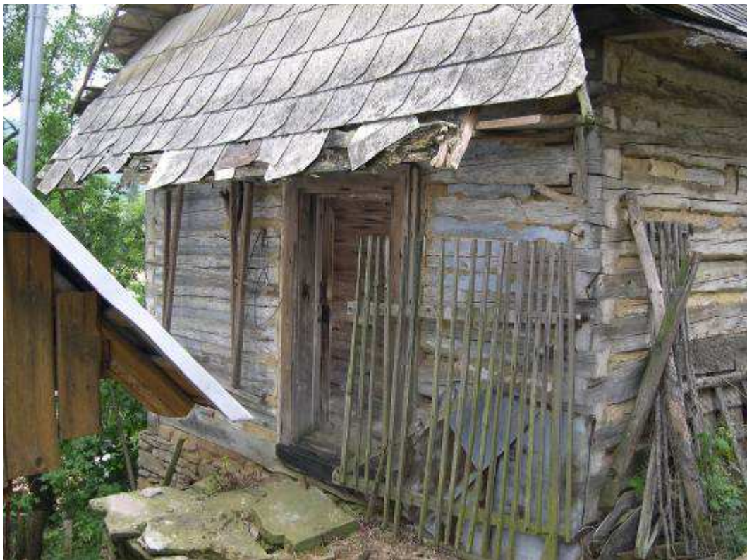
Obr. 64 – usadlosť č. 19 – det. zrubového sypanca (vytipovaný za NKP)
