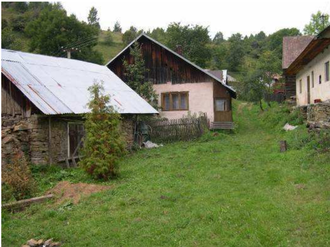
Obr. 100 – usadlosť č. 30 NKP – celkový pohľad s verejne prejazdným dvorom
