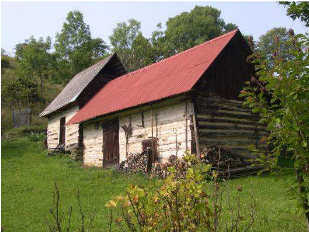
Obr. 74 – usadlosť č. 23 – zrubové hospodárske stavby dvora (vytipované za NKP)
