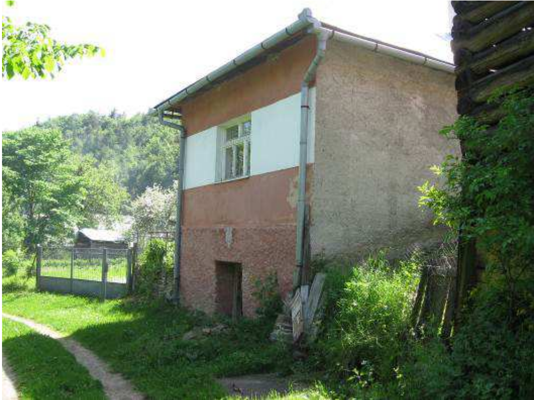
Obr. 79 – usadlost' č. 25 – obytný dom – čelná fasáda
