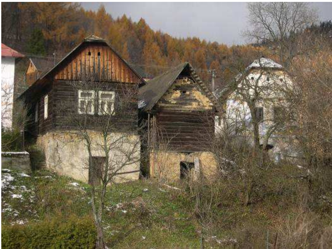
Obr. 48 – usadlosť č. 14 a 13 – celkový pohľad (zrubový dom č. 14 NKP, sypanec vľavo vytipovaný za NKP)
