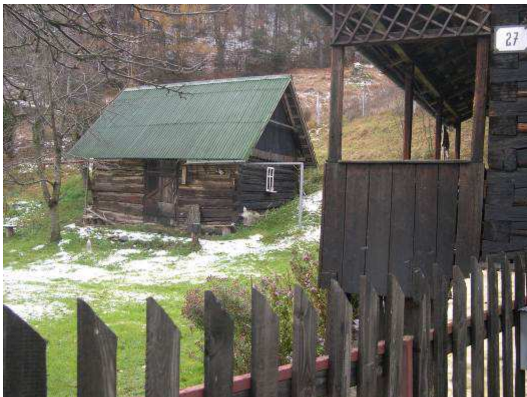
Obr. 89 – usadlosť č. 27 – zrubová hospodárska stavba dvora (vytipované za NKP)
