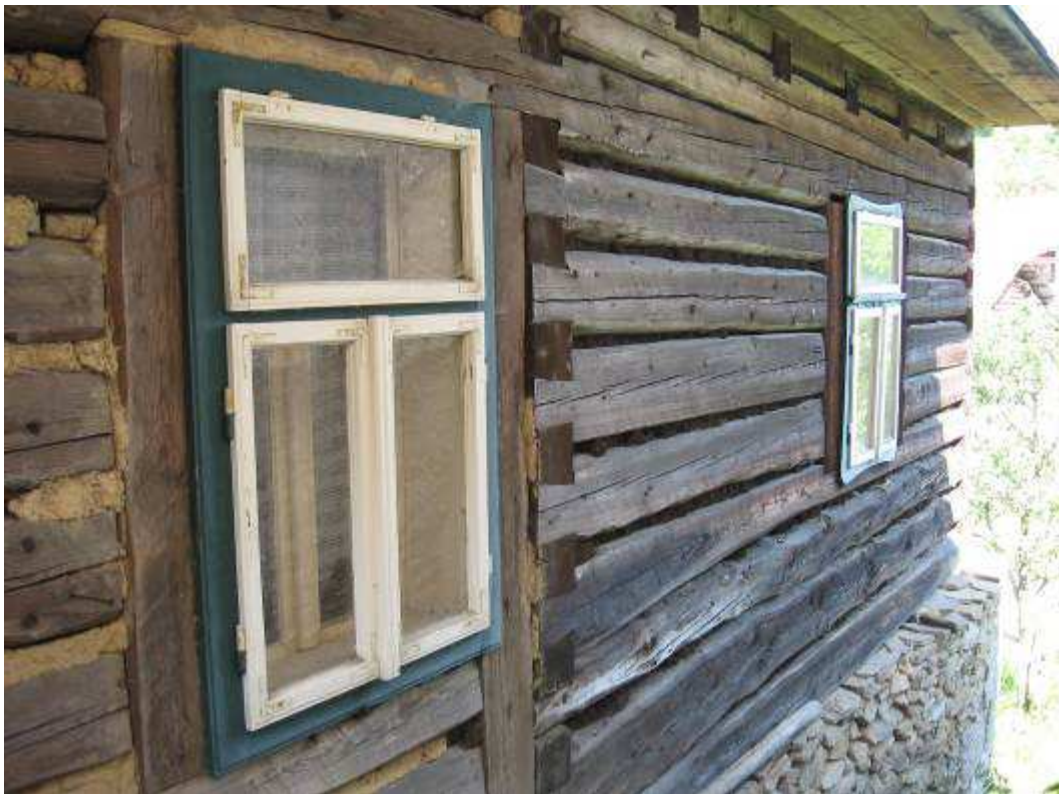
Obr. 50 – usadlosť č. 14 – dvorová stena zrubu obytného domu NKP
