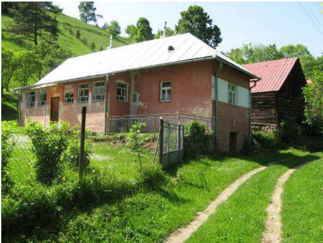
Obr. 80 – usadlost' č. 25 – dvorová strana obytného domu
