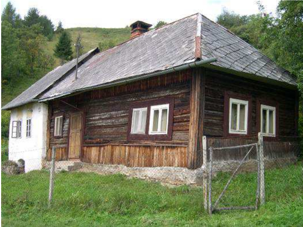
Obr. 83 – usadlosť č. 26 – obytný dom NKP – celkový pohľad z ulice
