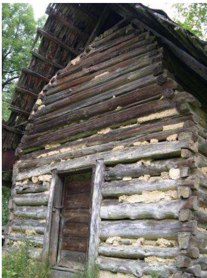
Obr. 85 a 86 – usadlosť č. 26 – zrubový sypanec + detail konštrukcie zrubu
