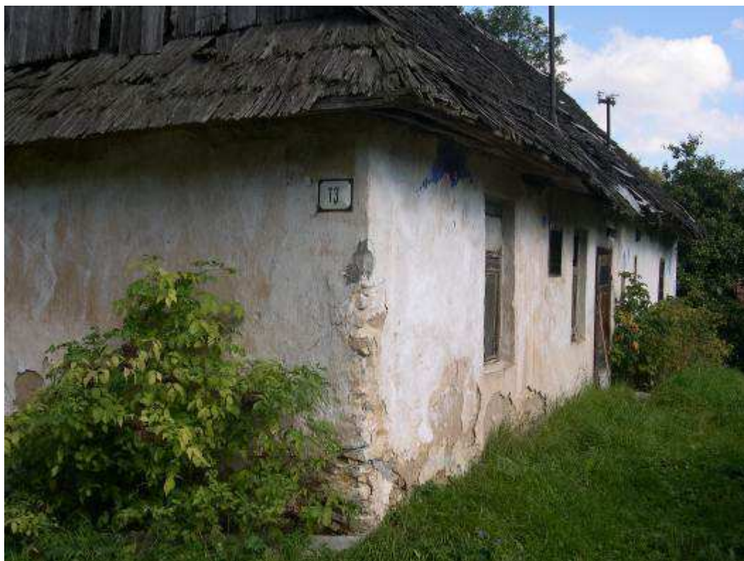
Obr. 41 – usadlosť č. 13 – obytný dom – stav v roku 2004
