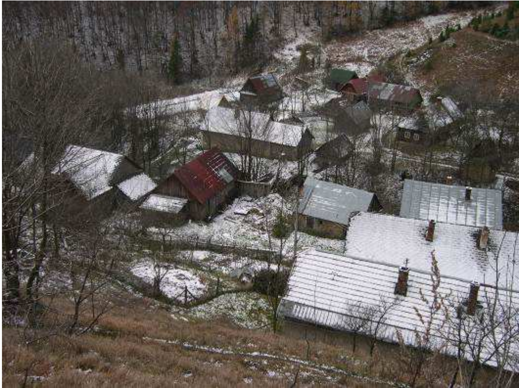
02a zimný pohľad od kostola NKP na dolnú časť PZ smerom na JZ
