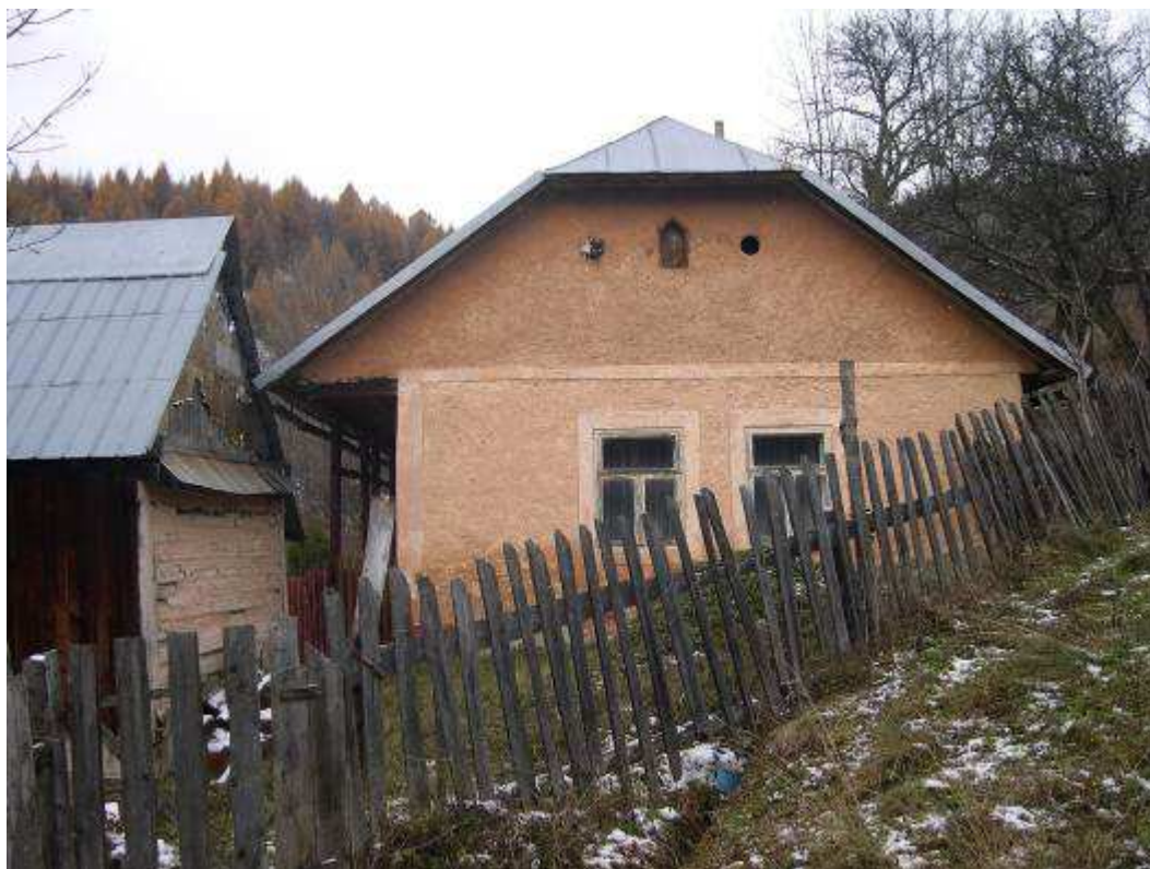
Obr. 33 – usadlost' č. 11 – obytný dom – čelná fasáda
