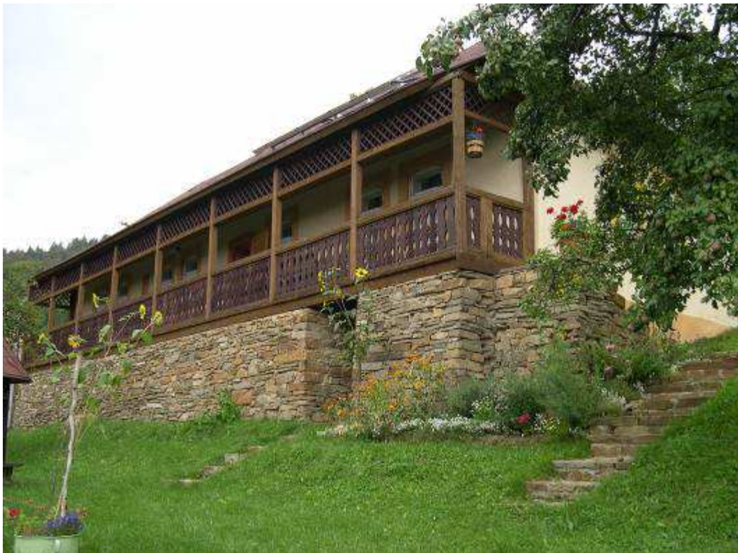
Obr. 22 – usadlosť č. 8 NKP – obytný dom – bočná dvorová fasáda s krytým „gánkom“
