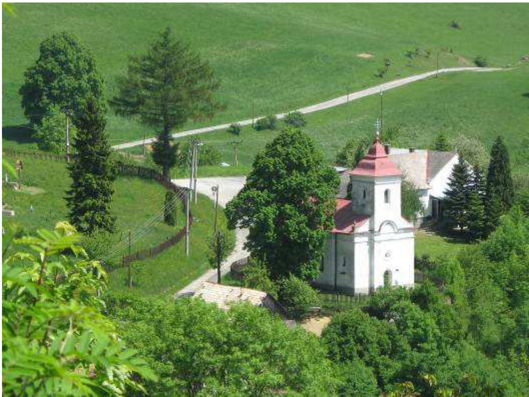
N. diaľkový pohľad zo Z strany OP na kostol NKP, školu a cintorín a prístupovú cestu do obce
