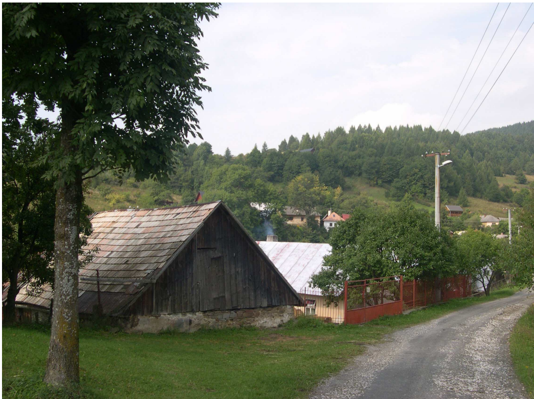
03 pohľad od kostola NKP na PZ po prístupovej ceste smerom na SZ
