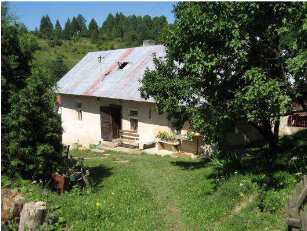
Obr. 14 – usadlosť č. 6 – obytný dom – pohľad z cesty
