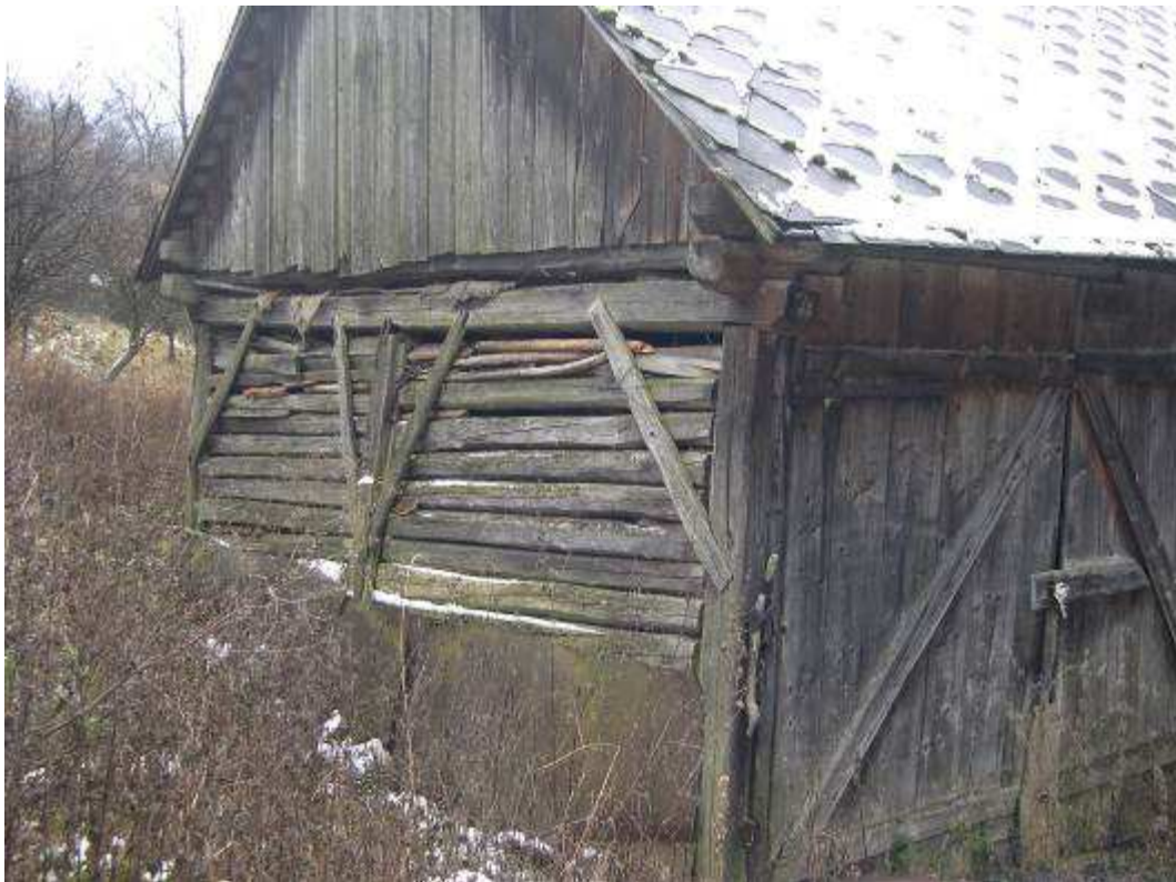
Obr. 38 – usadlosť č. 11 – detail konštrukcie stodoly
