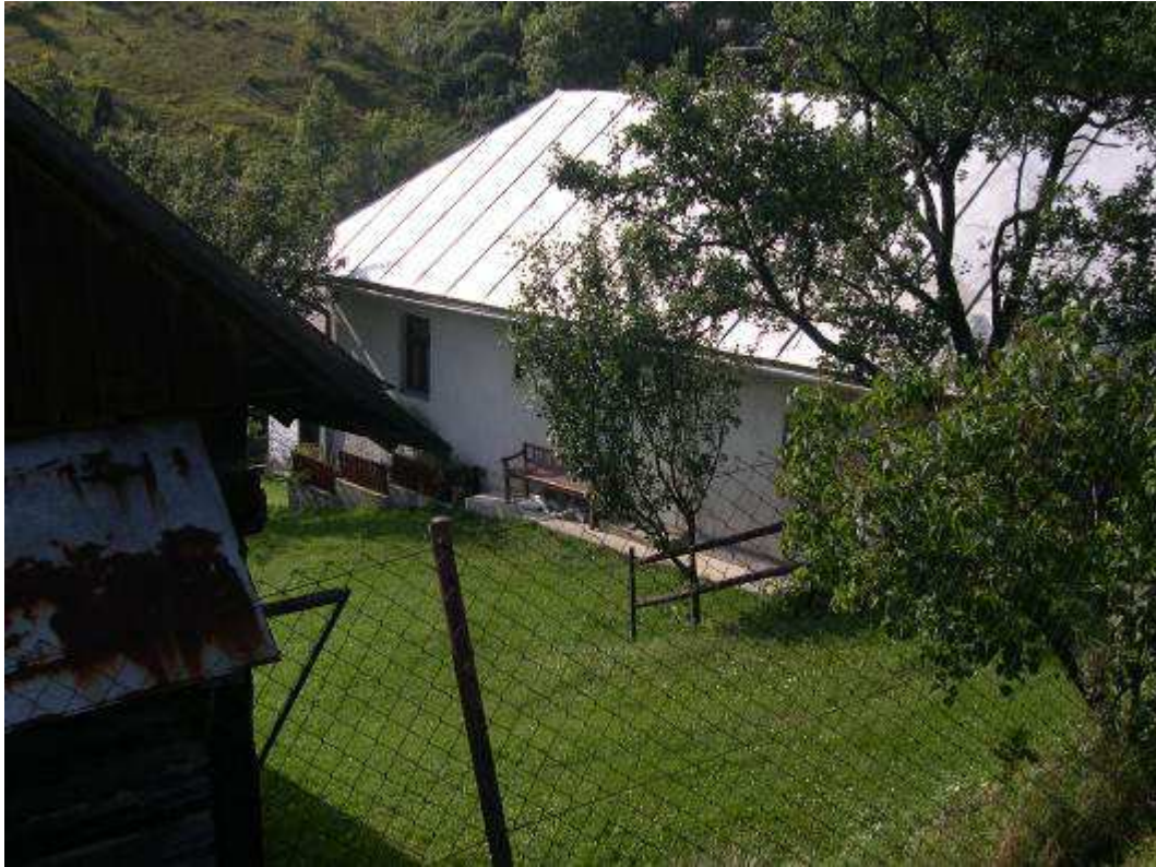
Obr. 17 – usadlosť č. 7 – obytný dom – pohľad z cesty
