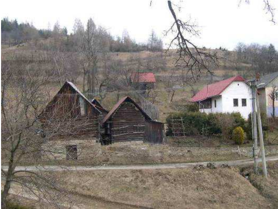
Obr. 31 – usadlosť č. 10 – zrubové hospodárske stavby dvora (vytipované za NKP)
