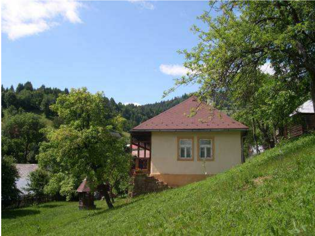
Obr. 21 – usadlosť č. 8 NKP – obytný dom – čelná fasáda
