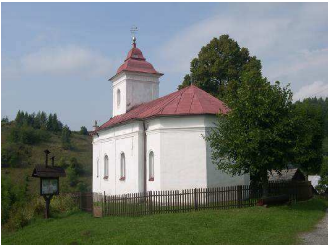
Obr. 12 – pohľad na kostol NKP z JV
