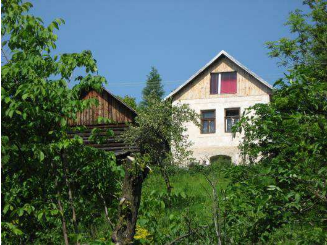
Obr. 15 – usadlosť č. 6 – čelná fasáda domu s nevhodnou úpravou štítu zo Z
