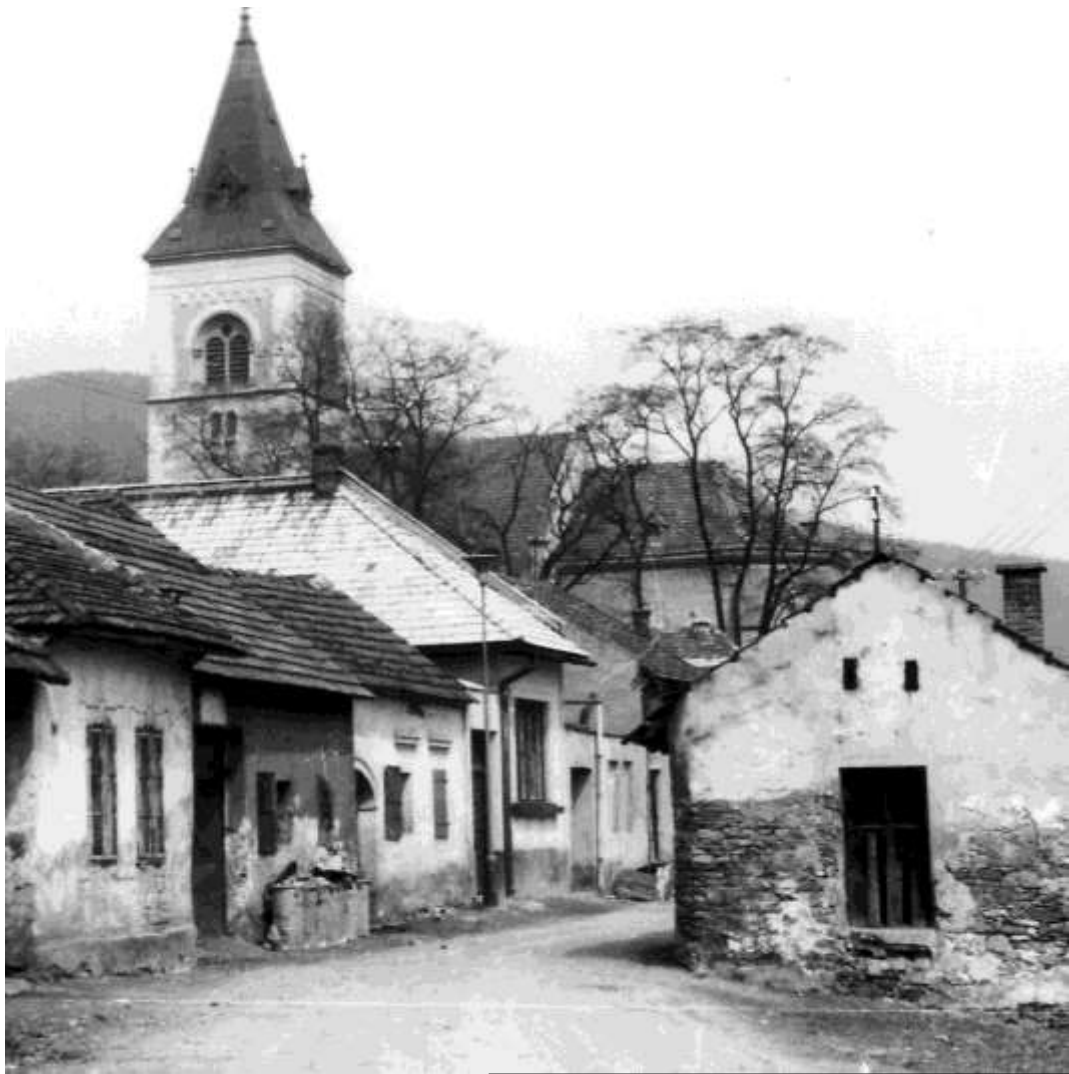
Kostol sv. Jakuba s tvrdou škridlovou krytinou v roku 1963. Pri neskoršej obnove bola škridla nahradená medeným pásovým plechom.
