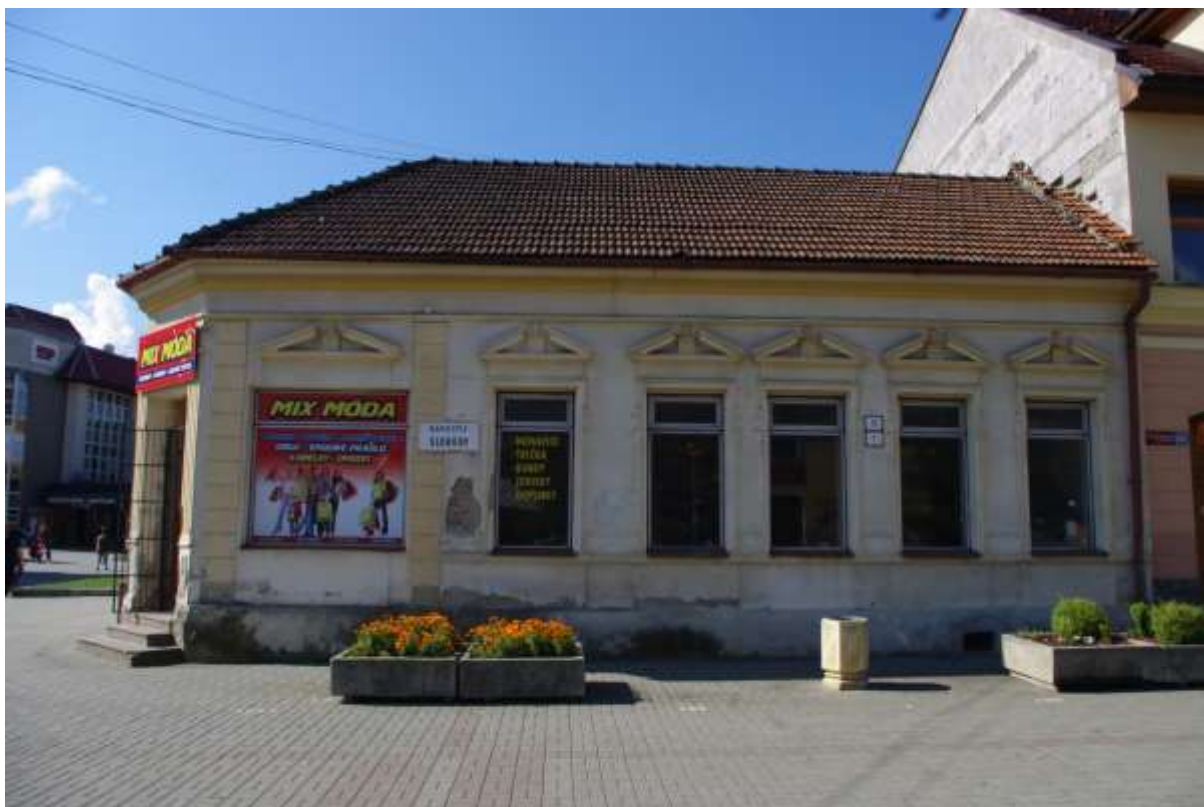
Námestie Slobody, súpisné číslo 16, parcelné číslo KN 447/1-2, predmetom ochrany je: H – hmota uličného krídla, F – fasáda so štukovou výzdobou, U – štuková výzdoba fasády, S – tvar a forma zastrešenia
