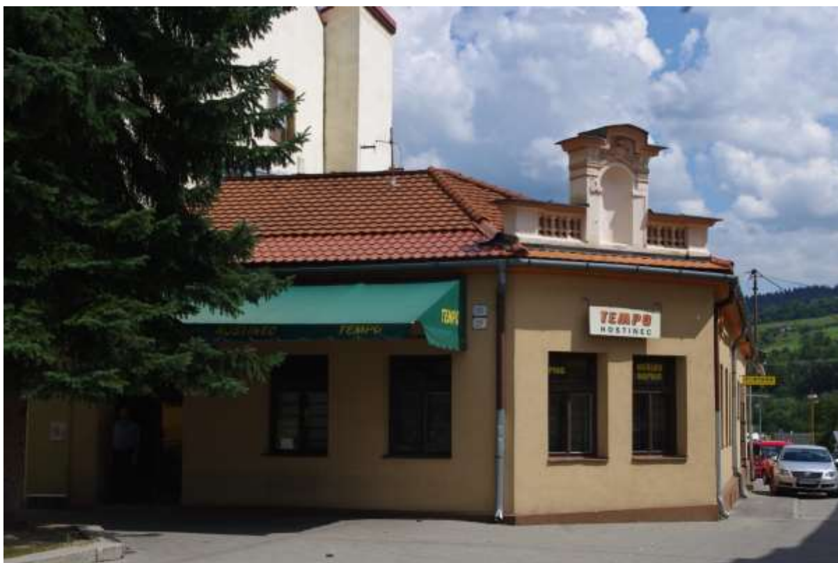
Námestie Slobody, súpisné číslo 169, parcelné číslo KN 19, predmetom ochrany je: H – hmota uličného krídla, U – štuková výzdoba fasády, S – tvar a forma zastrešenia
