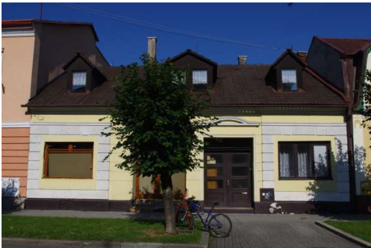
Belanského ulica, súpisné číslo 13, parcelné číslo KN 444, predmetom ochrany je: H – hmota uličného krídla, F – fasáda so štukovou výzdobou, U – štuková výzdoba fasády, S – tvar a forma zastrešenia
