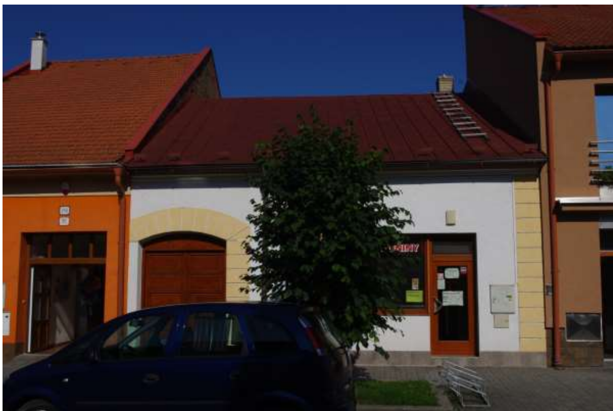
Belanského ulica, súpisné číslo 241, parcelné číslo KN404/1, predmetom ochrany je: H – hmota uličného krídla, F – fasáda so štukovou výzdobou, U – štuková výzdoba fasády, S – tvar a forma zastrešenia
