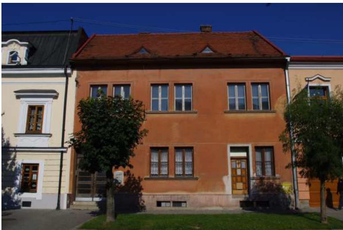
Belanského ulica, súpisné číslo 10, parcelné číslo KN 439, predmetom ochrany je: H – hmota uličného krídla, F – fasáda so štukovou výzdobou, U – štuková výzdoba fasády, S – tvar a forma zastrešenia
