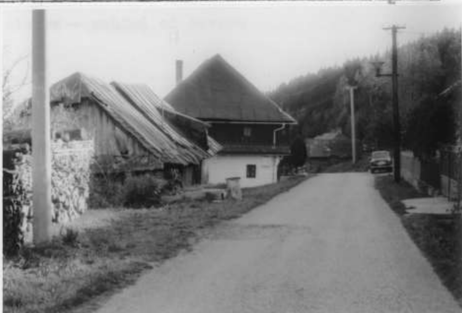
- d.č. 40 a hosp. stavba - pohľad od S
