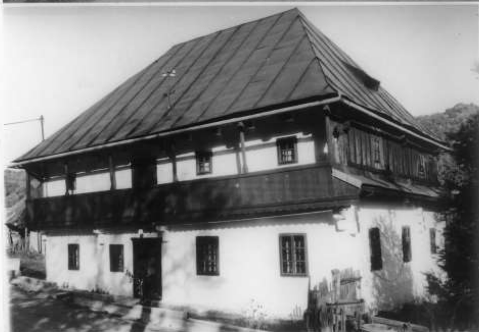
- d.č. 40 /parc.č.103/ čelný pohľad od ulice /od JZ /
