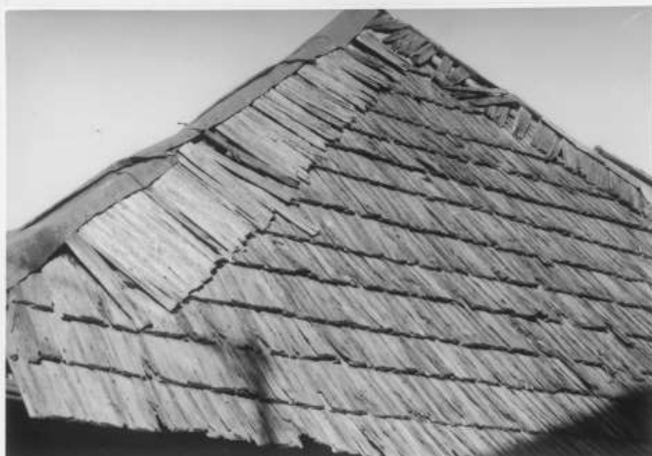
- ukončenie šindľovej krytiny /hosp.stavba - parc.č.103/
