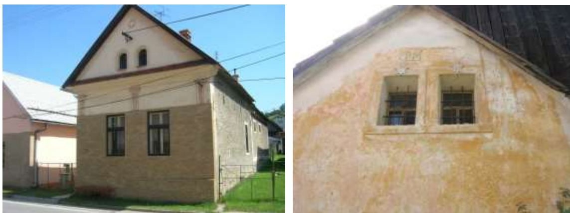
charakteristický spôsob presvetlenia pôjdneho priestoru – dvojica okien v štíte
