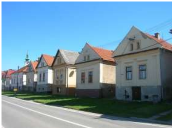
charakteristická strešná krajina murovaných domov južná časť historického námestia
