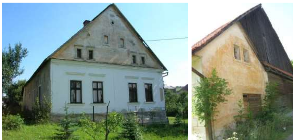
charakteristický spôsob presvetlenia pôjdneho priestoru – dvojica okien v štíte
