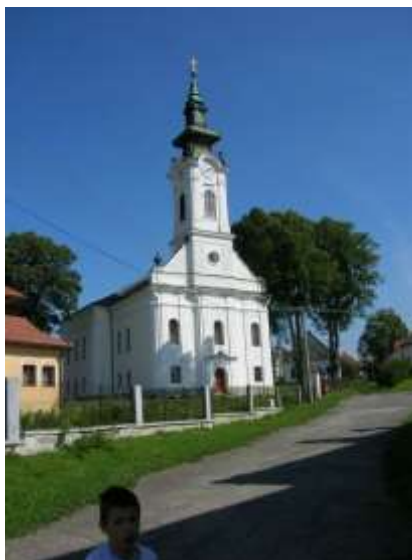
pohľadový kužel č. 10 areál ev. a. v. kostola a fary
