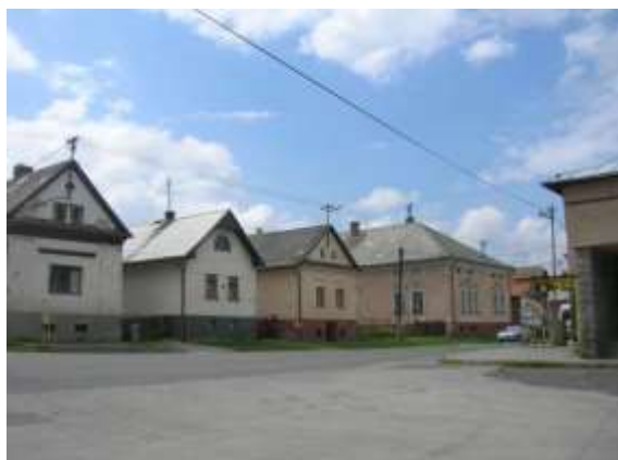
domy č. 180,181,183 (parc. č. 70/1,2,3 1 71/1)
