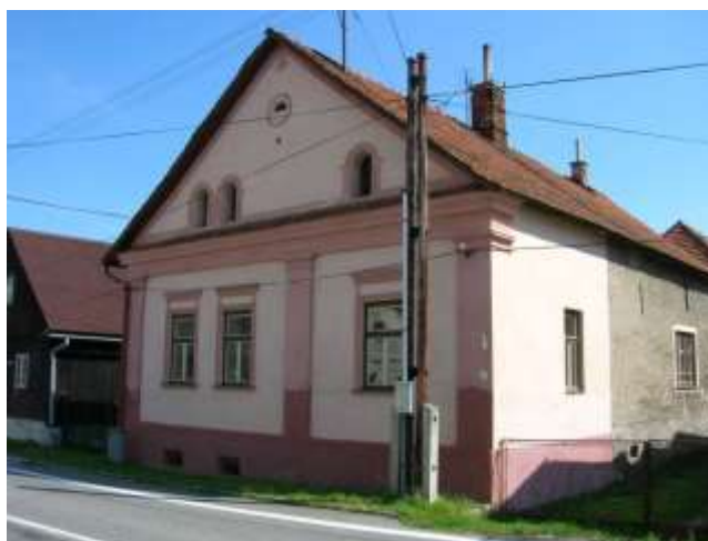
murovaný dom s dvomi traktami dom č. 283
