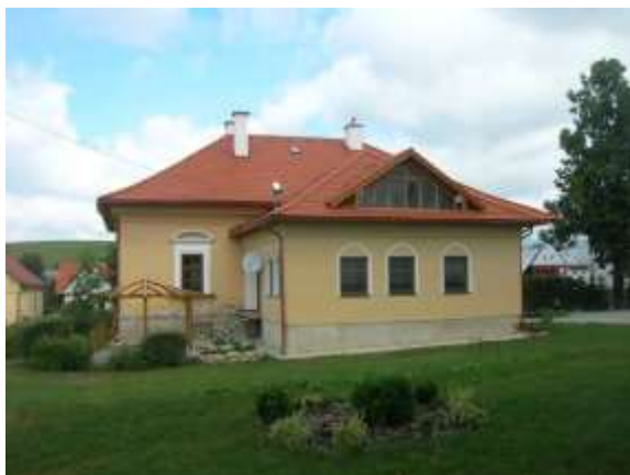
budova evanjelickej fary č.122 (parc. č. 42/1)
