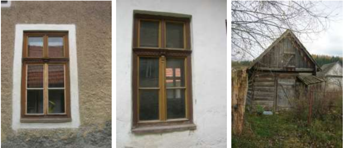
výplne okenných otvorov (obytné murované domy), výplne otvorov na drevenej hospodárskej stavbe
