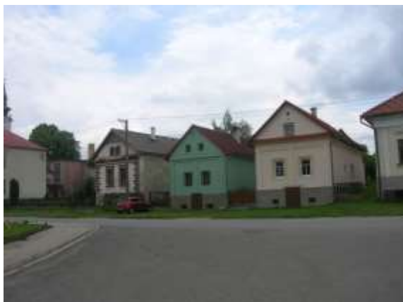
domy č.143, 145, 146 (parc. č. 53/1, 54/1, 55/1)
