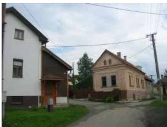
zástavba severovýchodného nárožia hlavné námestie
