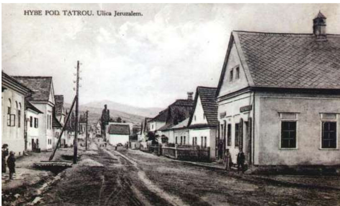
6. Hybe – západná časť ulica Jeruzalem s charakteristickou murovanou zástavbou obytných domov
