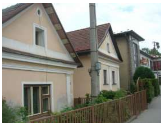
domy č. 346, 347 (parc. č. 154/1, 154/3)
