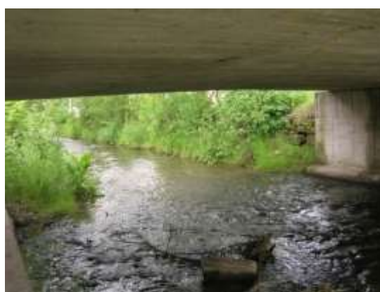
brehy Hybice s prirodzeným vegetačným krytom v dotyku s mostným objektom
