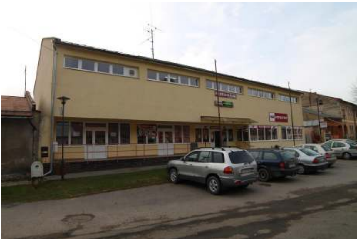
126. Objekt č. 225, r. 2014
