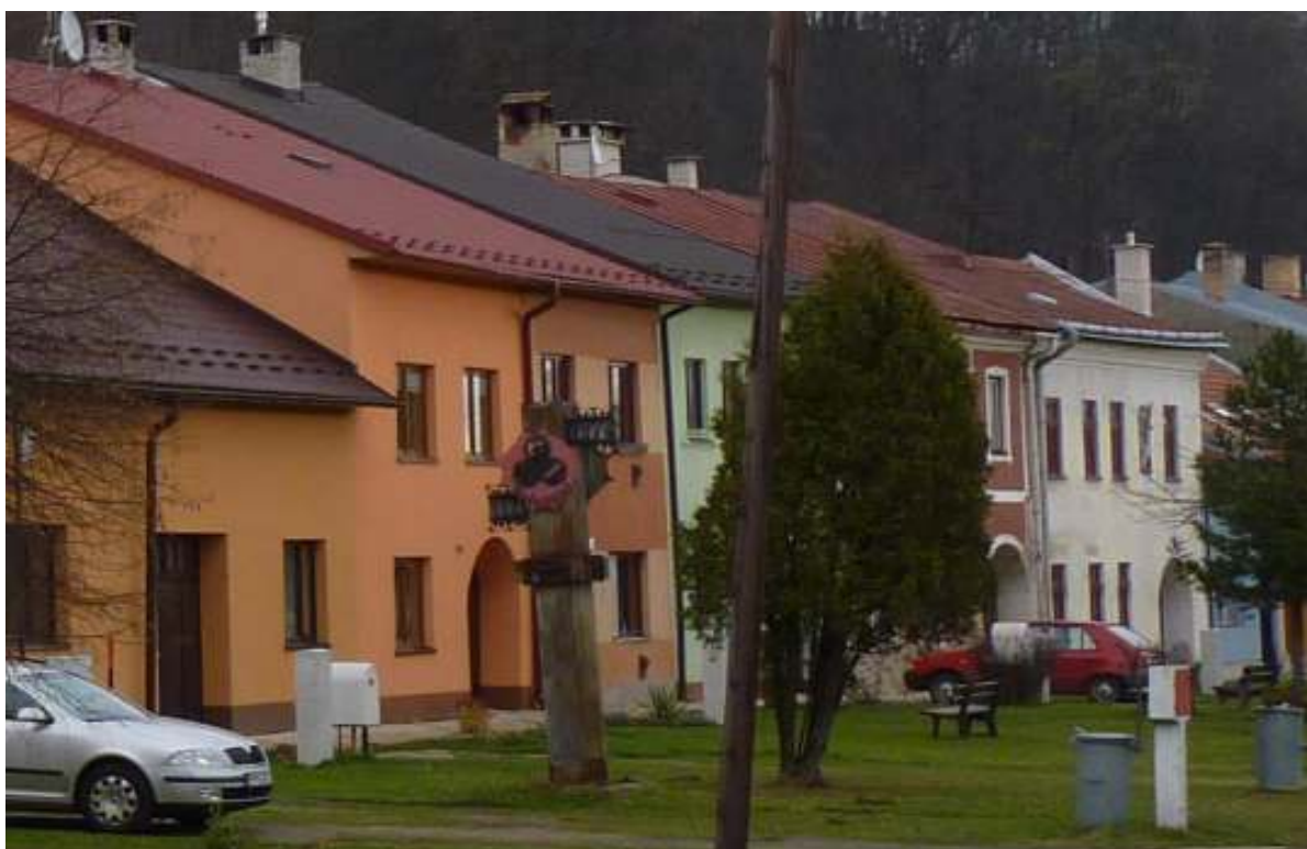
32. Severné domoradie (domy č. 110-114), r. 2014
