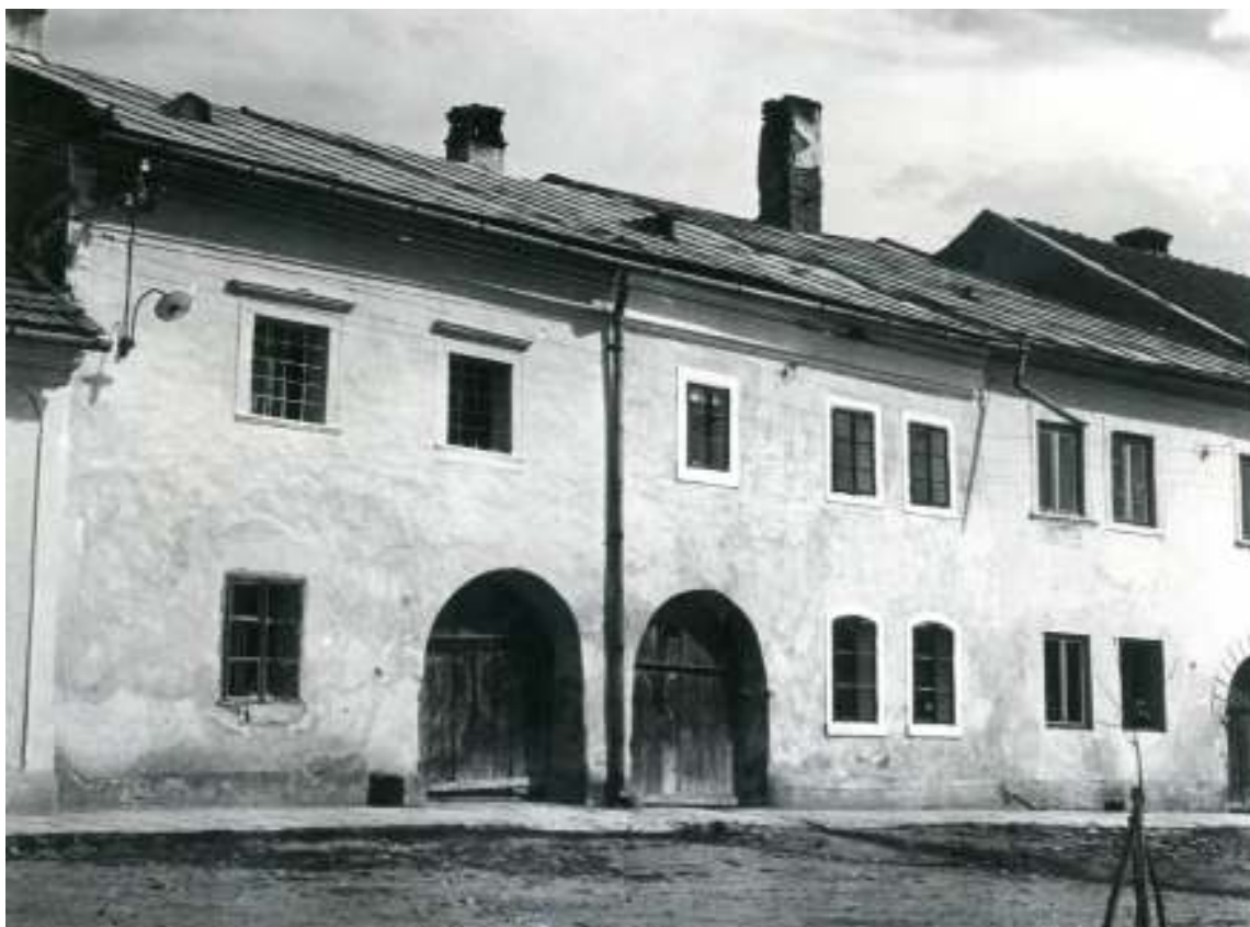
17. Severné domoradie (domy č. 110-112), r. 1955
