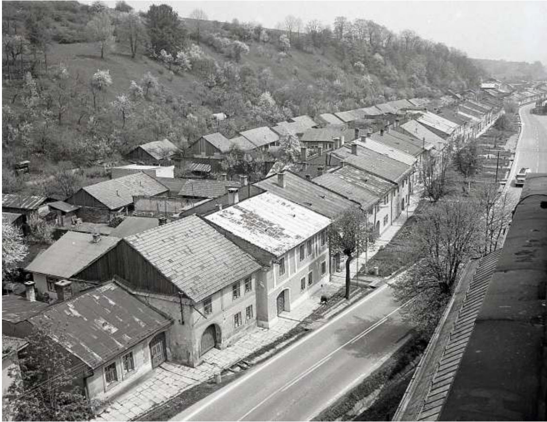
5. Pohľad z veže na severné domoradie (domy č. 98-133), r. 1985
