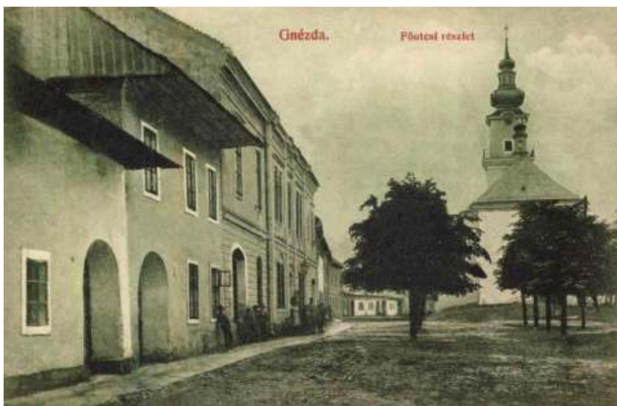
6. Pohľad na stred námestia od východu, pred rokom 1918
