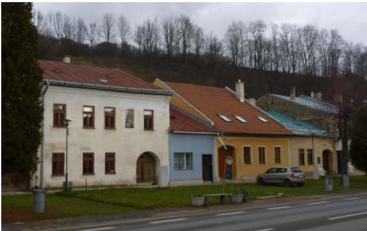
34. Severné domoradie (domy č. 114-116), r. 2014
