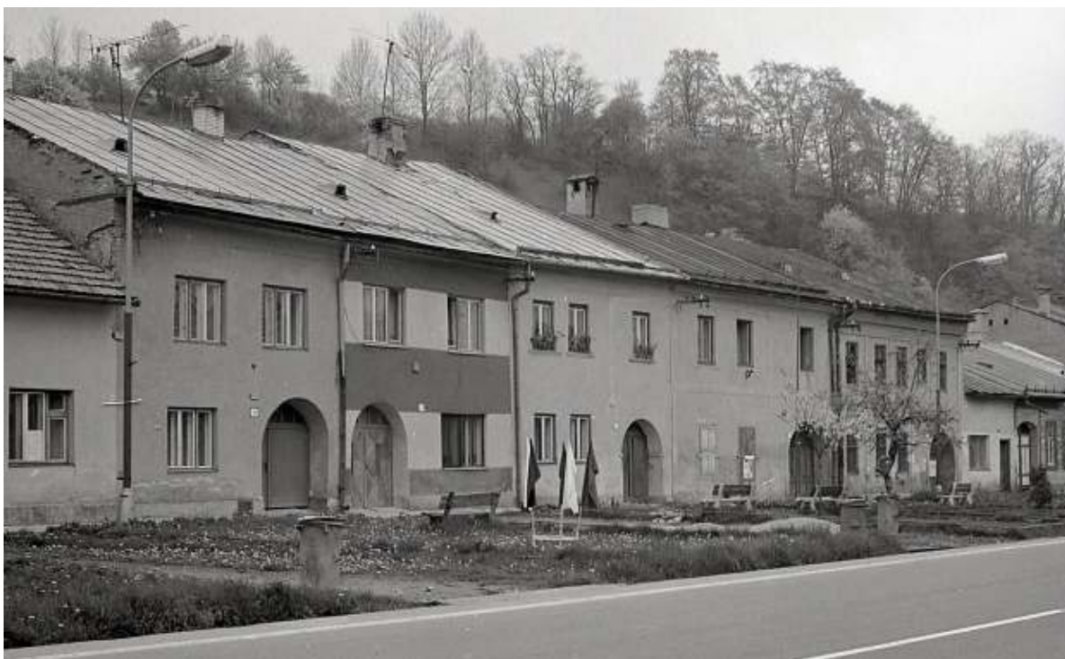
31. Severné domoradie (domy č. 110-114), r. 1985
