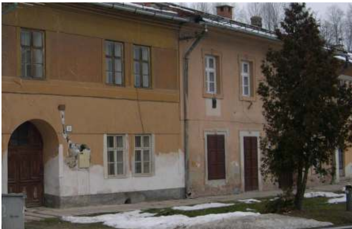
10. Severné domoradie, domy č. 103-104, r. 2013
