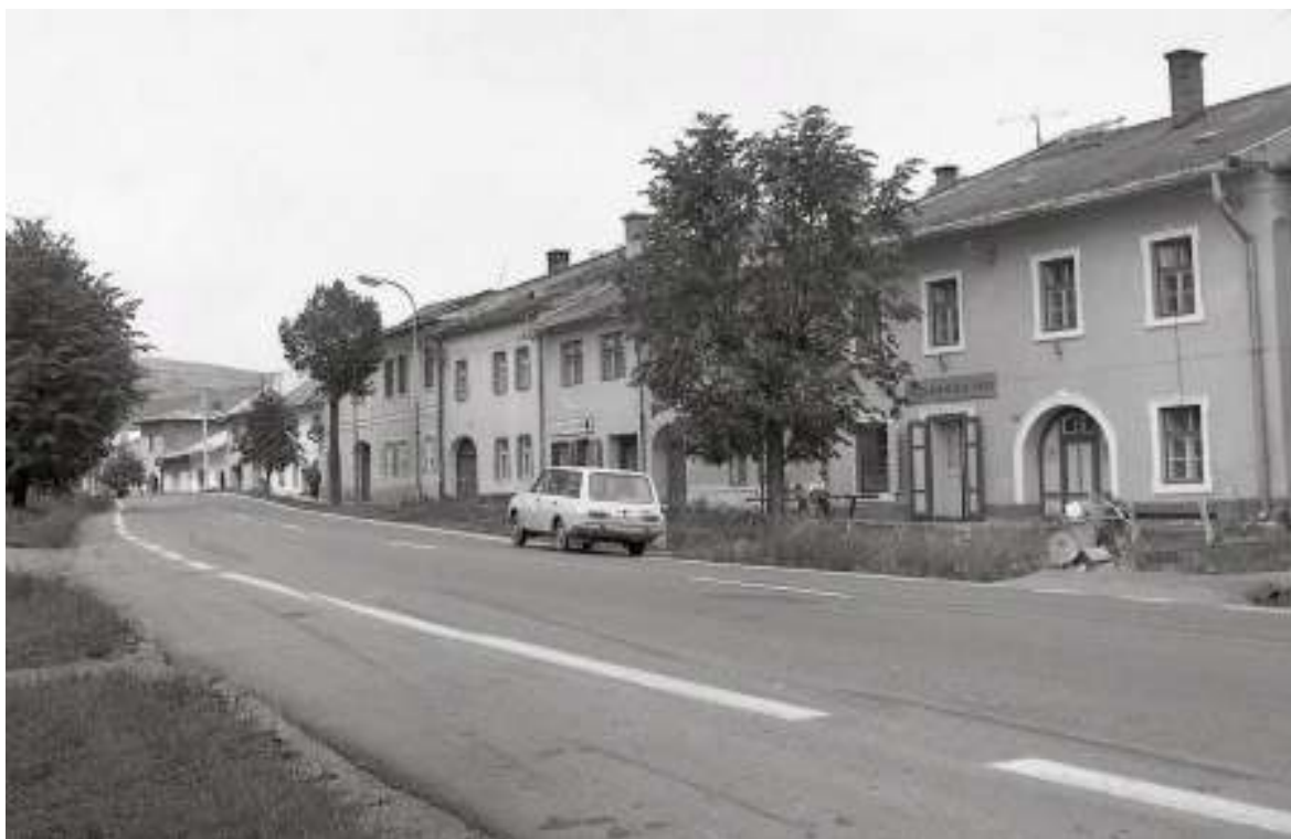
35. Severné domoradie (domy č. 100-104), r. 1977
