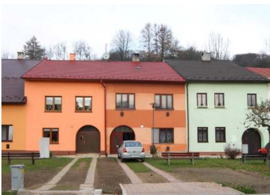
18. Severné domoradie (domy č. 110-112), r. 2014
