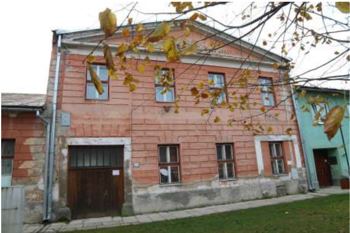
46. Budova školy(objekt č. 234), r. 2014
