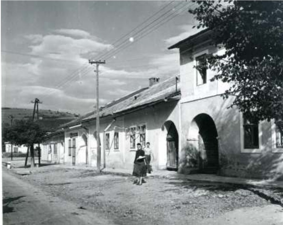
21. Severné domoradie (domy č. 77-82), r. 2014
