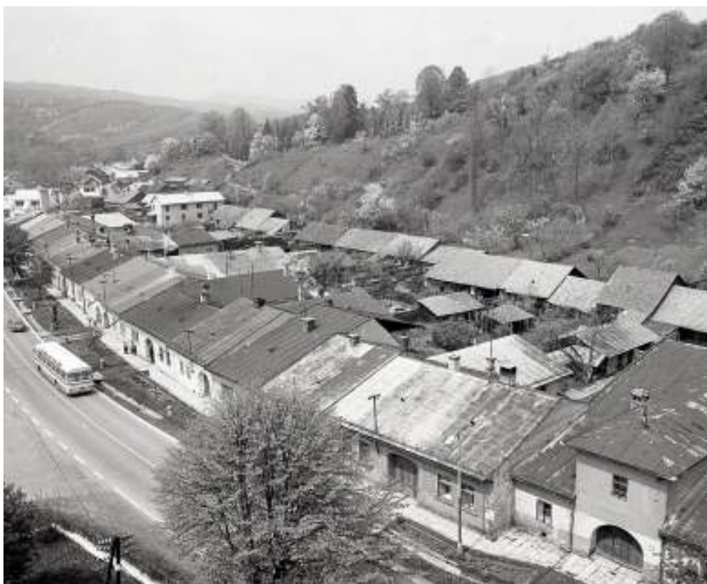
2. Pohľad z veže na severné domoradie (domy č. 86-94), r. 1985
