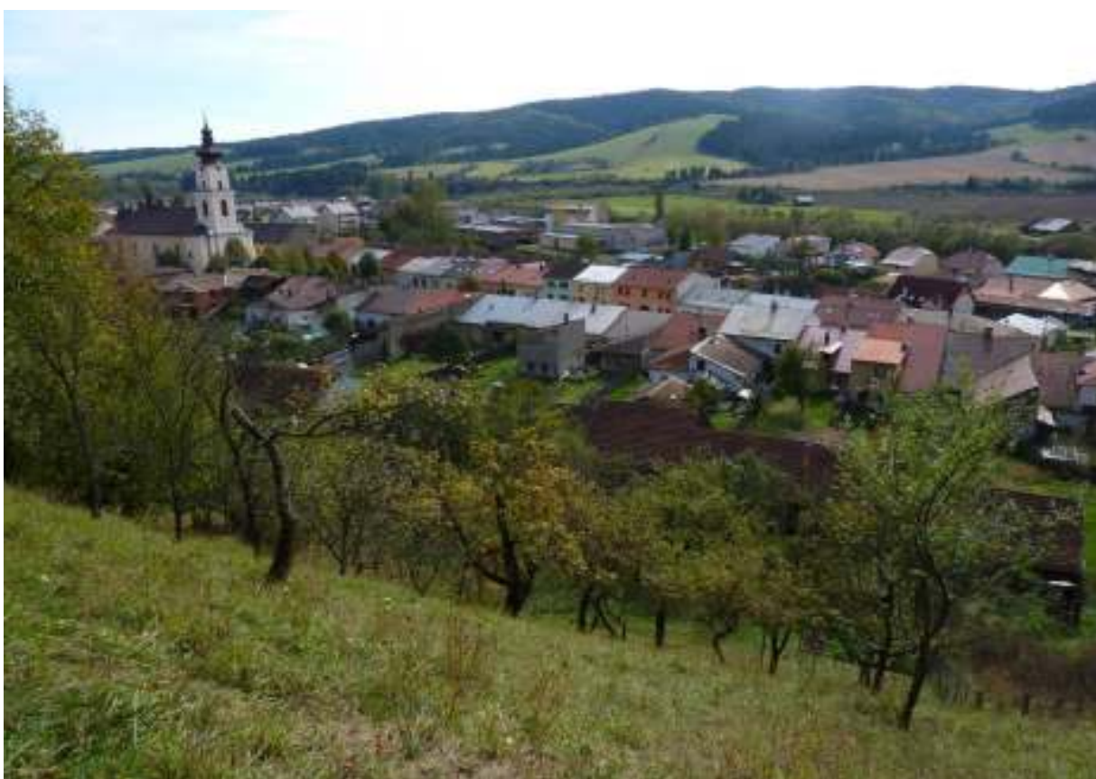
B. Pohľad na pamiatkovú zónu od severozápadu
