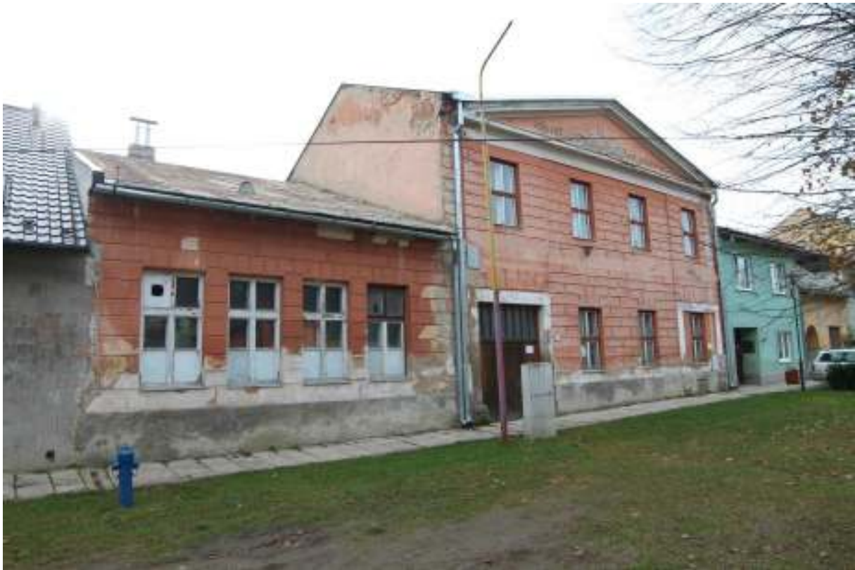
133. Objekt č. 234, r. 2014
