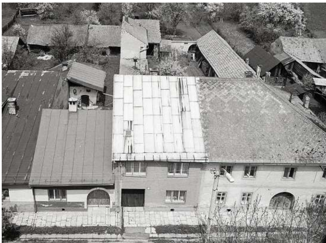
4. Pohľad z veže na severné domoradie (domy č. 95-97), r. 1985
