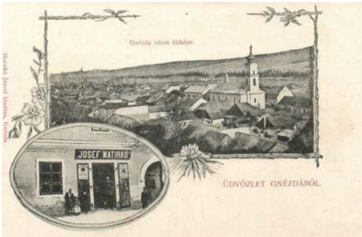
3. Historická pohľadnica z roku 1905 - pohľad na sídlo od severozápadu
