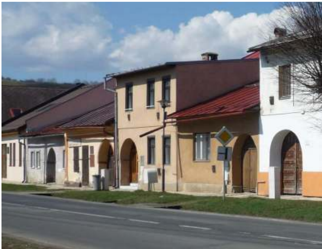
22. Severné domoradie (domy č. 77-82), r. 2014
