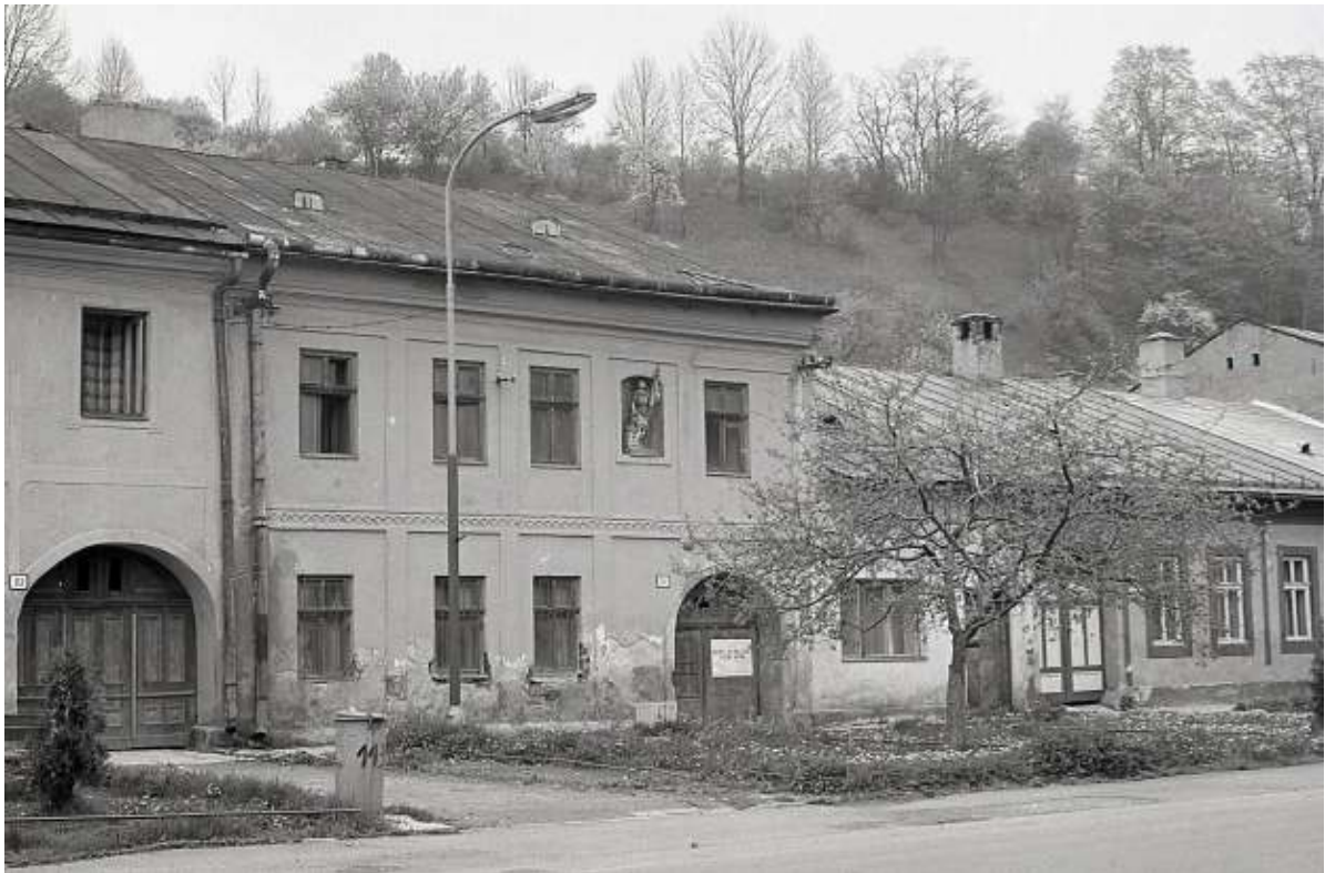
33. Severné domoradie (domy č. 114-116), r. 1985
