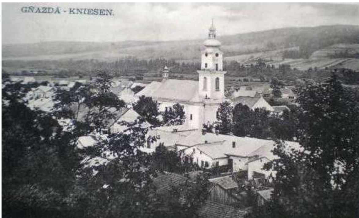
12. Pohľad na sídlo od severozápadu, 20. roky 20. storočia
