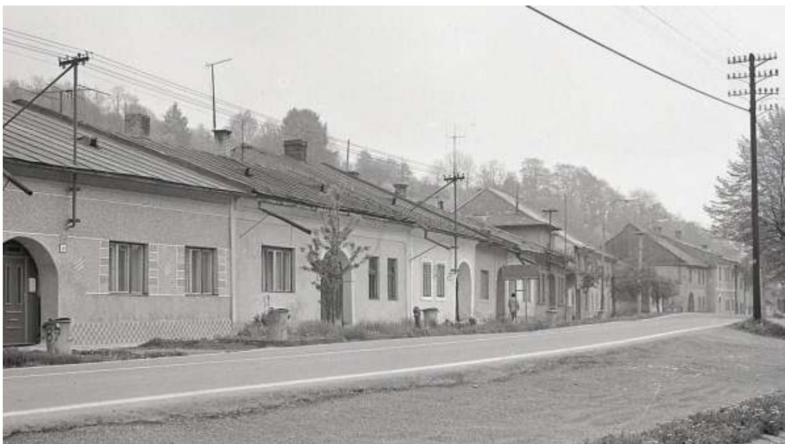
39. Severné domoradie (domy č. 88-92), r. 1985
