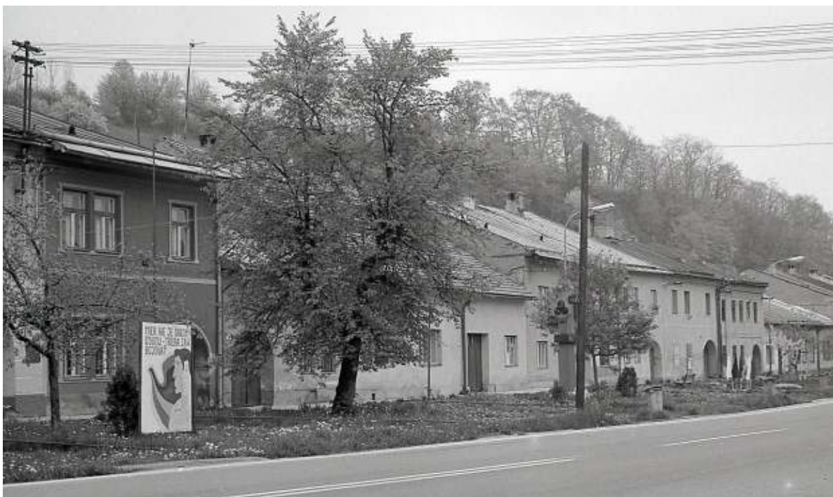
29. Severné domoradie (domy č. 107-111), r. 1985
