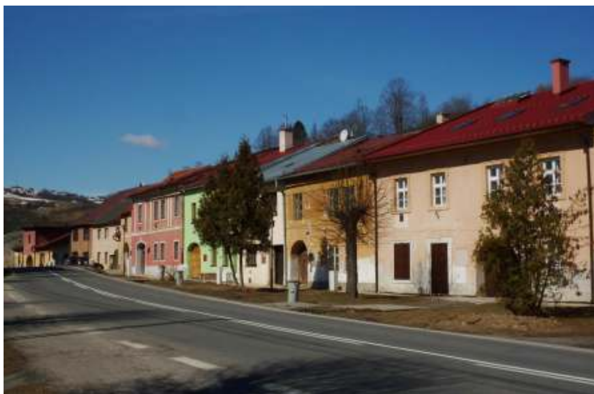
36. Severné domoradie (domy č. 100-104), r. 2012
