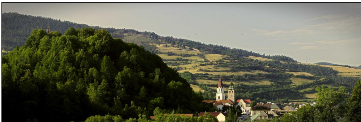
P3 – Panoramatický chránený pohľad od návršia spred obce Háj, kde sa vynímajú najmä výškové dominanty a mestotvorné objekty v PZ Gelnica. Fotografia: I. Cziel, august 2013
