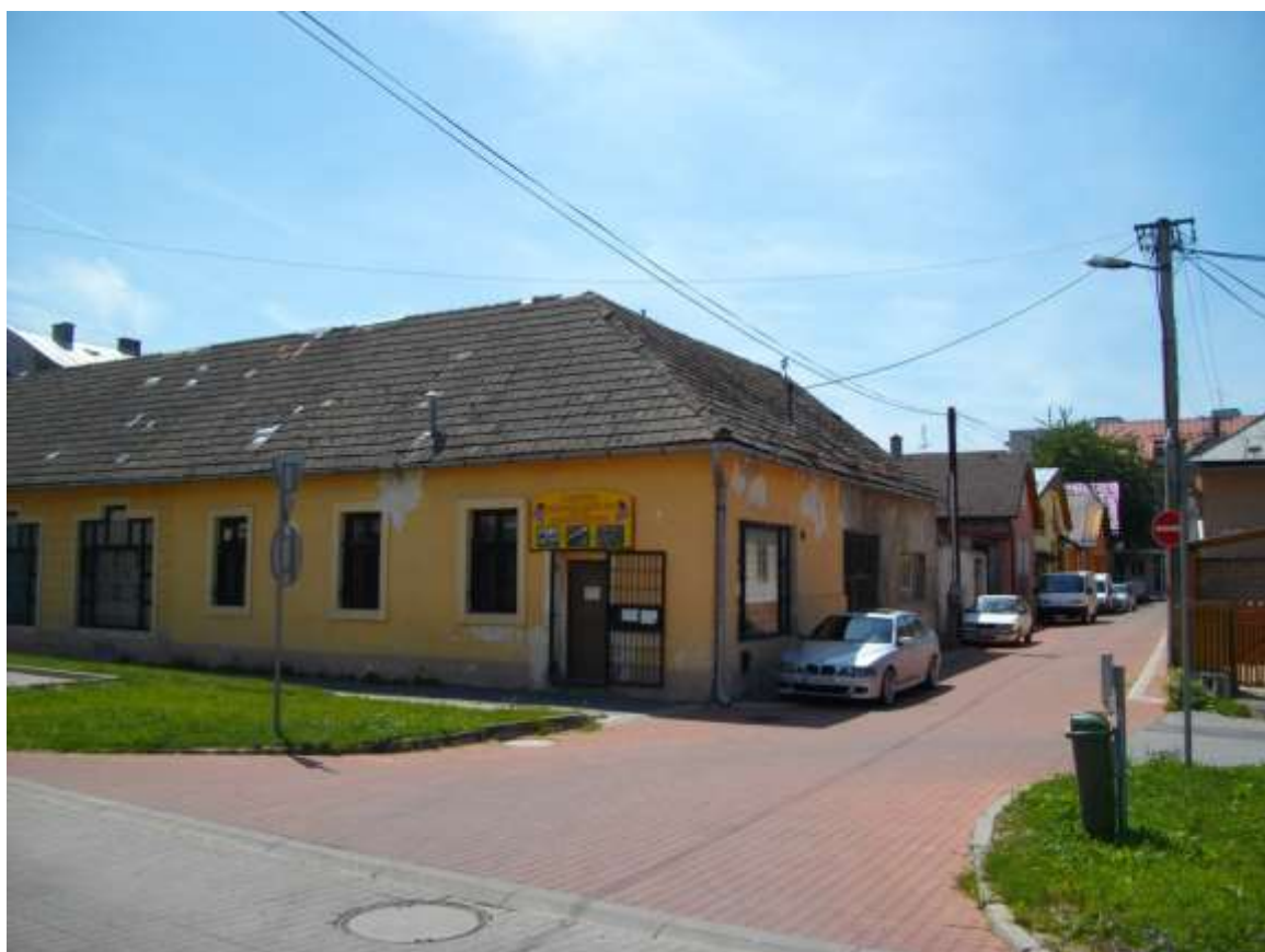
219. Ulica Kragujevských martýrov
