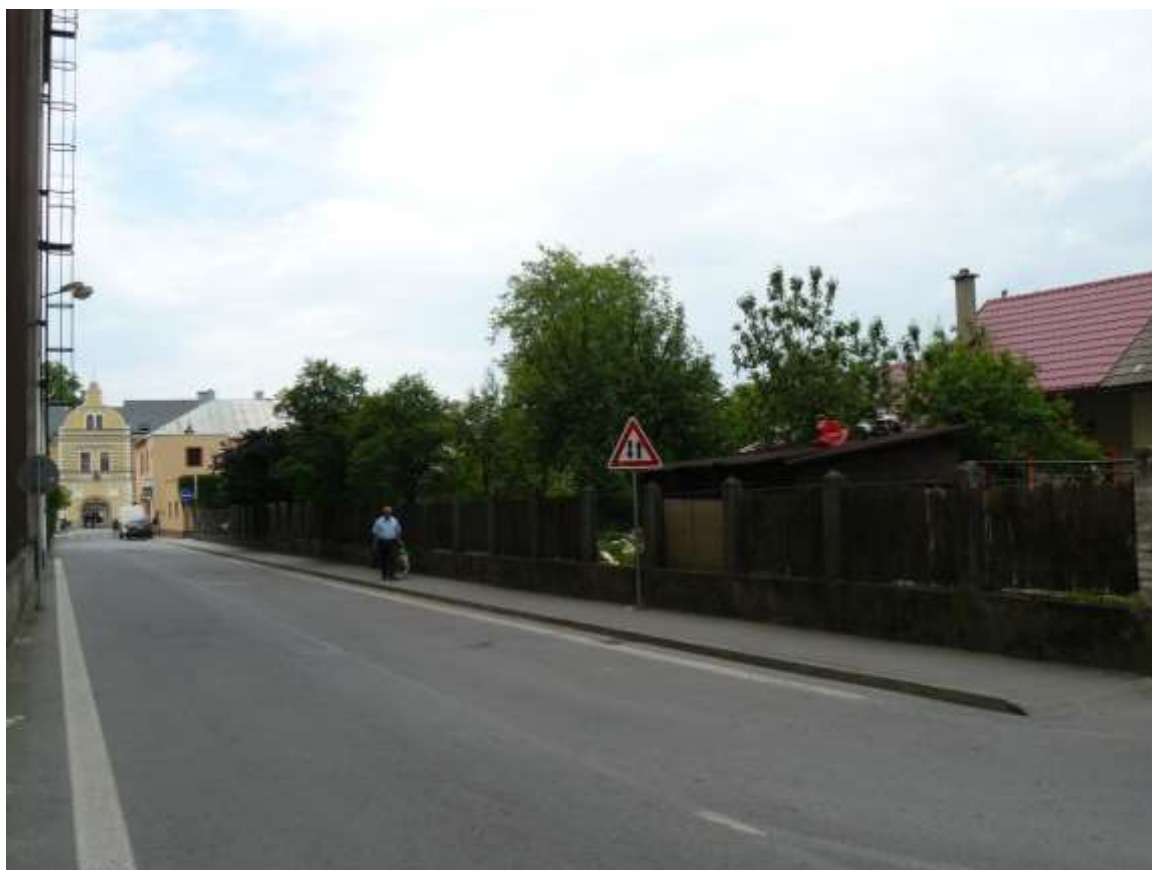
228. Severná strana Štefánikovej ulice
