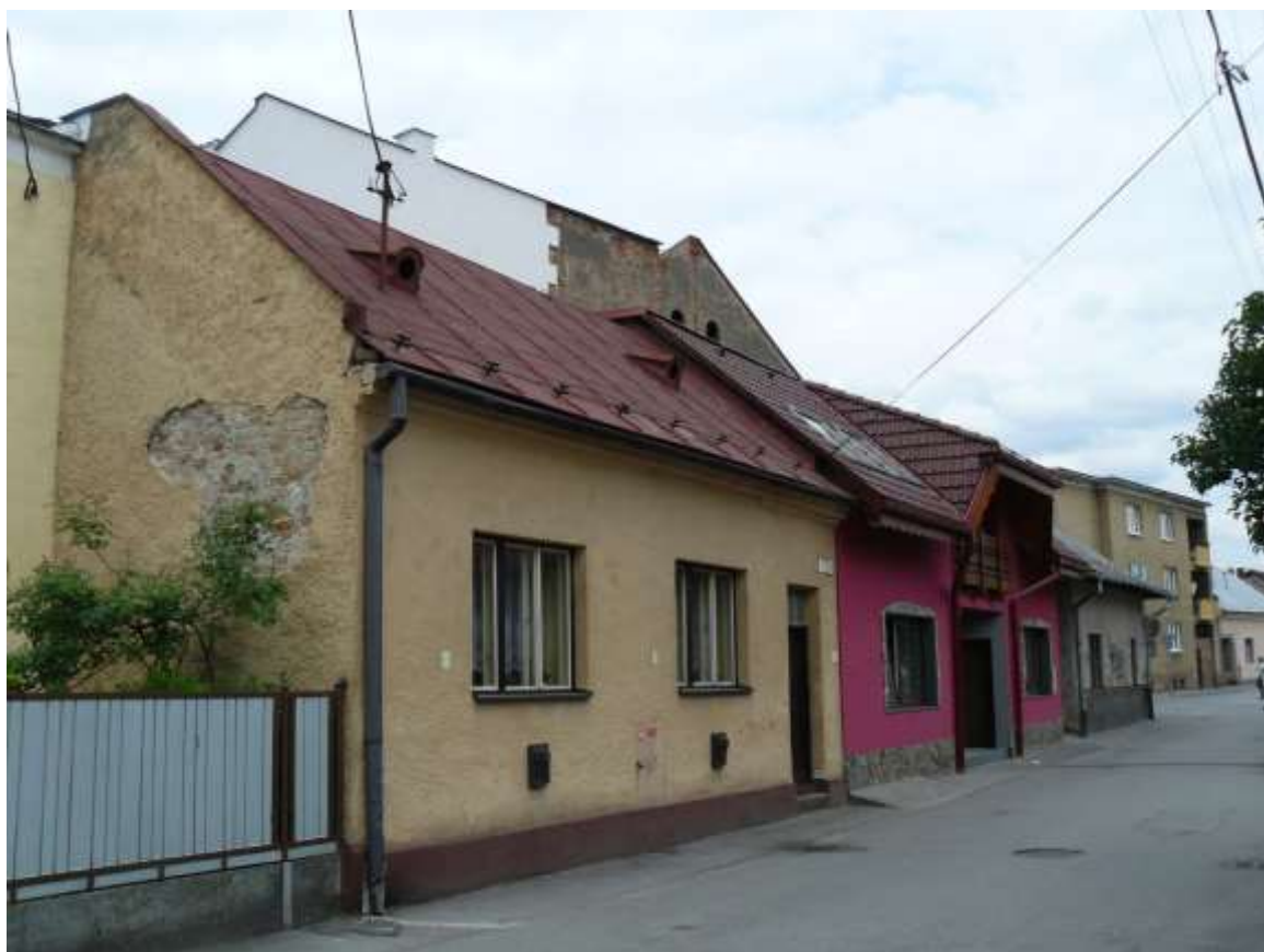
226. Zápádná strana Kollárovej ulice
