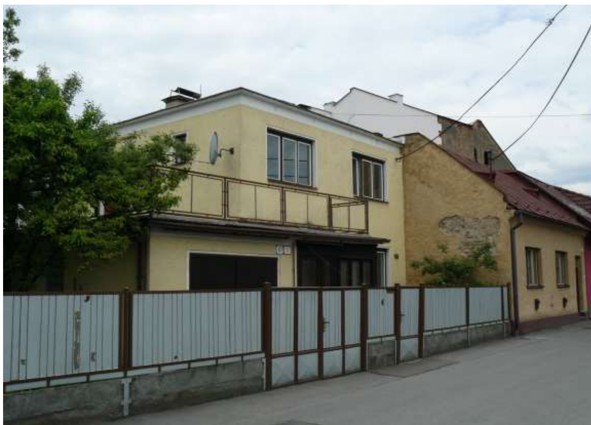
227. Zápádná strana Kollárovej ulice
