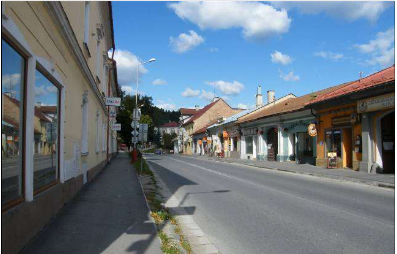
21. Pohľad na východnú zástavbu Chalupkovej ulice z Námestia M. R. Štefánika, september 2013.
