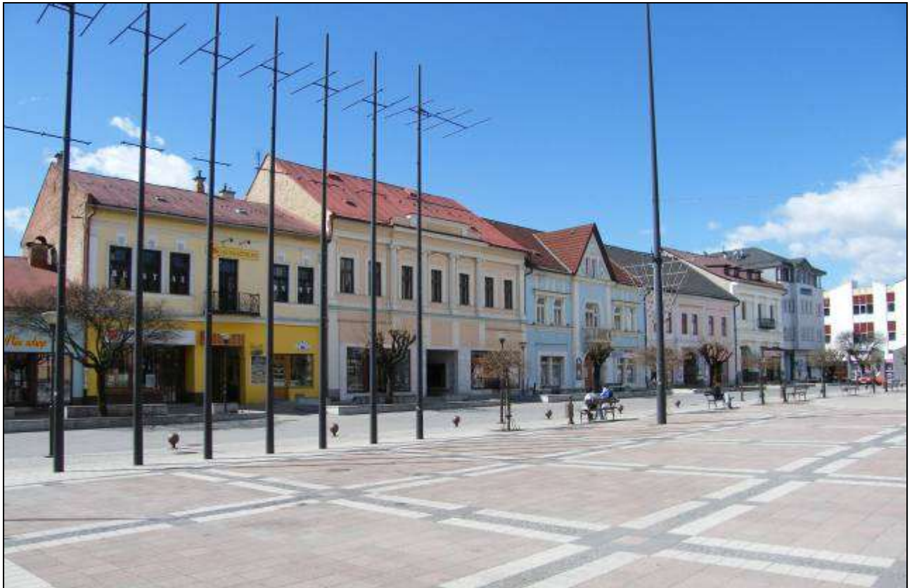
2. Južná zástavba Námestia M. R. Štefánika s domami č. 47-51, vpravo nárožná budova Slovenskej sporiteľne a Obchodný dom Jednota, apríl 2011.
