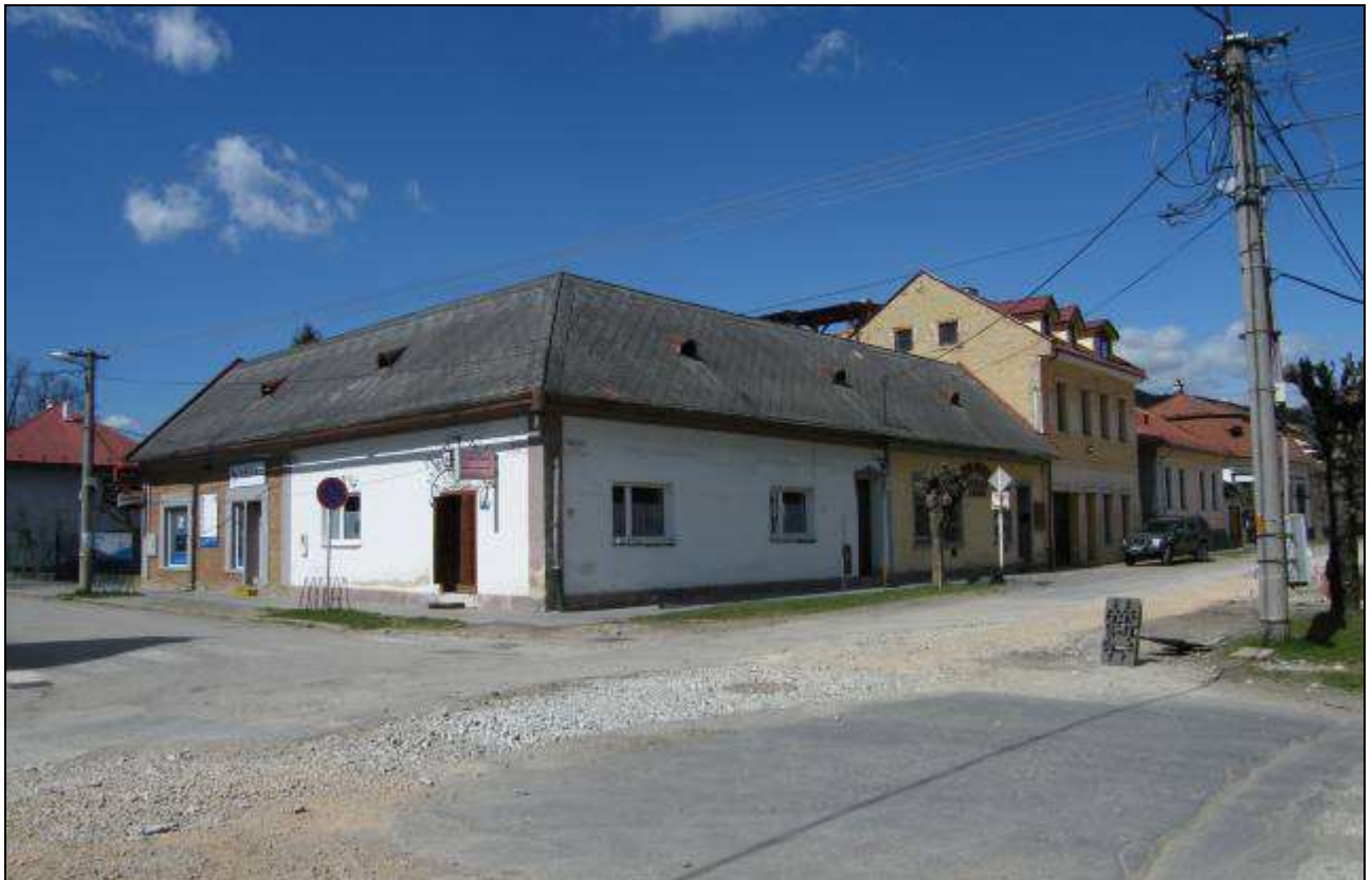
44. Zástavba severného úseku západnej strany Štúrovej ulice s nárožným domom č. 22 a domami č. 20-16, apríl 2011.
