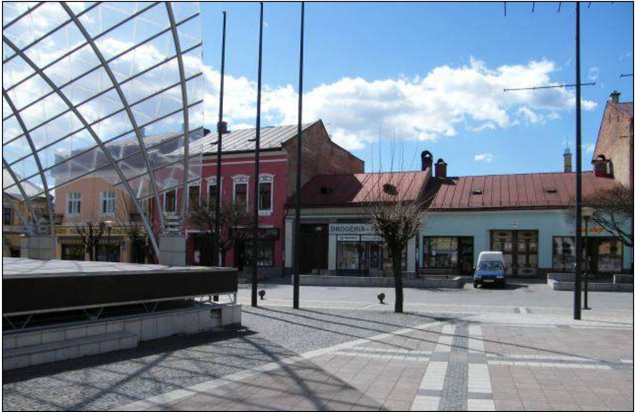
1. Východná strana južnej zástavby Námestia M. R. Štefánika s domami č. 41-46, pohľad zo severu, apríl 2011.
