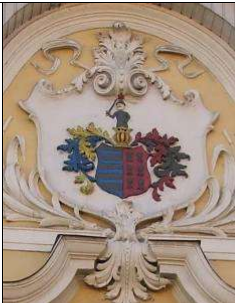
Kuzmányho 4, budova Okresného súdu
