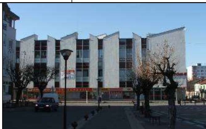
Pohľad na Obchodný dom Jednota, postavený na mieste asanovaných roľnícko-remeselníckych domov. November 2007.
