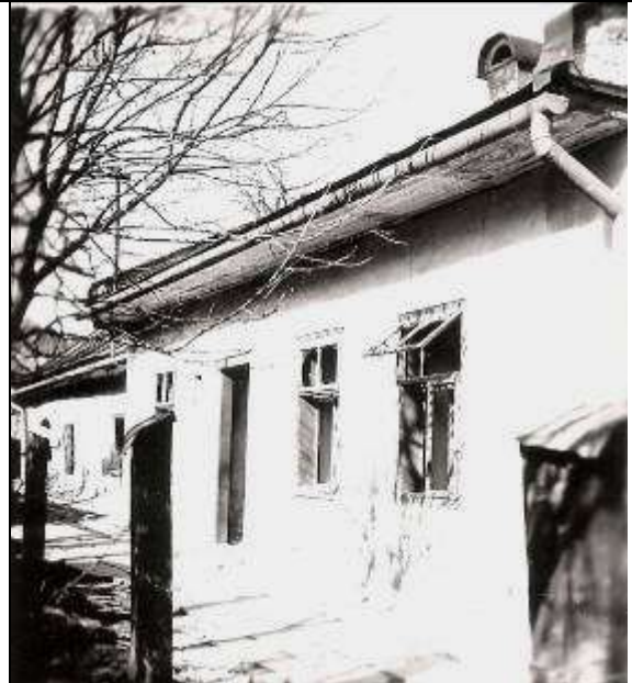
Domy na začiatku zástavby uličky. Archív KPÚ Banská Bystrica. Foto František Kiripolský, marec 1975, č. neg. 3046.
