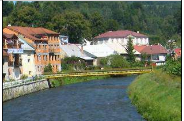
Kovová lávka do bývalého predmestia Venecia. August 2010.
