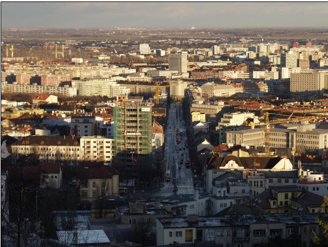
Zástavba v línii Šancovej ulice, pohľad zo Slavína, 6. 1. 2005
