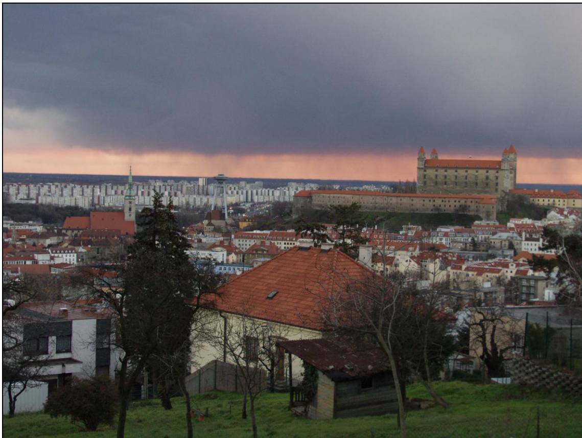
Zástavba pod Slavínom, pohľad z ulice Na Slavíne, 6. 1. 2005
