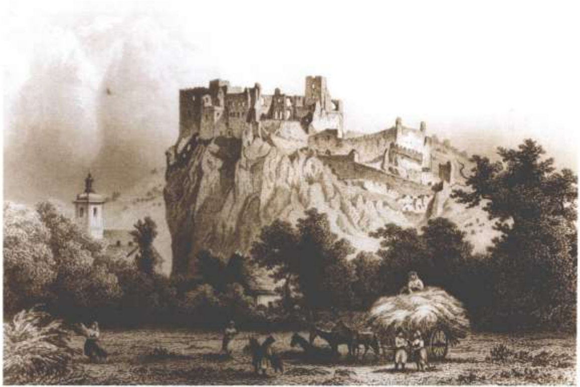
HRAD S VEŽOU FRANTIŠKÁNSKEHO KOSTOLA A ČASŤOU MESTEČKA Z JUHOZÁPADU. OČELORYTINA Z I. POL. 19. STOR., AUTOR L. ROHBOCK, REALIZOVAL J. RIEGEL. ZO ZBIEROK TM
