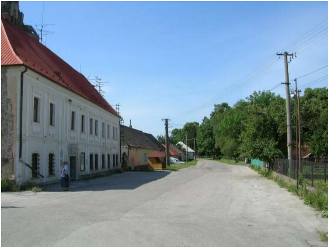
8. Východná zástavba námestia – Pohľad od kaplnky južným smerom
