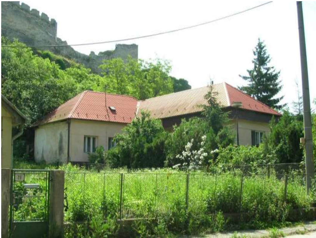
20. Východná zástavba námestia, p. č. 609/1 – Objekt č. 27, zasunutý od uličnej čary
