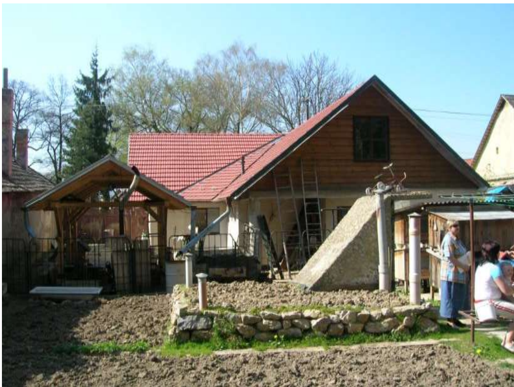
13. Východná zástavba námestia, p. č. 602 – Objekt č. 22, dvorová časť
