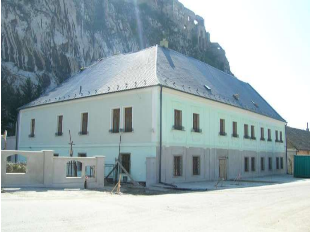
10. p. č. 598, západná zástavba námestia - Bývalý hostinec „Kollárovec 2“
