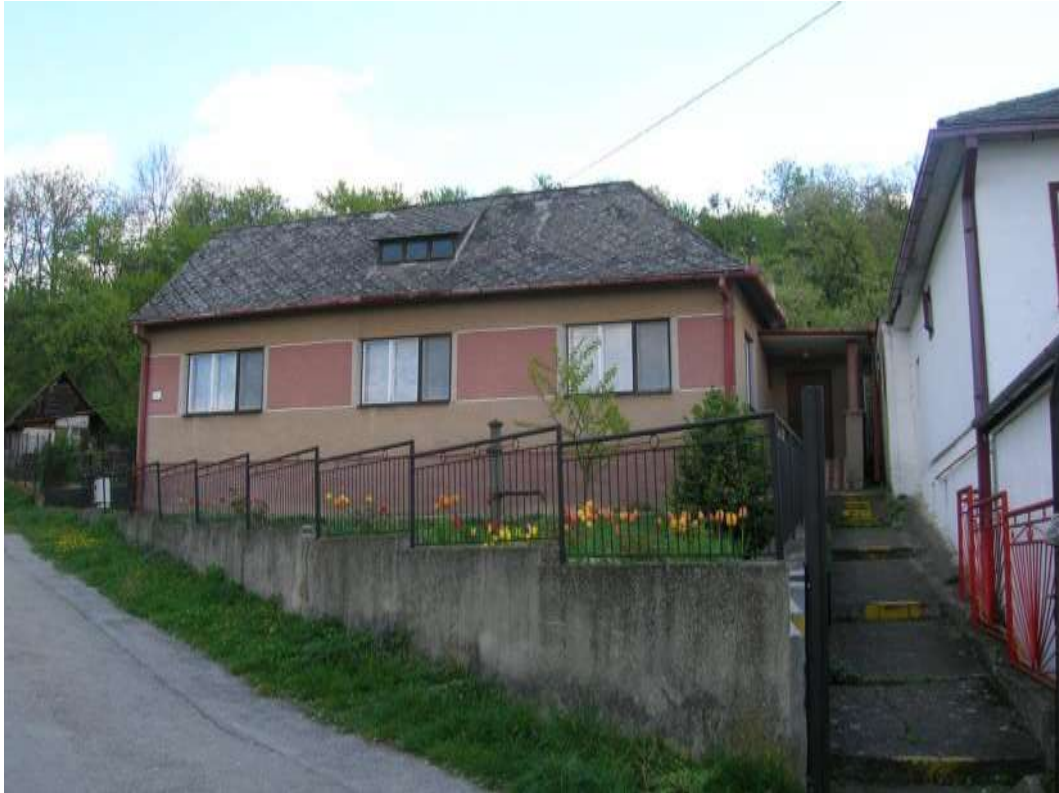
68. Hradná ulica, p. č. 388 – Objekt č. 33, rušivý
