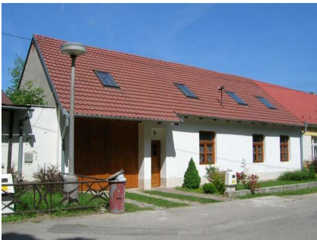
33. Západná zástavba námestia, p. č. 680/1 – Objekt č. 9, východná fasáda
