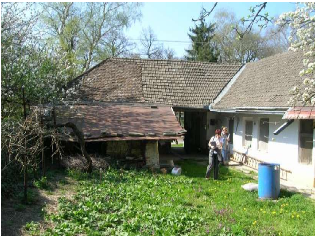
15. Východná zástavba námestia, p. č. 603/1-2 – Objekt č. 22, dvorová časť
