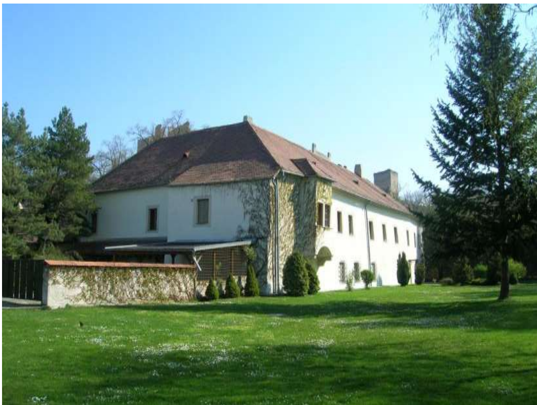
57. p. č. 626 – Objekt bývalého župného sirotinca, západná a južná fasáda
