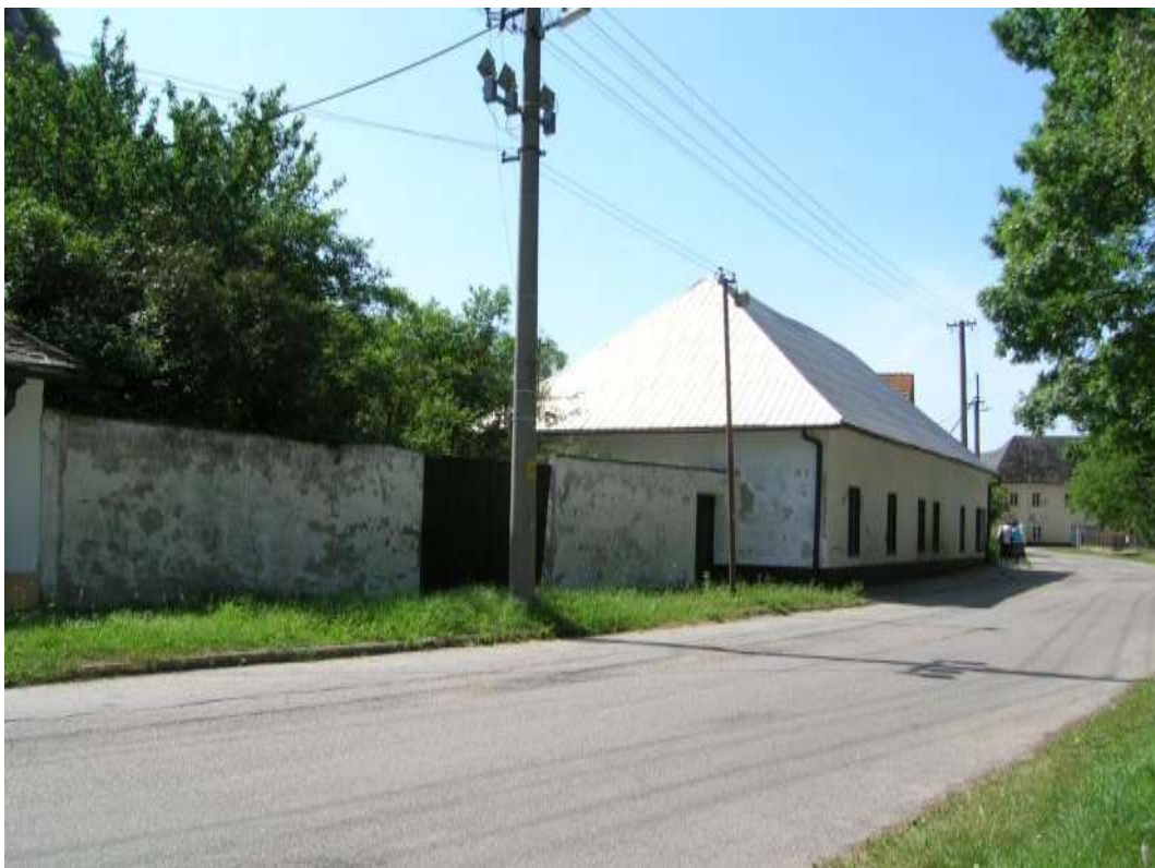
11. Východná zástavba námestia, p. č. 599 – Objekt č. 21, západná fasáda
