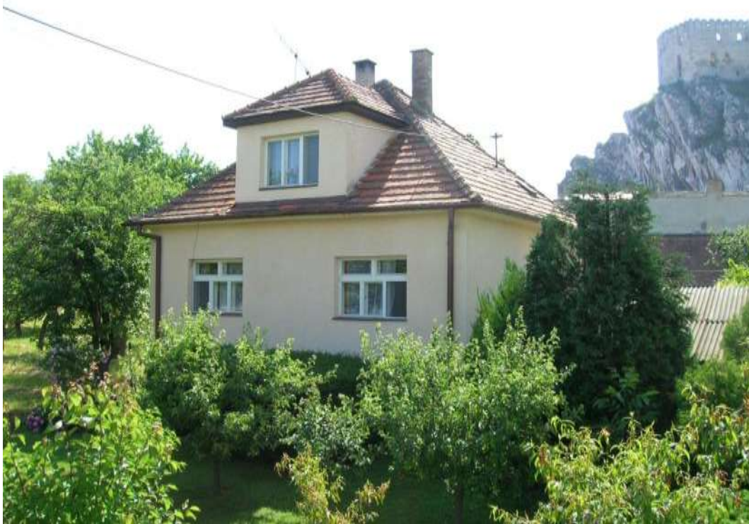
50. Severozápadná časť pamiatkovej zóny – Objekt č. 303, západná fasáda - rušivý
