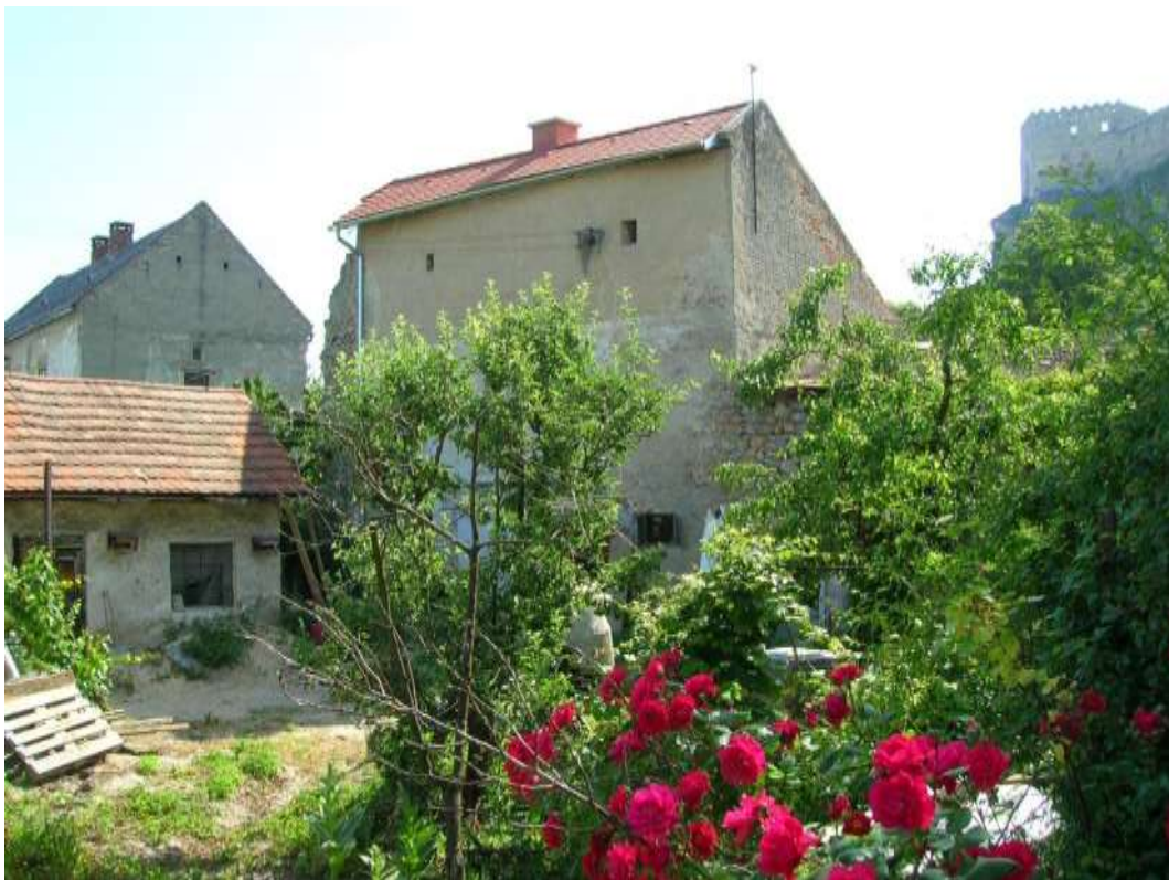
53. p. č. 680/2 – Objekt pristavaný zvnútra k mestskému opevneniu, západná fasáda
