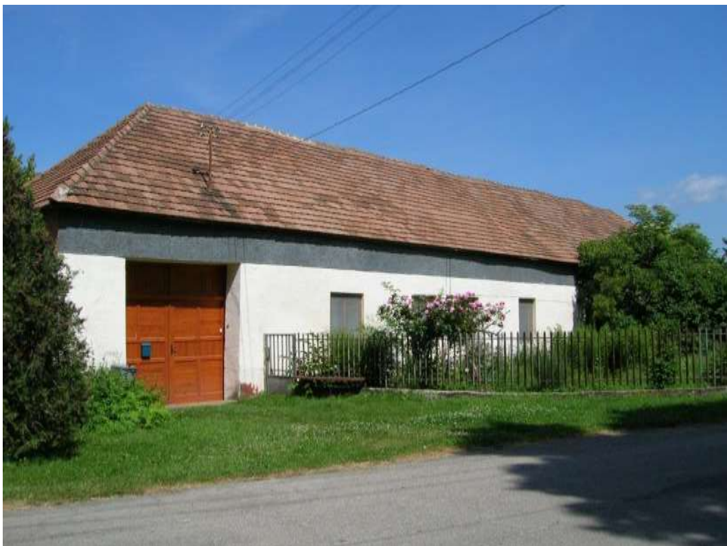
37. Západná zástavba námestia, p. č. 673 – Objekt č. 15, východná fasáda
