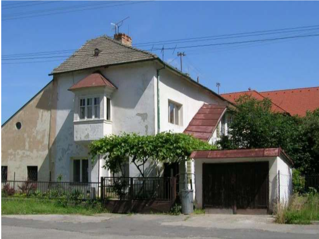
40. Severná zástavba námestia, p. č. 670/3 – Objekt č. 16, južná a východná fasáda
