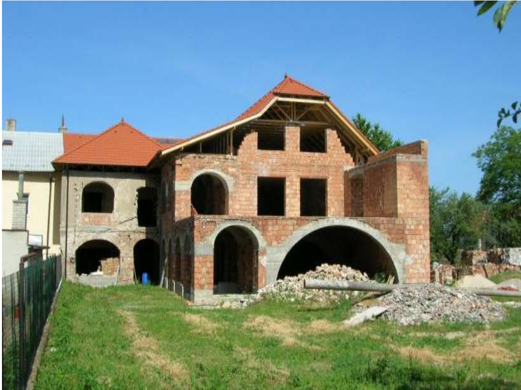
44. p. č. 670/1 – Objekt „Kollárovec 1“ východná fasáda, dostavba
