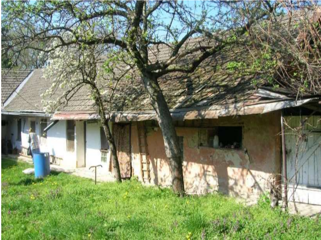
16. Východná zástavba námestia, p. č. 603/1-2 – Objekt č. 22, dvorová časť
