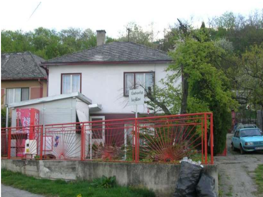
69. Hradná ulica, p. č. 3/3 – Objekt č. 34, rušivý
