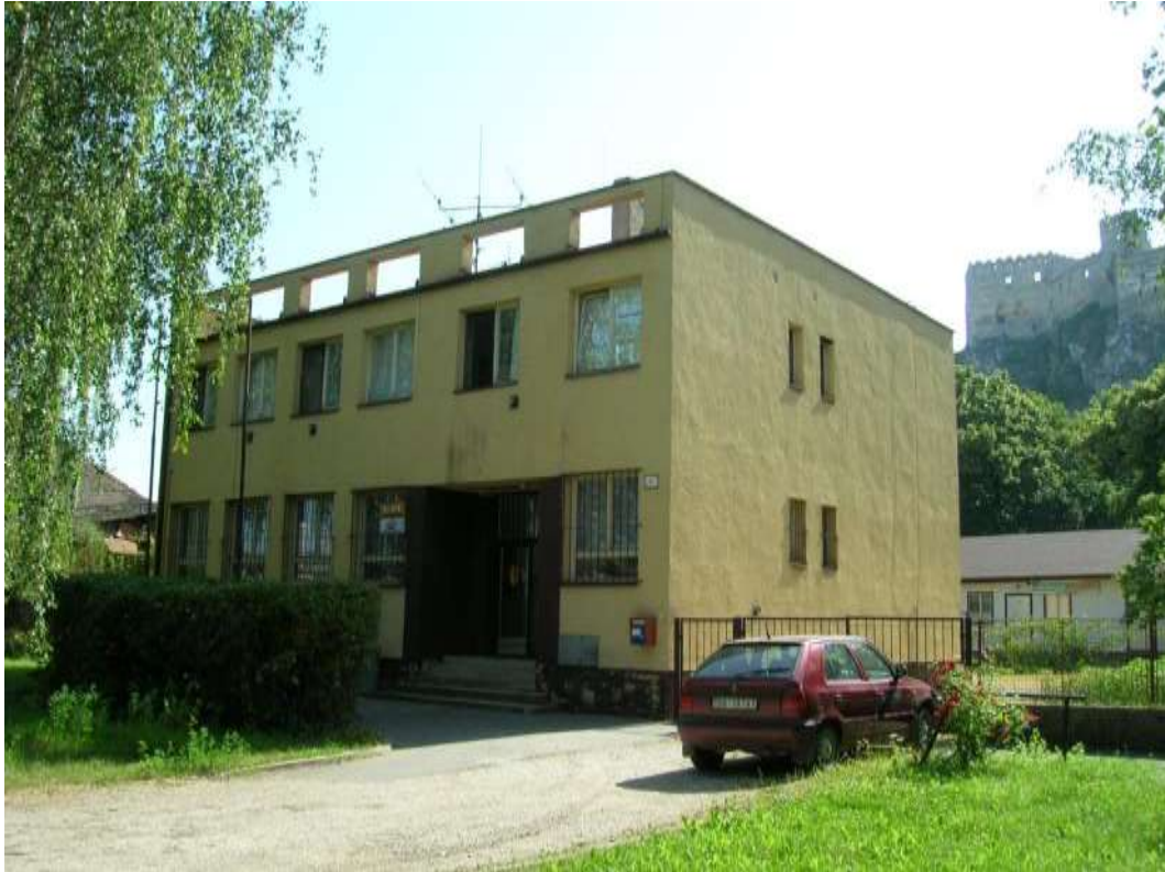
54. p. č. 681/2 – Budova pošty, západná a južná fasáda (pozemok bývalej kúrie Medňanských)
