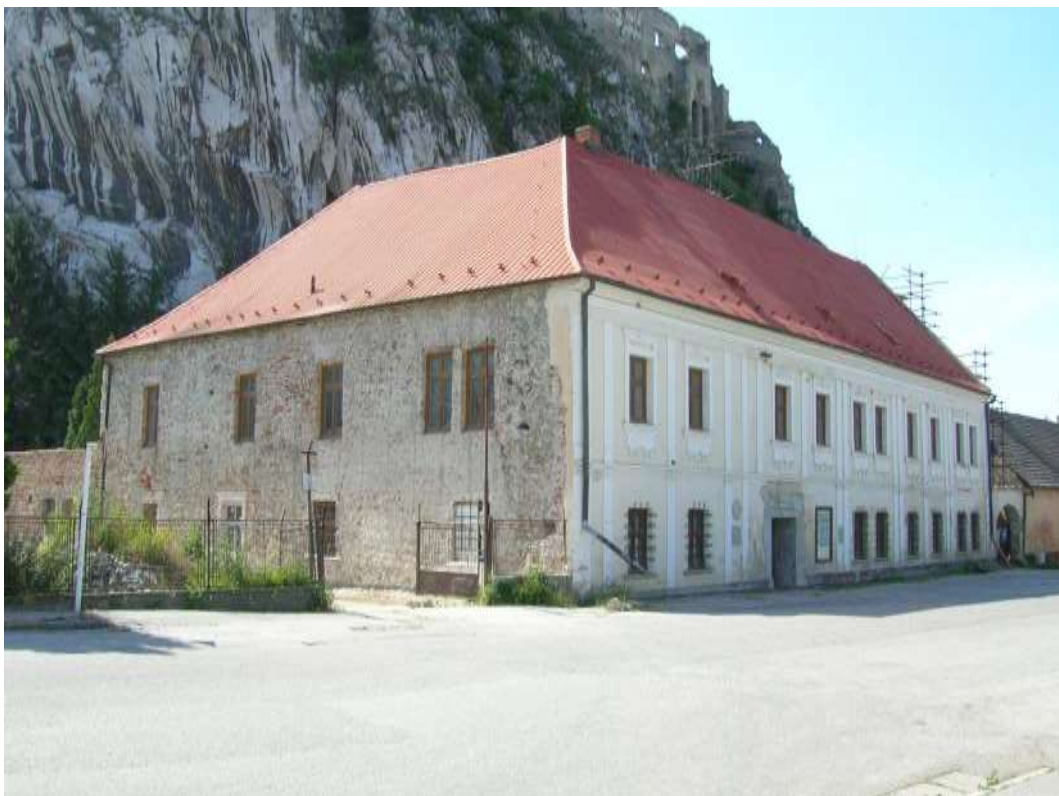
9. p. č. 598 – Bývalý hostinec „Kollárovec 2“, severná a západná fasáda
