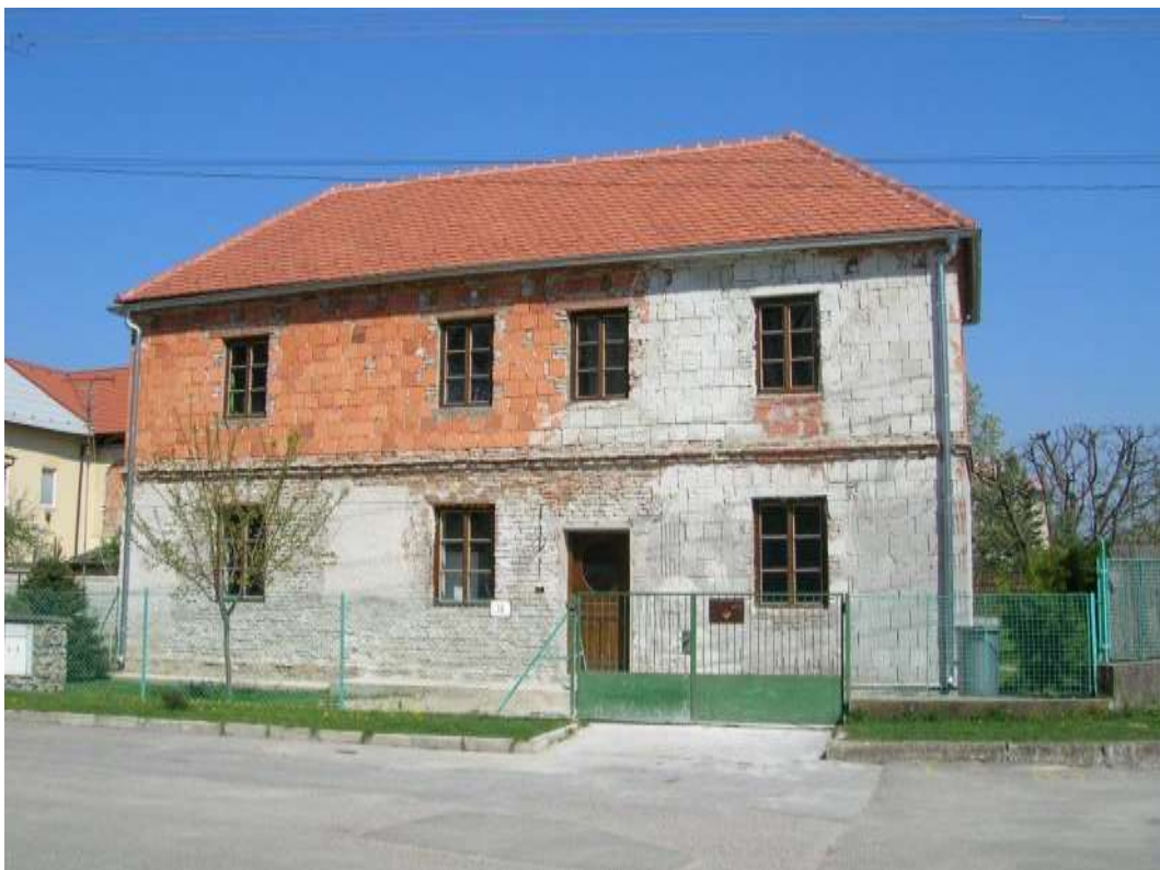
41. Severná zástavba námestia, p. č. 669/3 – Nadstavba objektu č. 18
