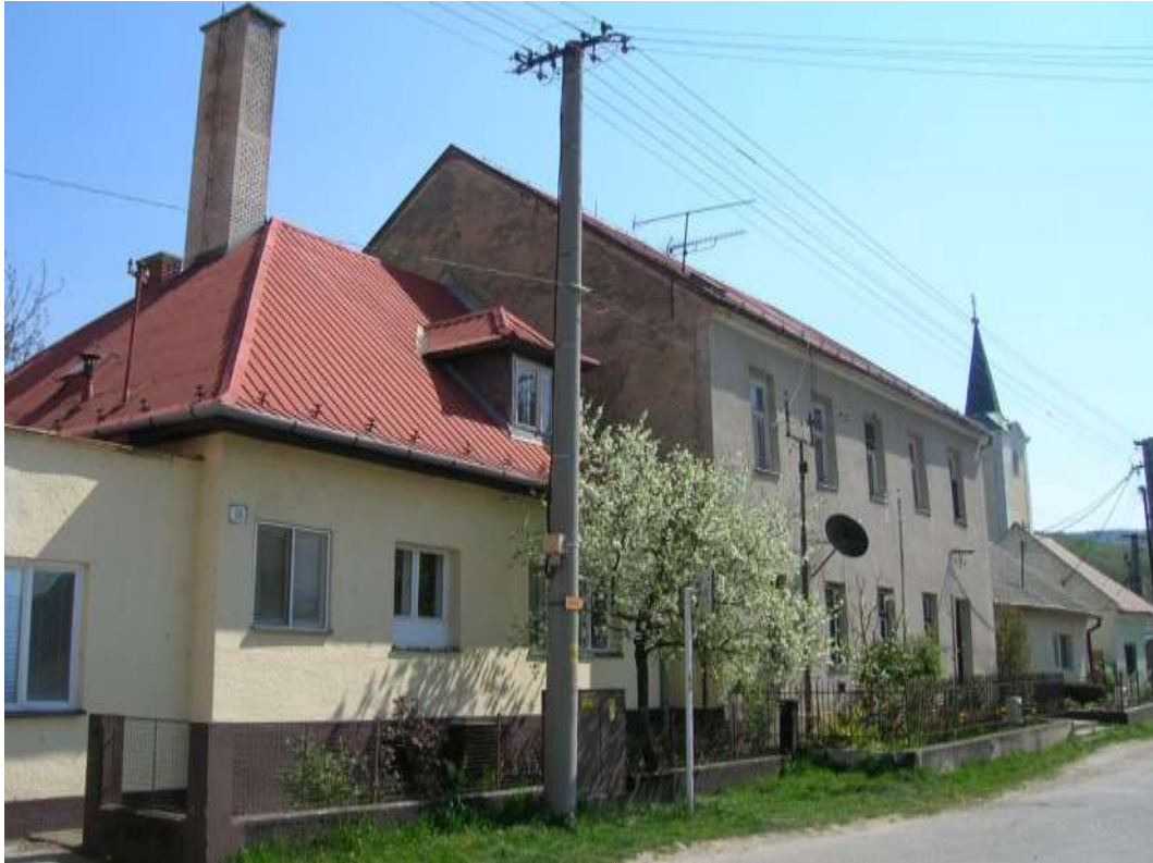
26. Východná zástavba námestia, p. č. 614, 617 – Objekty č. 29, 31, západné fasády
