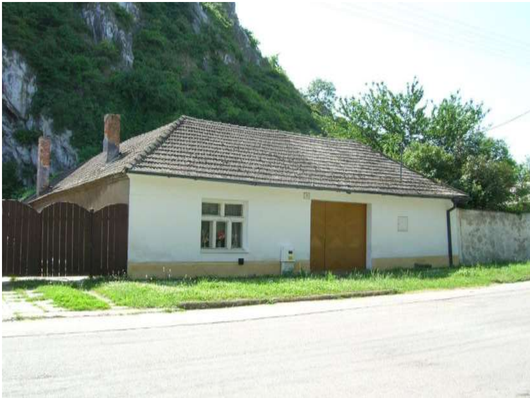
14. Východná zástavba námestia, p. č. 603/1-2 – Objekt č. 23, západná fasáda
