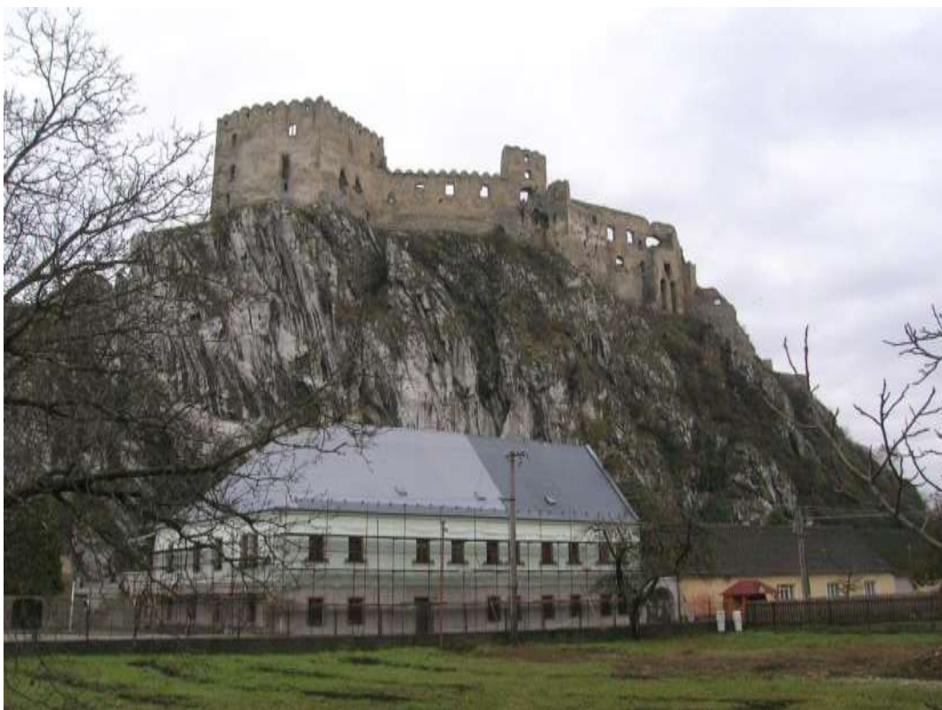
100. Pohľad zo severozápadného nárožia PZ – V popredí obnovený penzión Kúria Beckov
