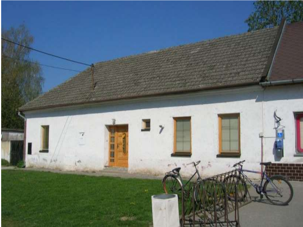
58. p. č. 622 – Objekt č., čelná, jižná fasáda
