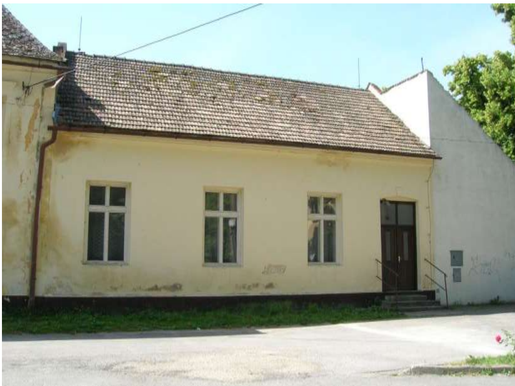
29. Južná zástavba námestia, p. č. 625 – Objekt medzi kúriou Dubnických a bývalým župným sirotincom, severná fasáda
