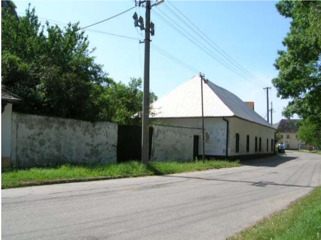
18. Východná zástavba námestia, p. č. 606 – Objekt č. 24-25 „Altusovec“ západná fasáda
