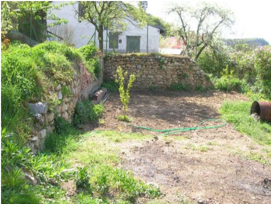
70. p. č. 4/1, hradná ul. – Asanovaný objekt staršej zástavby nad kostolom sv. Štefana
