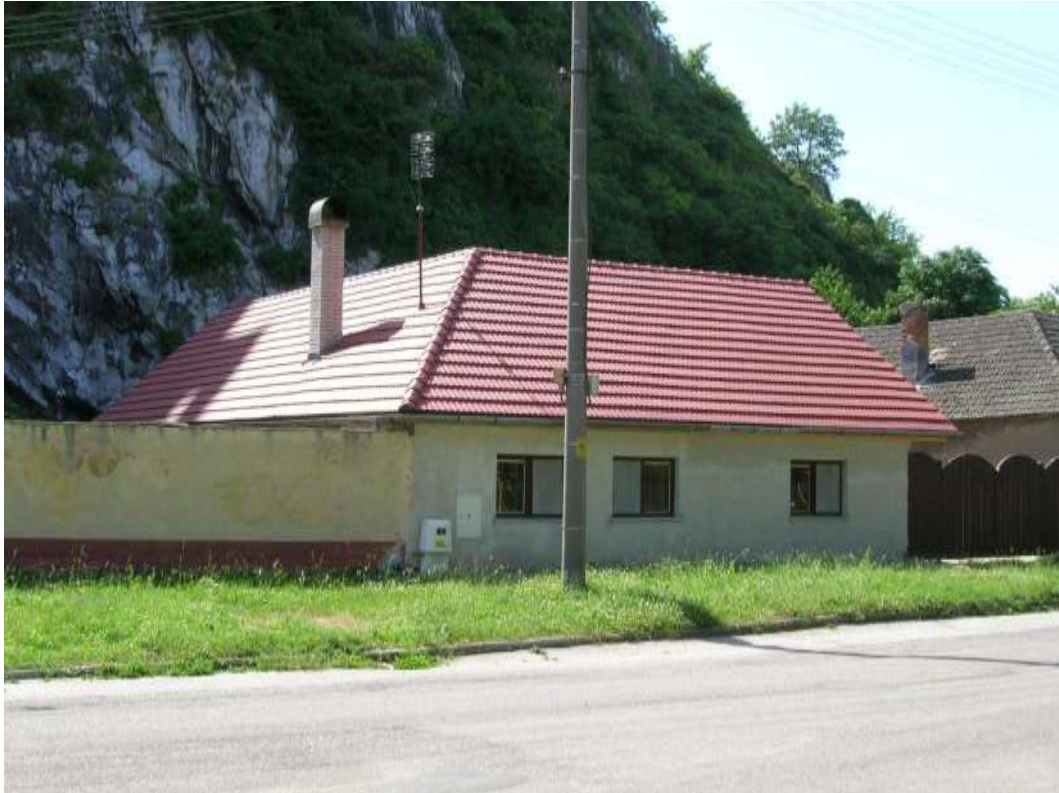
12. Východná zástavba námestia, p. č. 602 – Objekt č. 22, západná fasáda
