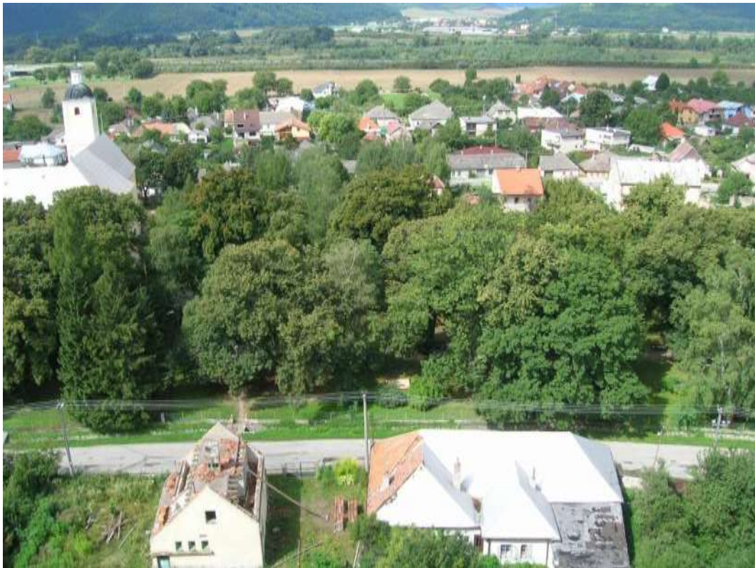
108. Zeleň dotvárajúca PZ a jednotlivé NKP – V pozadí veže kostola františkánov a komplex kláštora
