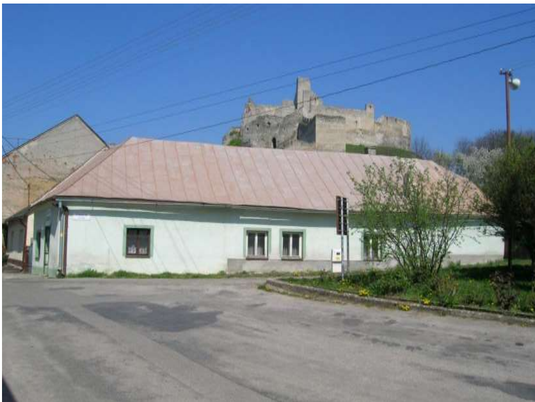
27. Východná zástavba námestia, p. č. 620 – Objekt č. 32, západná fasáda
