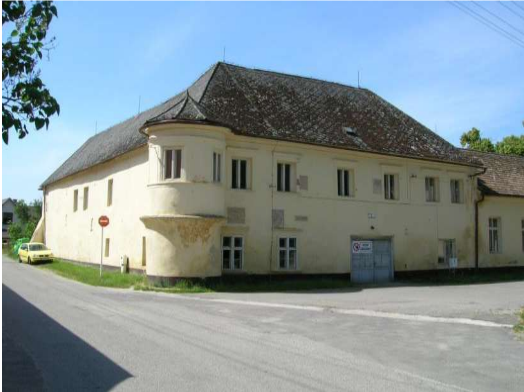
28. Južná zástavba námestia, p. č. 624 – Kúria Dubnických, severná a východná fasáda
