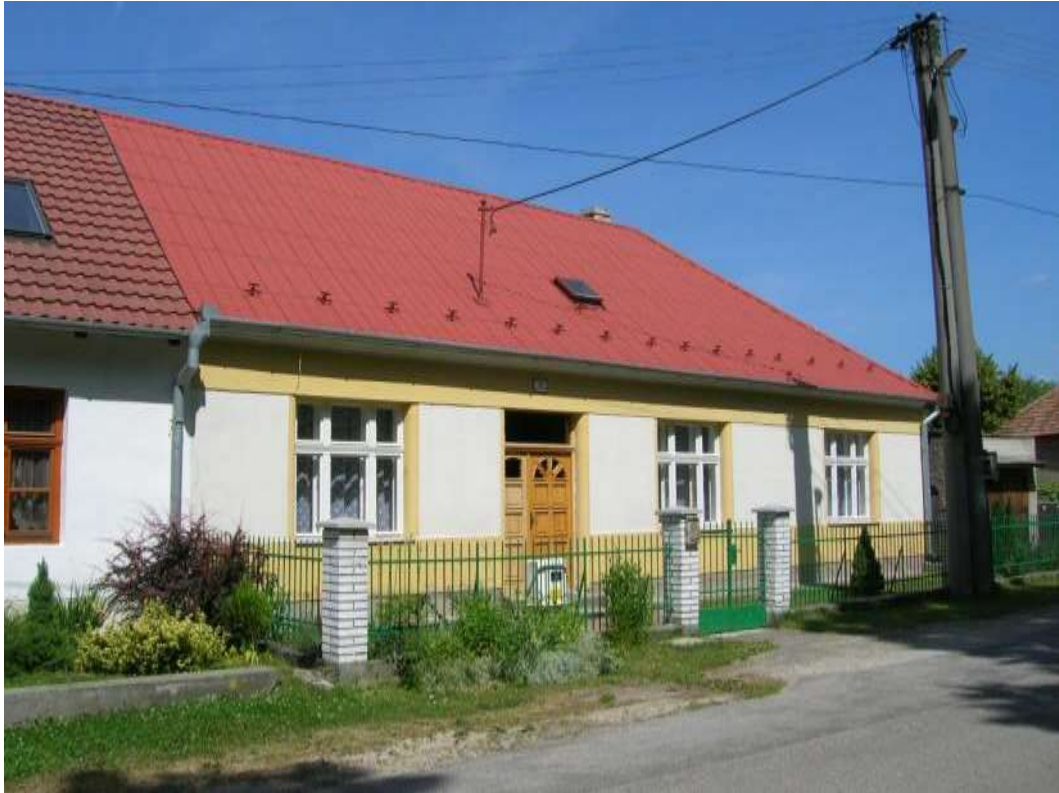
34. Západná zástavba námestia, p. č. 677 – Objekt č. 11, východná fasáda
