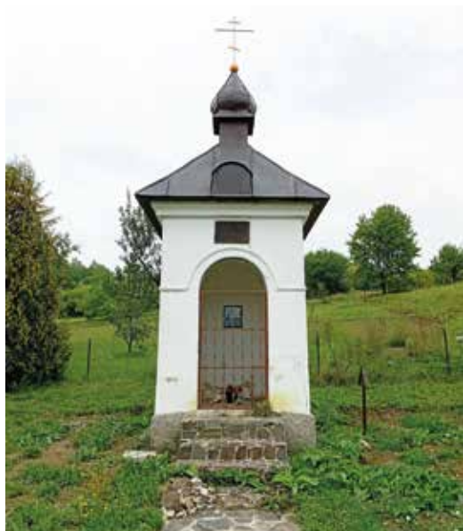
189. Cintorínska kaplnka z roku 1938 na vojnovom cintoríne v obci Ladomirová (2022) (Zdroj: Archív KPÚ Prešov, autor snímky: A. Liška)
