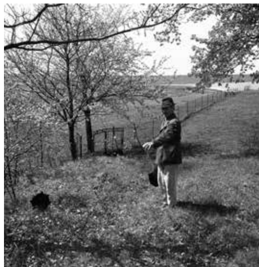
180. Vojnový cintorín v obci Kečkovce s asanovanou náhrobnou evidenčnou tabuľkou z medzivojnového obdobia (1977) (Zdroj: VHÚ – VHM – MO Svidník, autor snímky: P. Švahla)
