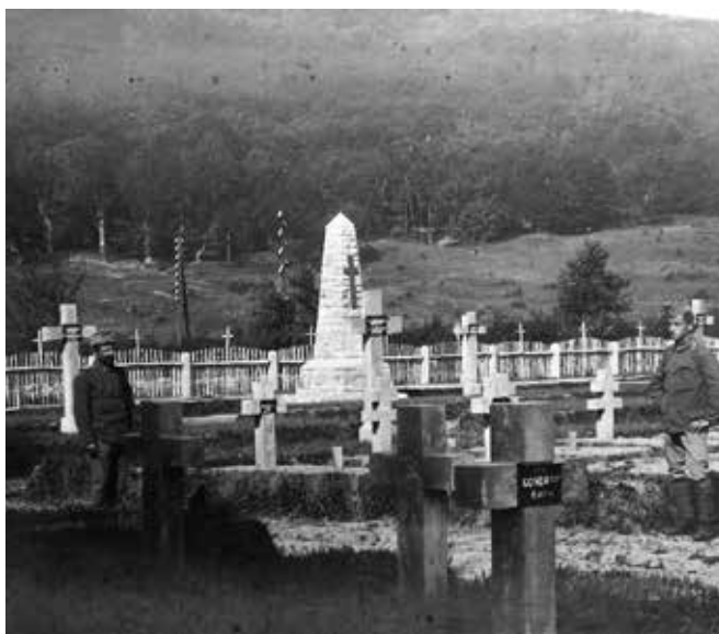
61. Vojnový cintorín Medzilaborce II. v meste Medzilaborce po konečnej úprave (Zdroj: DROBŇÁK, Vojnové cintoríny a pamätníky , 2018, c.d., s. 212.)
