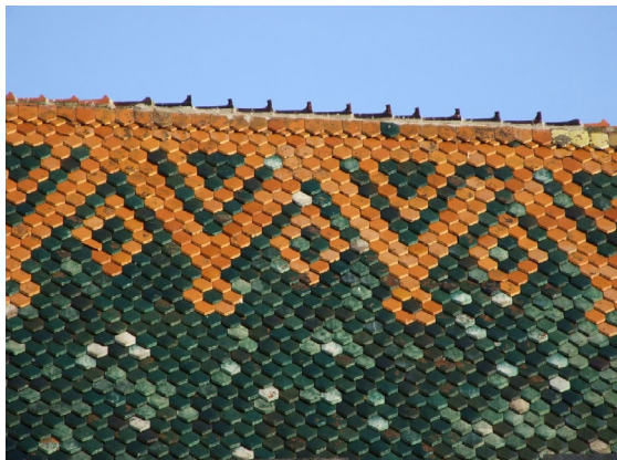
► Obr. 18. Detail glazovanej krytiny nad Huňadyho sálou, Bojnický zámok.
