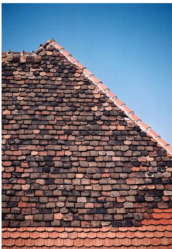
► Obr. 25. Tvarovo rôznorodé škridly na streche objektu, Kostolná ulica, Bratislava. V súčasnosti sú celoplošne nahradené novou betónovou škridlou.
