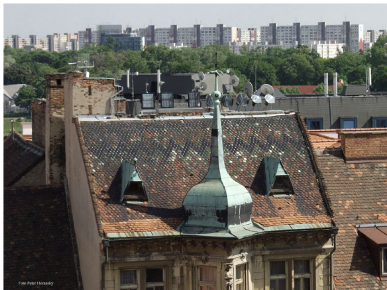
► Obr. 19. Časť strechy s pôvodnou glazovanou krytinou z roku 1904, dom u Salvátora, Panská 35, Bratislava.
