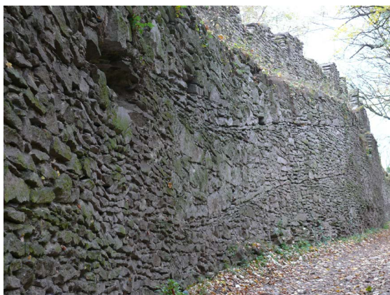
► Obr. 2. Precízne riadkované kamenné murivo z lomového kameňa.
