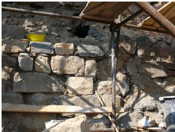
► Obr. 25. Doplnenie riadkovaného muríva. Hrad Filákov, 2007.
