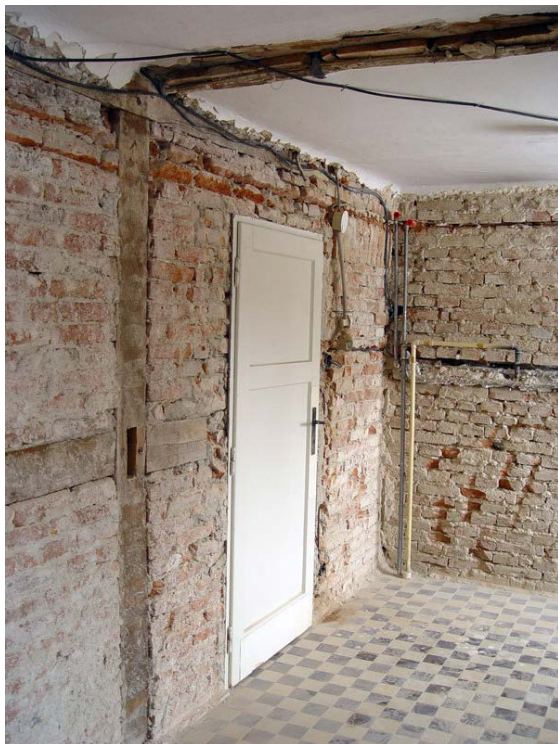
► Obr. 14. Hrazdená konštrukcia kapucínskeho kláštora, Pezínok.
