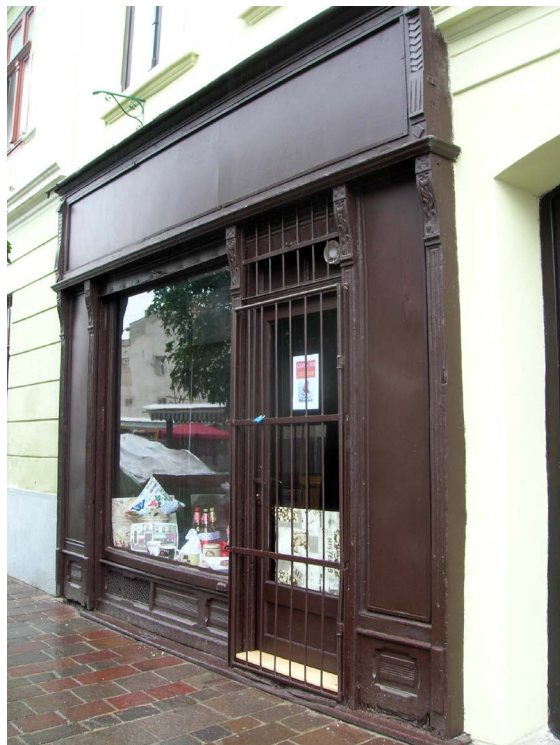
► Obr. 4. Typ predsadeného výkladu, Dominikánske námestie 11, Košice.
