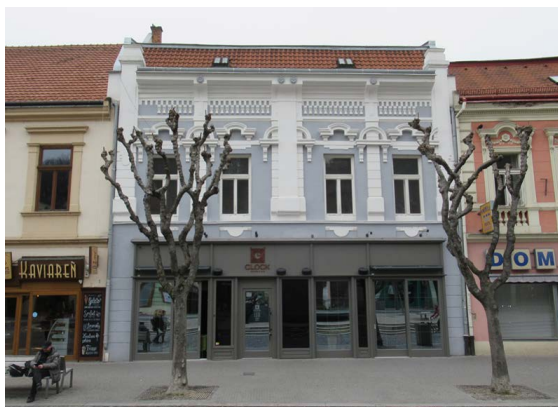
► Obr. 24. Meštiansky dom po obnove, Mierové námestie 15, Trenčín.
