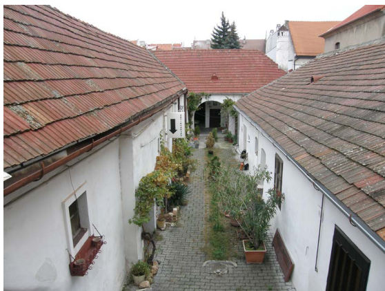
► Obr. 16. Vinohradnícky dom, Holubyho 27 – Potočná 1, pohľad do dvora, Pezínok.
