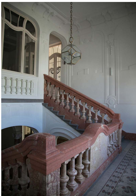
► Obr. 27. Rosenfeldov palác, komplexná obnova schodiska, Hurbanova 28, Žilina.
