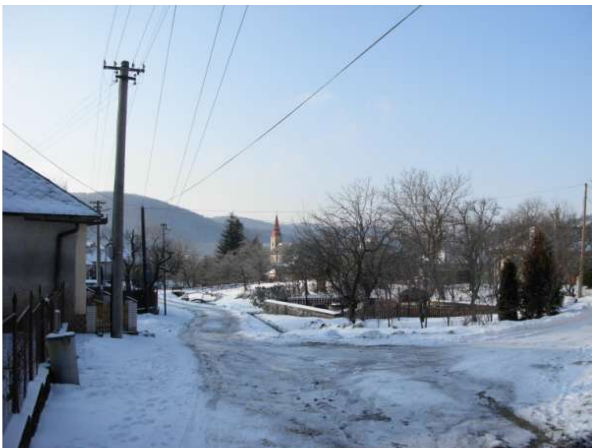
Vzdušný rozvod elektriny a telekomunikačné káble narúšajú vzhľad pamiatkového územia.
