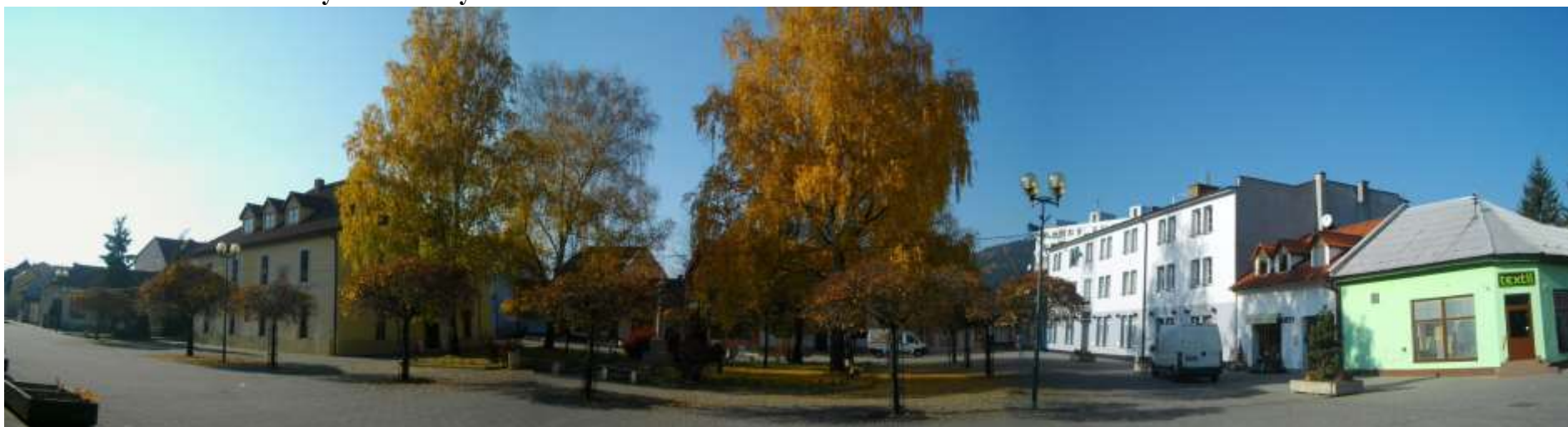
Pohľad na Námestie Slobody zo severovýchodu
