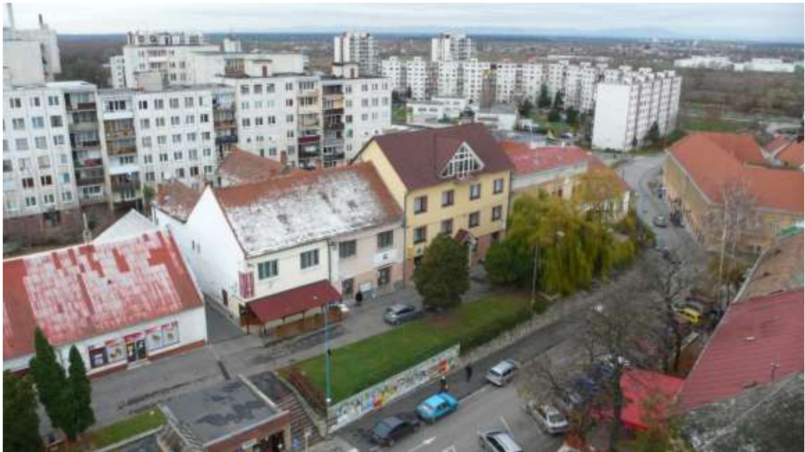
9. Pohľad na západný blok zástavby južnej strany námestia (archív KPU TT)
